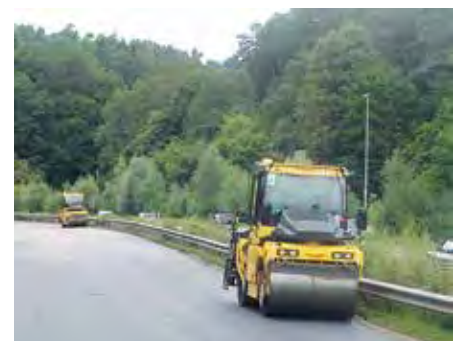
Bomag setzte drei Tandemwalzen mit der GPS-Ausstattung „Bomag Starfire“ ein.
