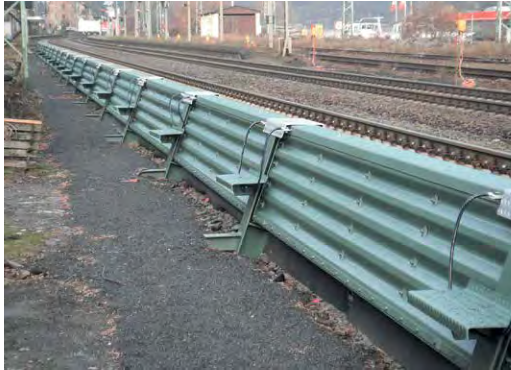
Die neue, unmittelbar an den Gleisen verlaufende niedrige Lärmschutzwand fängt viele Rollgeräusche von Zügen ein.
