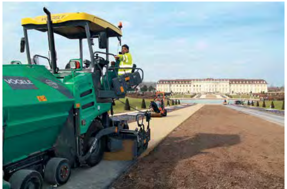
Vögele „Strich 3“-Fertiger Super 1303-3i gestaltet Farbasphaltflächen im Schlosspark Ludwigsburg.
