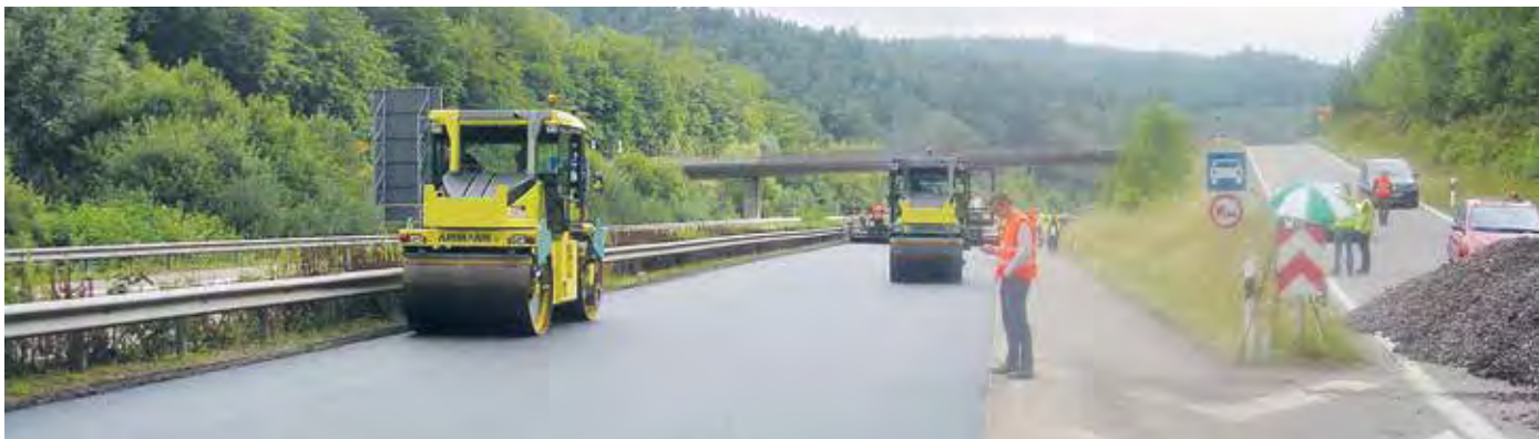
Von den vier Ammann-Tandemwalzen kamen drei zum Einsatz, die vierte wurde gemäß Bauvertrag als Stand-by-Walze vorgehalten.
