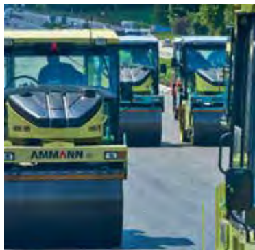
Bei der Sanierung eines Teilstückes der Autobahn A7 zwischen Memmingen und Ulm wurden ausschließlich Walzen aus dem Hause Ammann eingesetzt.
