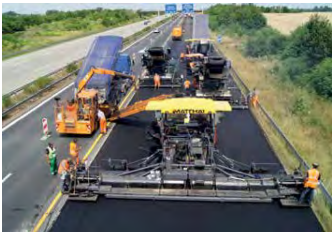
Beim zweiten Einsatz betrug die Einbau-Breite 10,50 Meter. Auch hier erfasste der Sensor die komplette Breite während des gesamten Projekts.
