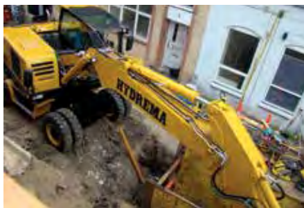
Der neue MX-Mobilbagger von Hydrema macht auch auf engen Baustellen eine gute Figur. (Foto: Hydrema)
