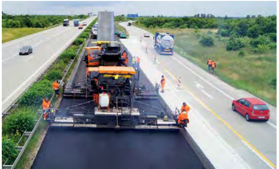
Mit dem PAVE-IR System wurde beim ersten Einsatz der Autobahnsanierung die Temperatur des Asphalts über die komplette Einbaubreite von 8,50 Metern erfasst.
