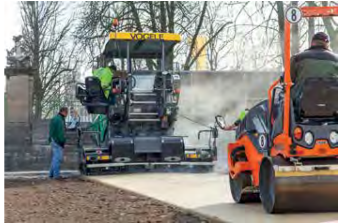
Die neue AB 340 TV fertigte ein perfektes Dachprofil mit zwei Prozent Neigung. (Fotos: Vögele)
