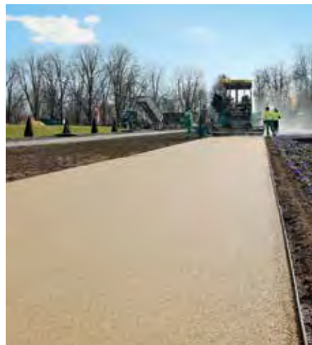
Der makellose Farbasphalt fügt sich perfekt ins barocke Ensemble ein.
