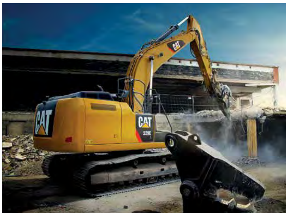
Mit den je nach Anforderung auswechselbaren Backen sind die Universalscheren der Baureihe MP300 hochflexible und leistungsstarke Anbaugeräte für fast alle Bagger von Caterpillar.
