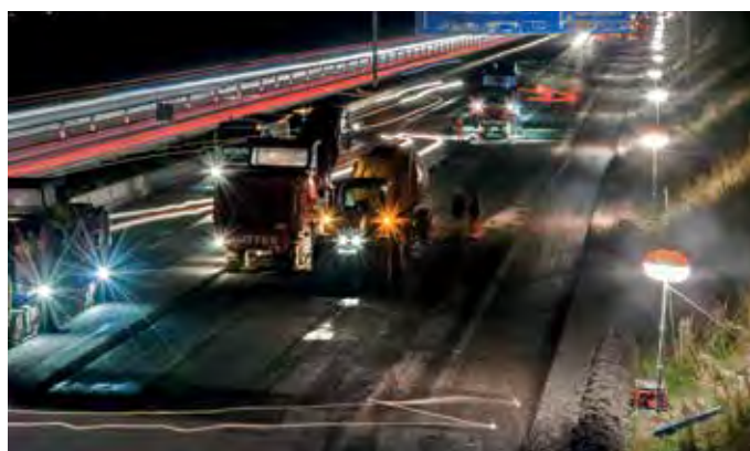
Fräsen, abtransportieren, kühlen, reinigen: Alle Arbeitsschritte mussten perfekt aufeinander abgestimmt sein. Die Arbeiten erfolgten unter Hochdruck im 24-Stunden-Schichtbetrieb. (Fotos: Zeppelin Rental)
