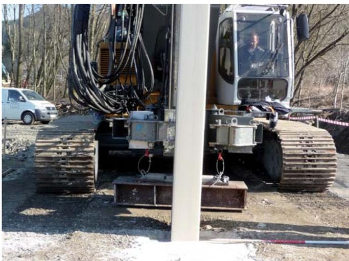
**Die 22 m langen** Stahlträger wurden in 15 bis 20 Minuten eingerüttelt.
