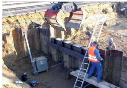
wurden auf Länge geschnitten und mit den vorgefertigten Kopfträgern, die die Behelfsbrücke aufnehmen, verschweißt. (kleine Fotos: Kassecker)
