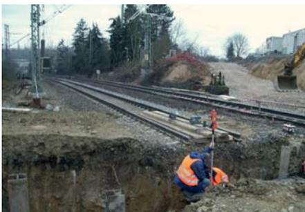
**Unter beengten Verhältnissen** und oft in Zwangslage müssen die Schweißarbeiten ausgeführt werden. Die gerammten Träger bzw. Spundwände
