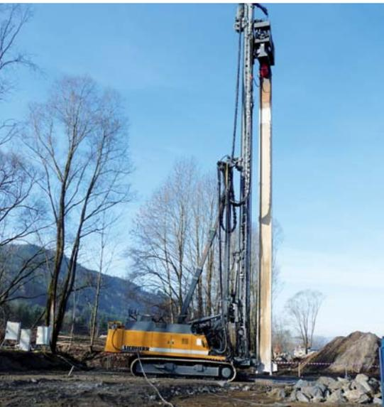
**Für die Schmalwandarbeiten** in der Steiermark kamen ein Liebherr-Ramm- und Bohrgerät vom Typ LRB 255 zum Einsatz. (Fotos: Liebherr)
