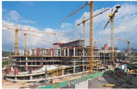
**Zum Lastabtrag** über mehrere Stockwerke hinweg wird Peri up als Stützturm und im räumlichen Verbund bis zu 13,80 m Höhe montiert. (Fotos: Peri)
