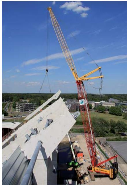
**Vereinfachtes Handling**, schnellere Aufbauzeiten: ein Liebherr Hydroseilbagger mit Haltestangen aus Kohlefasern.
