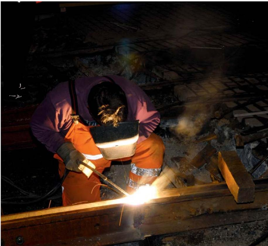
**Während der Baumaßnahme** erfolgt die Abnahme der Schweißarbeiten durch den leitenden Schweißfachingenieur des Unternehmens und einem Fachmann der Deutschen Bahn AG.
