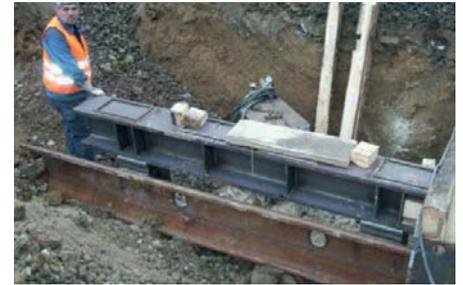
Ein quer geschweißtes Auffangblech oder eine einzelne Spundbohle sichert den Boden hinter dem Kopfträger. Dies ist notwendig, weil sofort im Anschluss Züge über die Behelfsbrücke fahren werden und der Straßenverkehr auf der anderen Seite unter der Behelfsbrücke schon wieder rollt, während Baufahrzeuge und Bauarbeiter die erforderlichen Arbeiten verrichten müssen.
