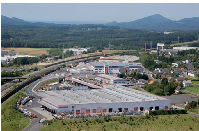
Das Endmontagewerk, hier im Vordergrund, wurde 2006 errichtet. Im hinteren Werksgelände entsteht die Montagehalle für den Sondermaschinenbau. (Fotos: Wirtgen)
