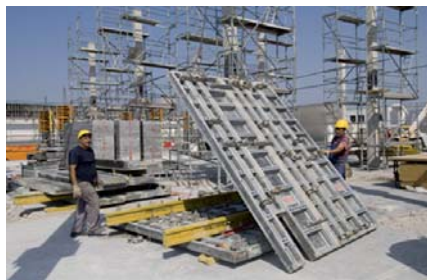
Ein Beispiel aus der Praxis: Aufstellen des Schalelementes mit einem Kran.
