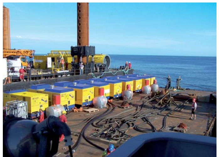
Während der über 6-stündigen Rammung waren die „Luftpumpen“ im Dauereinsatz und erzeugten den Schutzschleier gegen die Schallemissionen. (Fotos: CompAir)
