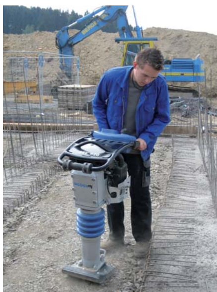
Der Vibrationsstamper SRV 620 erzielt mit seinem 2,5-kW-Motor eine hohe Stampfleistung. (Fotos: Weber MT)
