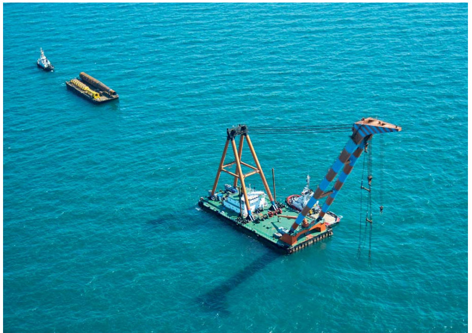
Auf dem Weg zur Baustelle: Der Schwimmkran wurde zur senkrechten Aufstellung des Monopiles benötigt.
