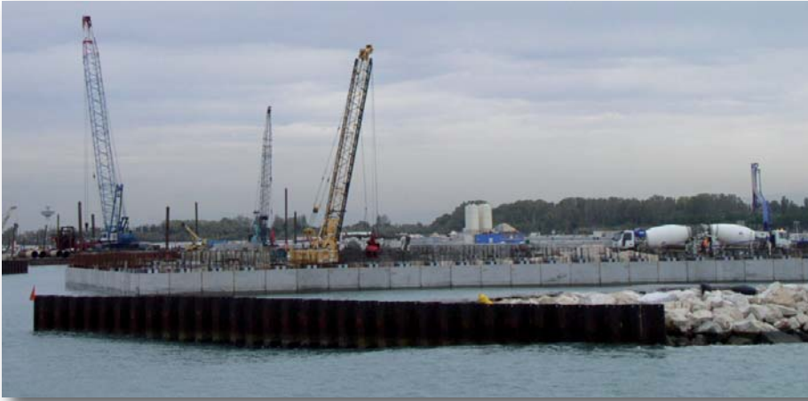
MOSE-Hochwasserschutz von Venedig – Umweltschutz und Spezialtiefbau.
