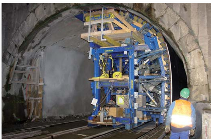
Auf einem Wagen waren die Schalungen mit Außenvibratoren montiert.
