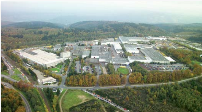
Auf einem weitläufigen Areal im rheinland-pfälzischen Boppard produziert die Bomag GmbH Verdichtungsmaschinen und -geräte für die Erd-, Asphalt- und Müllverdichtung sowie Stabilisierer/Recycler.
