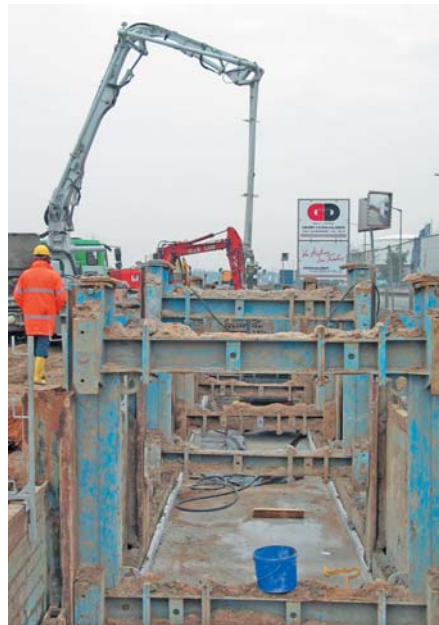
Mit den insgesamt 16 Modulen des Verbausystems, die auf der Baustelle vorgehalten wurden, betonierte man in technologischen Abschnitten von jeweils 8 m.
