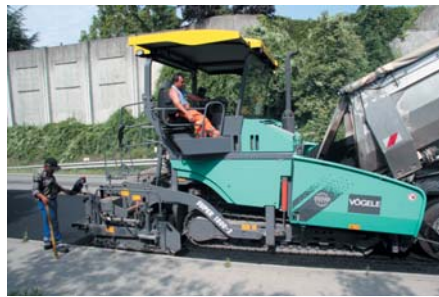
Der neue Mittelklassefertiger Super 1800-2 kann unterschiedliche Aufgaben lösen, vor allem aber den Bedienern die Arbeit noch einfacher machen und hochwertige Asphaltdecken einbauen. (Foto: Vögele)
