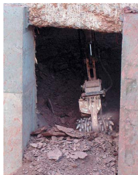
Mit einer Breite von knapp 600 mm lässt sich die Anbaufräse beim Unterfräsen von Grundmauern präzise führen. (Fotos: Terex Schaeff)
