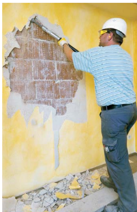
Gegenüber Elektrohämmern weisen die Vogt-Putzplanen oft eine 5-fach höhere Flächenleistung auf. (Fotos: Vogt Baugeräte)
