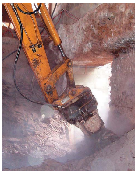
Die WS 15 arbeitet mit einer Meißelkraft von maximal 26,6 kN, die Nennantriebsleistung beträgt bis zu 22 kW.
