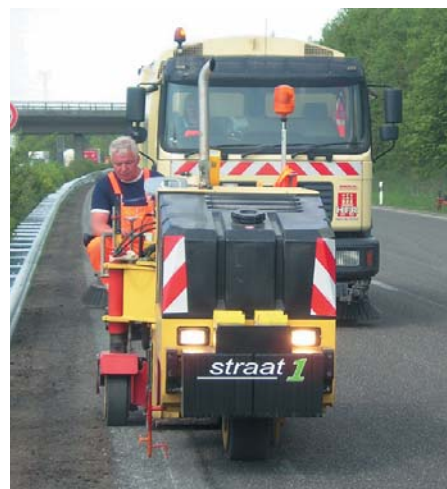
Hier fräst die DYNAPAC Kaltfräse PL 350 S die Splittspitzen im Gussasphalt ab.
