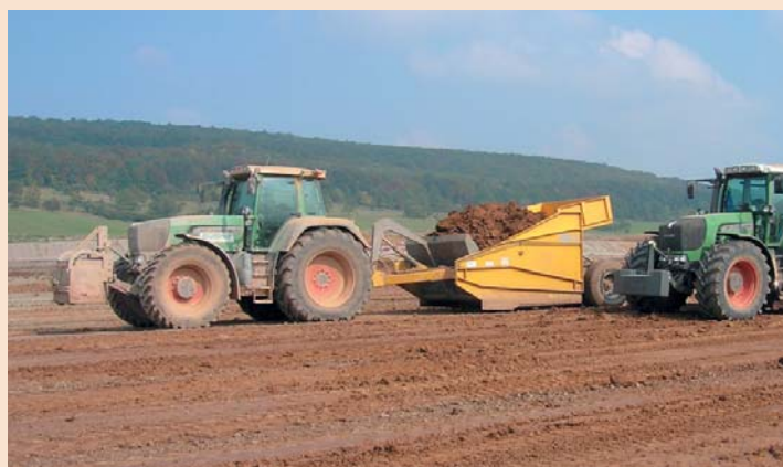
In einem Arbeitsgang fassten die zwei Schürfkübel vom Typ SASK 9 zusammen 24 m 3 Erde – und das in 20 Sekunden. (Foto: Stehr)
