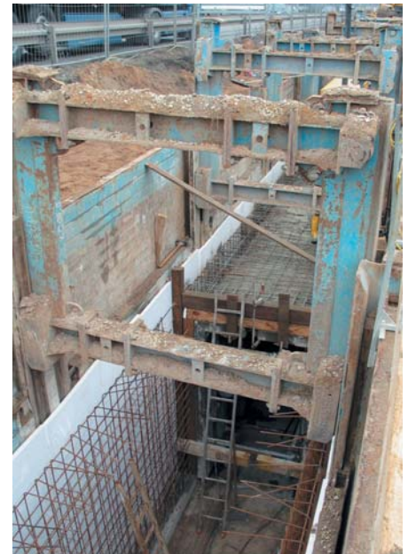
Sobald die Sohle betoniert worden war, konnten die Laufwagen entsprechend nach oben gezogen werden. So entstand Platz für den Schalwagen. (Fotos: Emunds+Staudinger)
