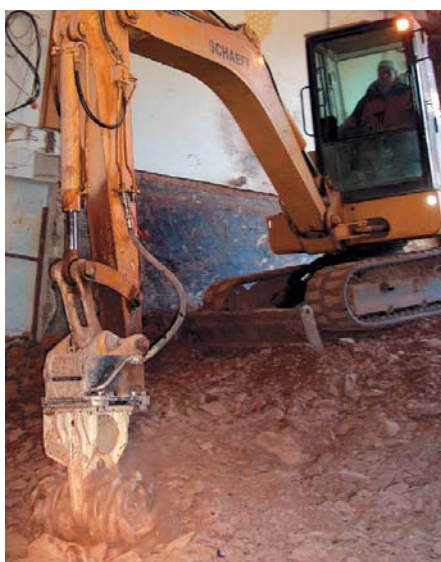
Rund 50 m 3 harten Schieferfels fräste der Raupenbagger HR 18 mit der hydraulischen Anbaufräse WS 15 aus dem Untergrund.
