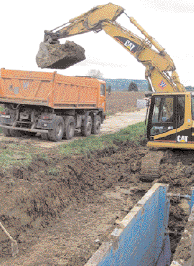
Die Baustraße nimmt die erforderlichen Belastungen auf, die durch den Baustellenverkehr mit Ladern, Baggern sowie Lkws entstehen.
