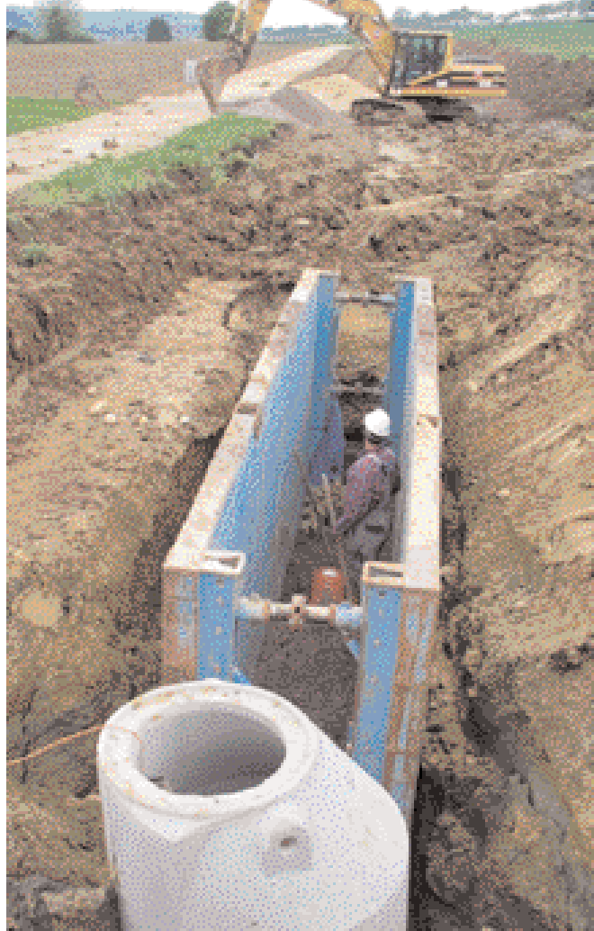
Neben den Baustraßenelementen sind ebenfalls Verbaumodule von E+S bei den Tiefbauarbeiten für Sammler und Fernwärmeleitung im Einsatz.
