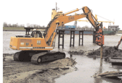
Alte und deshalb oft morsche Holzpfähle lassen sich mit einer Seitengriff-ramme ziehen.
