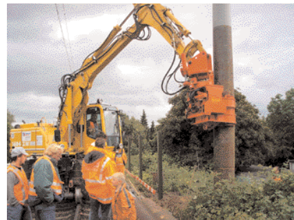
Vom Gleis aus erfolgt das Einrammen der Gründungsrohre schnell und unkompliziert.
