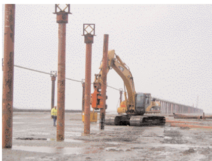
Im Wattenmeer wurden mit einer Seitengriff-ramme 500 Stahlrohre für eine Pipeline einge-rammt.
