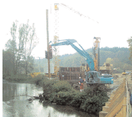
Selbst Holzpfähle sind für die Ramme mit Sei- tengriff kein Problem.
