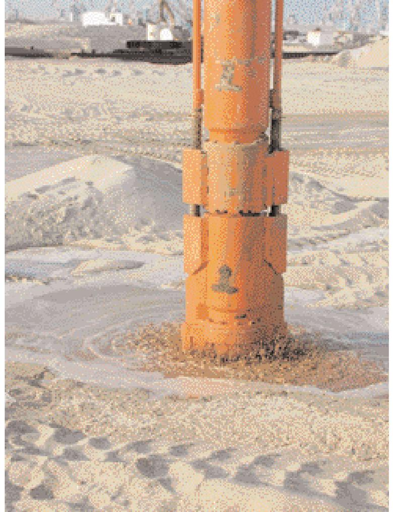
gewährleisten, hat Feko zusätzlich ein elektronisches Messsystem entwickelt, welches die Qualität der Verdichtung gewährleistet und die nachträgliche Kontrolle der ausgeführten Verdichtung ermöglicht. Durch einzelne Messgeräte werden in den vorgeschriebenen und voreinstellbaren Intervallen Eindringtiefe, Hydrauliköldruck, Zeit und gelegentlich
