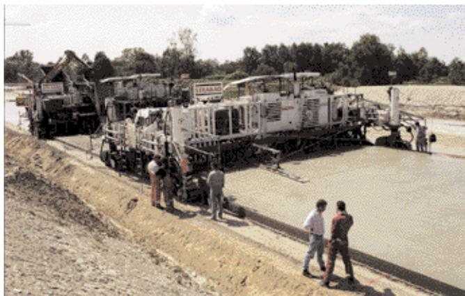
Eingebaut wird eine 11,5 m breite Betondecke mit 27 bis 28 cm Dicke.
