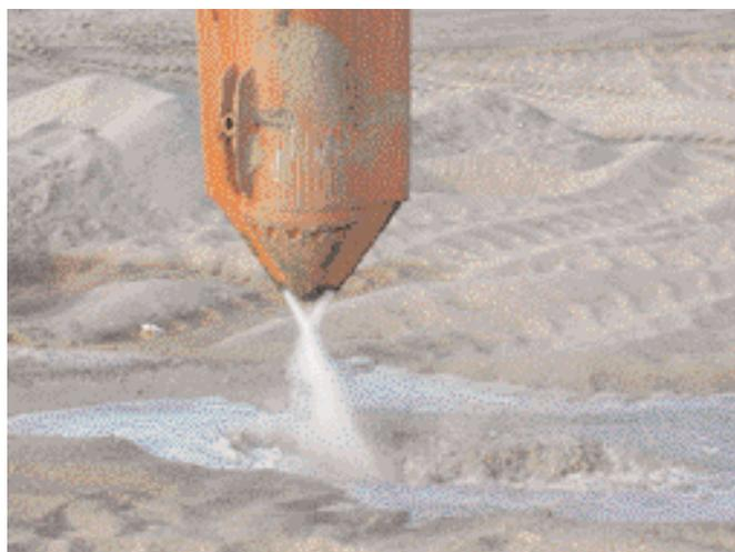
Aus Düsen am Kopf der Rüttelflasche wird Wasser oder Luft ausgeblasen.
