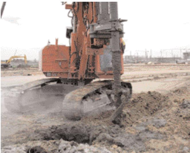
DSM-Mischwerkzeug beim Eindringen in zu behandelnden Boden.
