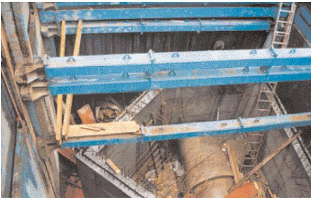
An den Stirnseiten der Baugruben für die Schachtbauwerke in Freiburg kam der Gurtungsträger zum Einsatz. (Foto: E+S)
