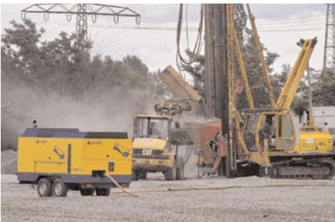
Vorbereitungen für den Bau der Ortsumgebung Senftenberg. Im Raster angelegte Rüttelstopfsäulen verbessern die Tragfähigkeit des Baugrundes.
