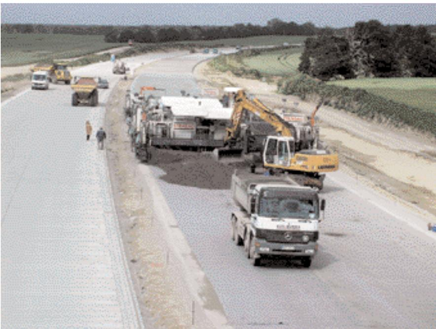
Der Einbauzug fertigt die Betondecke der zweiten Richtungsfahrbahn für die A20.
