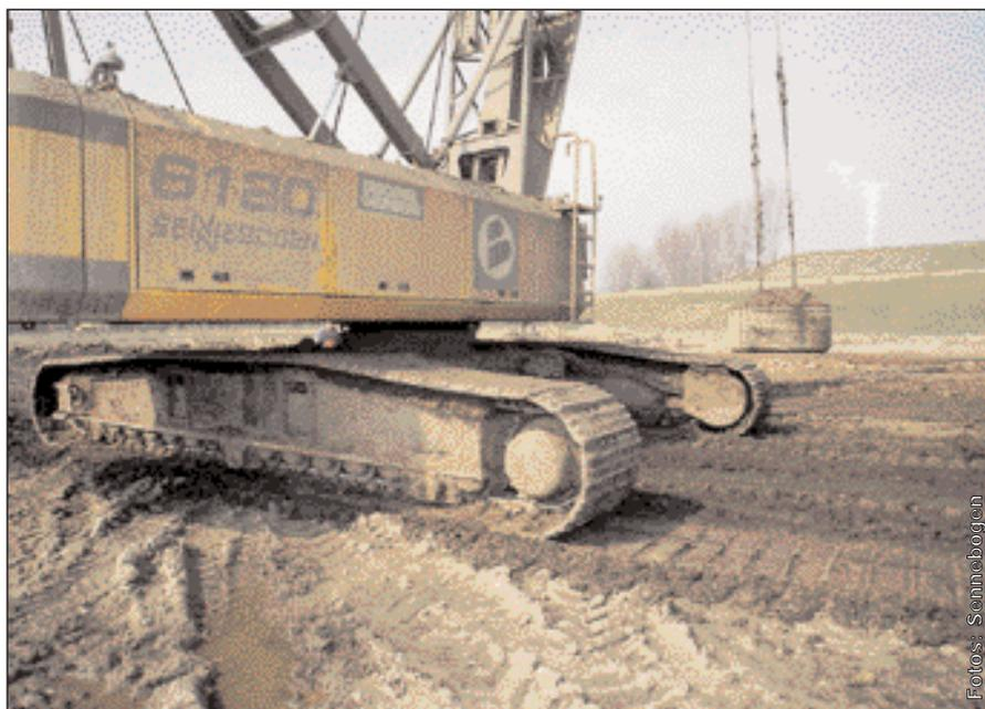
25 t aus 25 m Höhe: Das Freifallgewicht schlägt in einem definierten Raster auf und sorgt so für eine dynamische Verdichtung des Kippenbodens.
