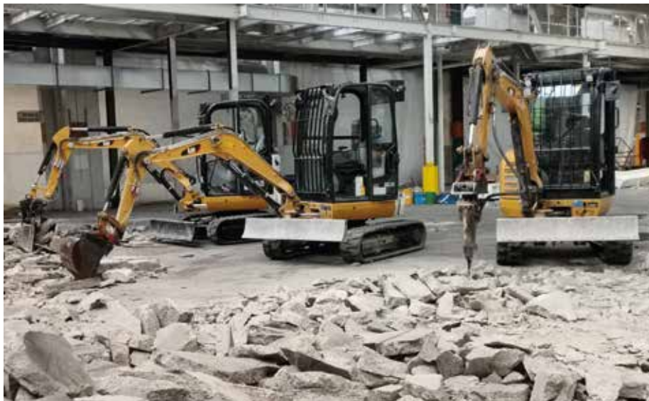
Kraftvolles Trio: Die Hybridbagger der A&S Betondemontage sind dem harten Abbrucheinsatz im Dauerbetrieb gewachsen. (Foto: A&S Betondemontage)
