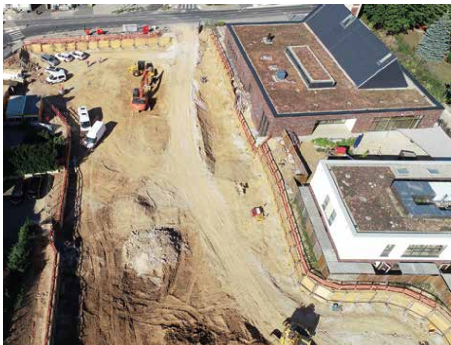
Altersgerechtes Wohnen: Für den Bau einer Seniorenimmobilie in Eschborn wurden 18.000 m 3 Erdreich ausgehoben und 3.600 m 3 Boden ausgetauscht. (Foto: Bauer Gruppe)
