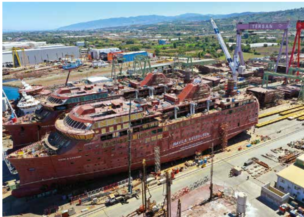
Herausforderung: Zwei jeweils 6.200 t schwere Schiffe mussten innerhalb der Tersan Werft transportiert werden. (Foto: Goldhofer)
