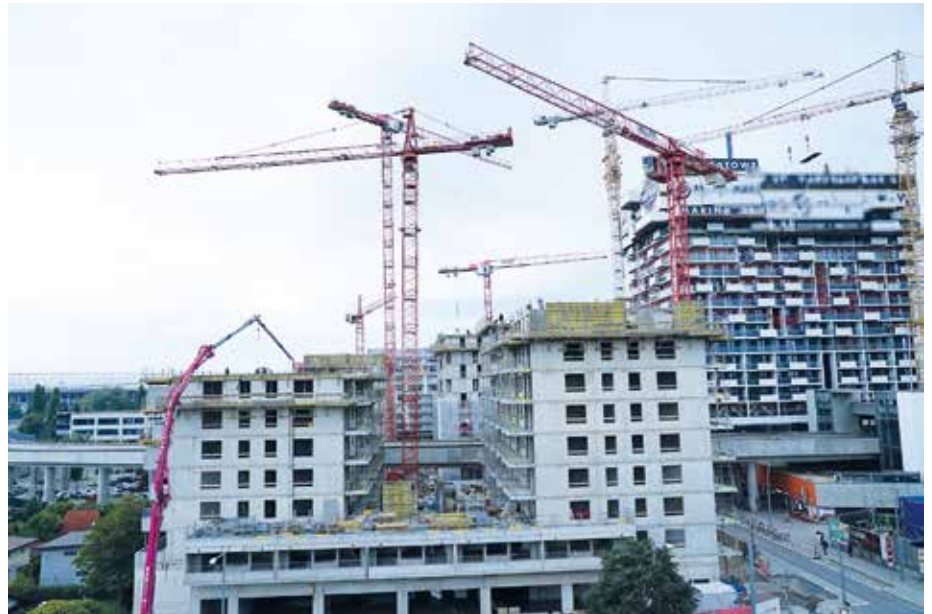
Kran an Kran: die Krane der Nachbarbaustelle ragen in das Baufeld des „Donaumarina“-Wohnkomplexes und mussten bei der Planung des Krankonzepts miteinbezogen werden. (Foto: Wolffkran International AG)
