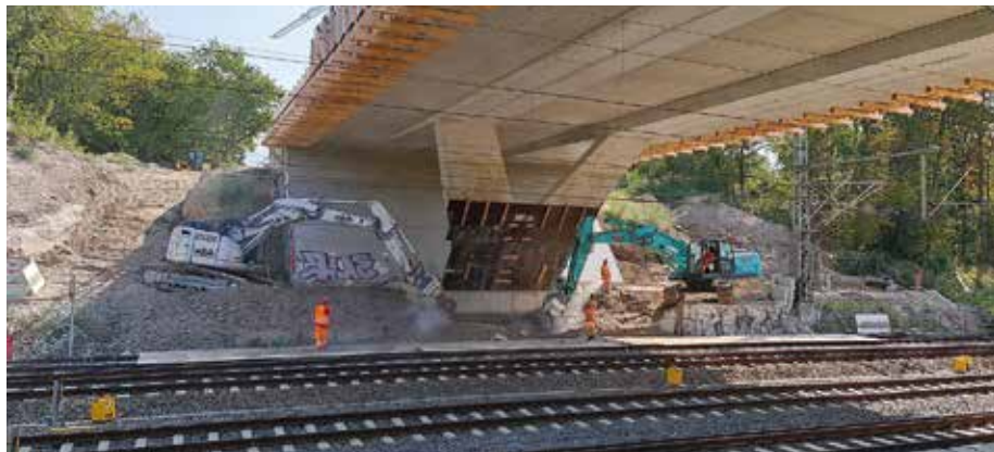
Hoher Maschineneinsatz, geringere Personalkosten: Gleich zwei Bagger mit Kemroc-Anbaufräsen wurden beim Abbruch von Brückenpfeilern in Leipzig verwendet. (Foto: Kemroc)
