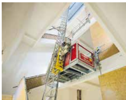
Über elf Stockwerke erstreckt sich der Zahnstangenmast des GEDA 1200 Z/ZP im Inneren des Museums. (Fotos: zeegaro)
