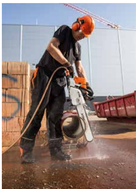
Die Diamant-Trennkette Stihl 36 GGM ermöglicht das Trennen duktiler Gussrohre bei Rohrverlege- und Reparaturarbeiten im Nassschnitt.
