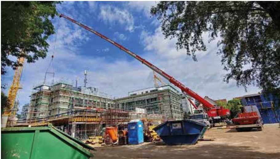
Weite Wege: Der Tadano ATF 220G-5 muss 4,6 t schwere Klimageräte über ein weiteres Gebäude hinwegheben. (Foto: Tadano)
