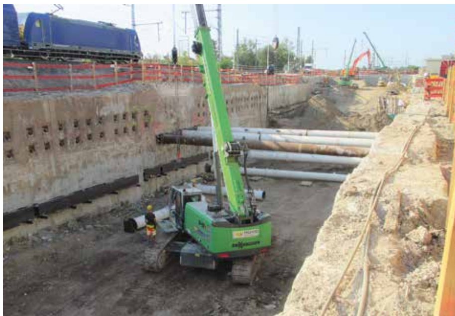
Kraftvoll: Der Sennebogen-Kran des Typs 643 R hebt geotechnische Daueranker oder Stahlaussteifungen mit Gewichten bis zu 10 t. (Foto: Wayss & Freytag)
