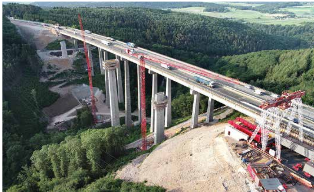
Alles bewegt sich: Die Pfeiler der neuen Tiefenbachtalbrücke wachsen in die Höhe, während daneben auf der bestehenden Trasse der Verkehr läuft. (Foto: Doka)
