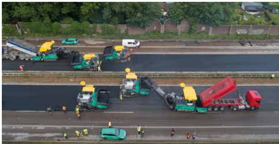
Zeitsparendes Maschinenkonzept: Um 3,6 km Autobahn in nur 55 Stunden sanieren zu können, arbeiteten bei der Deckschicht jeweils zwei Sprühfertiger pro Fahrtrichtung gleichzeitig – unterstützt von einem Beschicker. (Fotos: Vögele)
