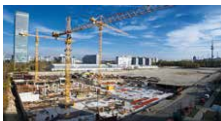
Umweltfreundlich: Mit Hilfe des biologischen Reinigungsverfahrens Funnel-and-Gate werden im Münchner Stadtbezirk Moosach pro Sekunde 90 l verunreinigtes Wasser gereinigt. (Foto: Bauer Gruppe)
