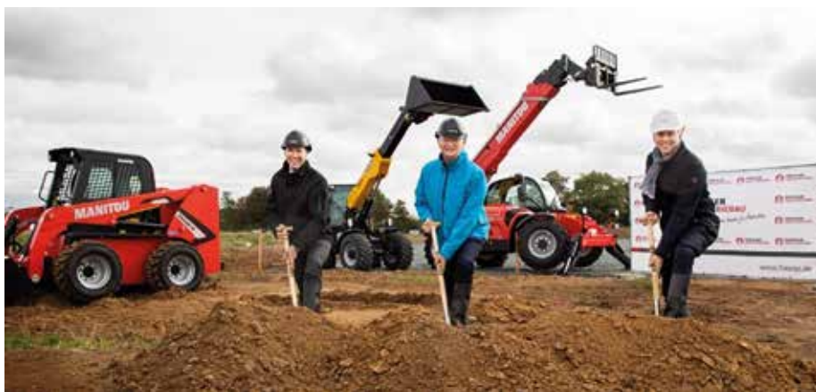
Peter Wildemann (Manitou Deutschland GmbH), Horst Burghardt (Bürgermeister Stadt Friedrichsdorf) und Dirk Förderer (Freyler Industriebau GmbH) beim feierlichen Spatenstich für den künftigen Manitou-Firmensitz in Friedrichsdorf (v.l.n.r.). (Foto: Manitou)
