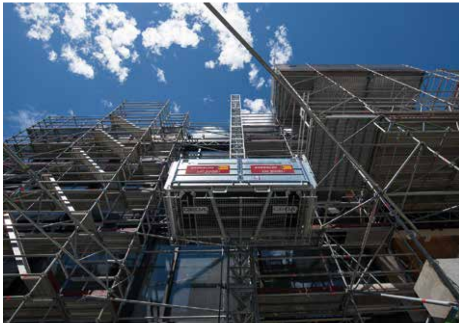
Effiziente Höhenzugangstechnik von Zeppelin Rental ist bei der Modernisierung des Deutschen Museums im Einsatz.
