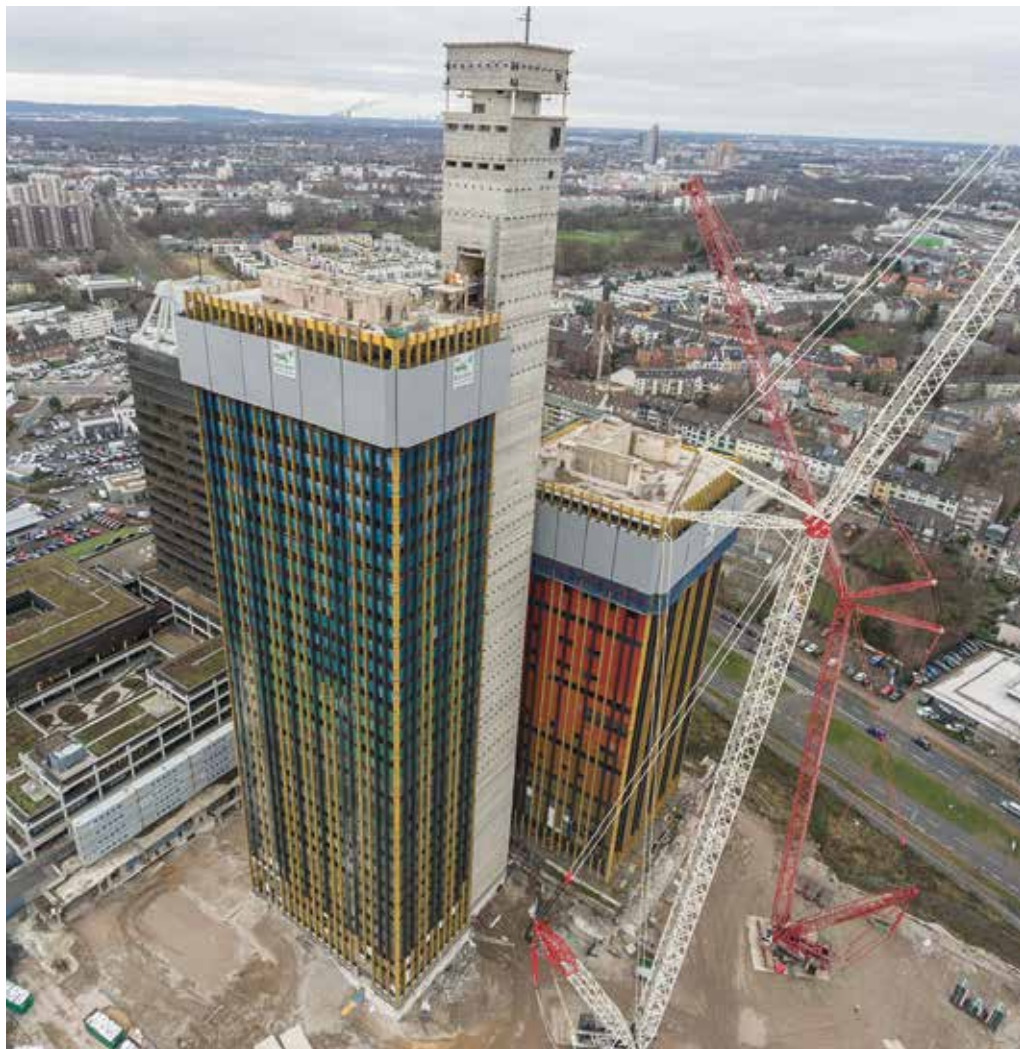
Gut geschützt: Der Büroturm (l.) und der Studioturm der ehemaligen Deutschen Welle wurden für den Rückbau ringsum mit dem Schutzschild Xclimb 60 eingehaust. (Foto: Doka)
