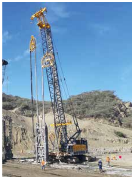
Großprojekt in der Karibik: Von Mai 2019 bis Mai 2020 stellte Bauer Fundaciones Dominicana S.R.L. rund 26.000 m 2 Dichtwand her. (Foto: Bauer Group)
