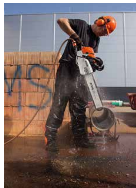
Die Diamant-Trennkette Stihl 36 GGM ermöglicht das Trennen duktiler Gussrohre bei Rohrverlege- und Reparaturarbeiten im Nassschnitt.
