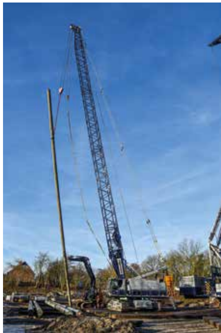
Premiere in den Niederlanden: In Rhooon werden 105 HEK-Kombi-Pfähle gesetzt. Der 100 t Seilbagger von Sennebogen hebt und setzt 33,5 m lange und 12,3 t schwere Octicon-Fertigpfähle. (Foto: Sennebogen)
