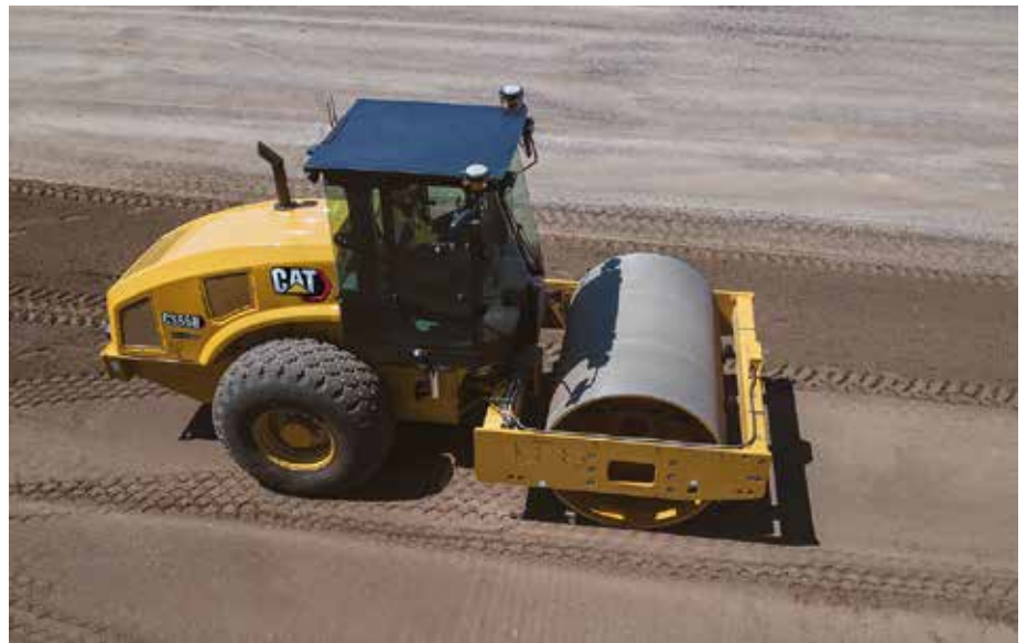
Hohe Verdichtungsqualität: Cat Command ist nun auch für Walzen verfügbar. (Fotos: Caterpillar)
