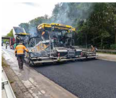
Sauberer Baustellenbereich: Die SprayJet-Technologie von Vögele erübrigt den Arbeitsgang des Vorsprühens mit Bitumenemulsion.
