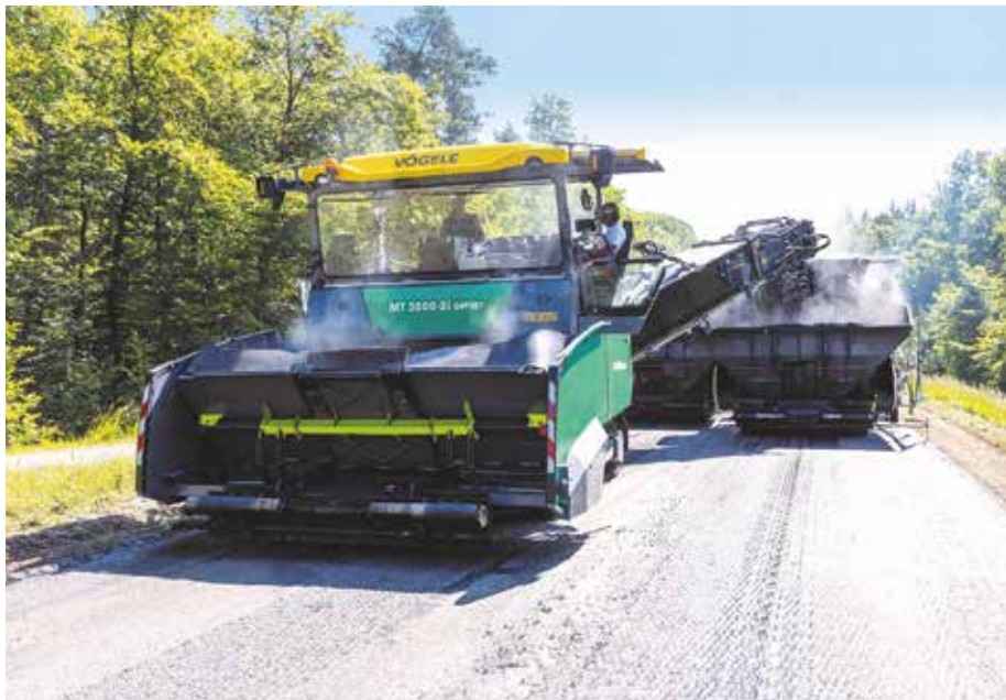
Praxistest bestanden: Der neue MT 3000-3i Offset beschickt zwei Straßenfertiger beim Heiß-anheiß-Einbau auf einer Baustelle bei Karlsruhe. (Foto: Vögele)
