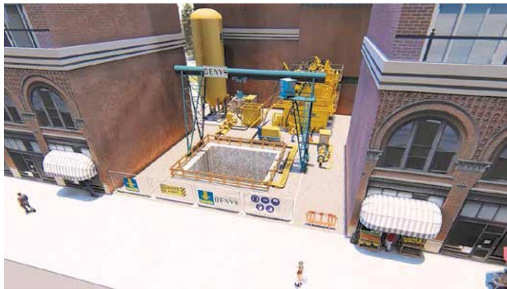
**Geringer Platzbedarf:** Das minimal-invasive Bauer Cube System reduziert die Auswirkungen von Fräsbaustellen an der Oberfläche auf ein Minimum. (Grafik: Bauer Group)
