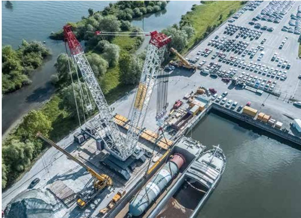
**660 t schwere Last:** Für den Hub im Hafen Kelheim wurde der CC 8800-1 mit 54 m Auslegerlänge und 50 m Superlift-Mast sowie mit 320 t Schweben- und 295 t Drehbühnenballast konfiguriert. (Foto: Tadano)
