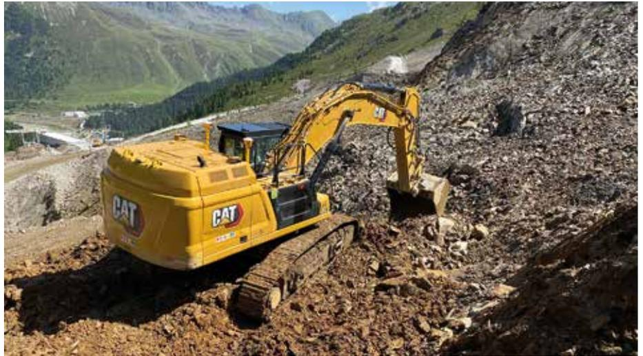
**Akkurates Arbeiten:** Beim Speicherkraftwerksbau in den Stubai Alpen setzt die ARGE SKW Kühtai auf Steuerungssysteme von Trimble Earthworks für maximale Einbaugenaugigkeit. (Foto: Sitech Austria GmbH)
