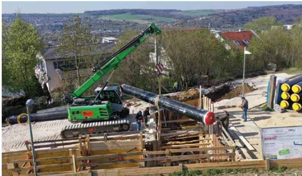
**Hohe Präzision:** Der kompakte Raupentelekrane verhebt die bis zu 12 m langen und 4 t schweren Rohre punktgenau, sodass sie an die bereits vorhandene Rohrleitung sicher angeschlossen werden können. (Foto: Jessica Hennek)
