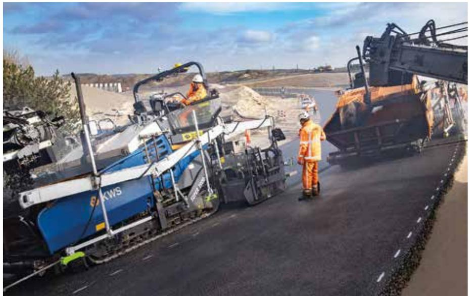
**Toleranz von nur  $\pm 2$  mm:** Die Fertiger mussten bei der Sanierung des Circuit Zandvoort in den Steilkurven Präzisionsarbeit leisten und waren dazu mit dem Big-MultiPlex-Ski von Vögele ausgestattet. (Foto: Wirtgen Group)
