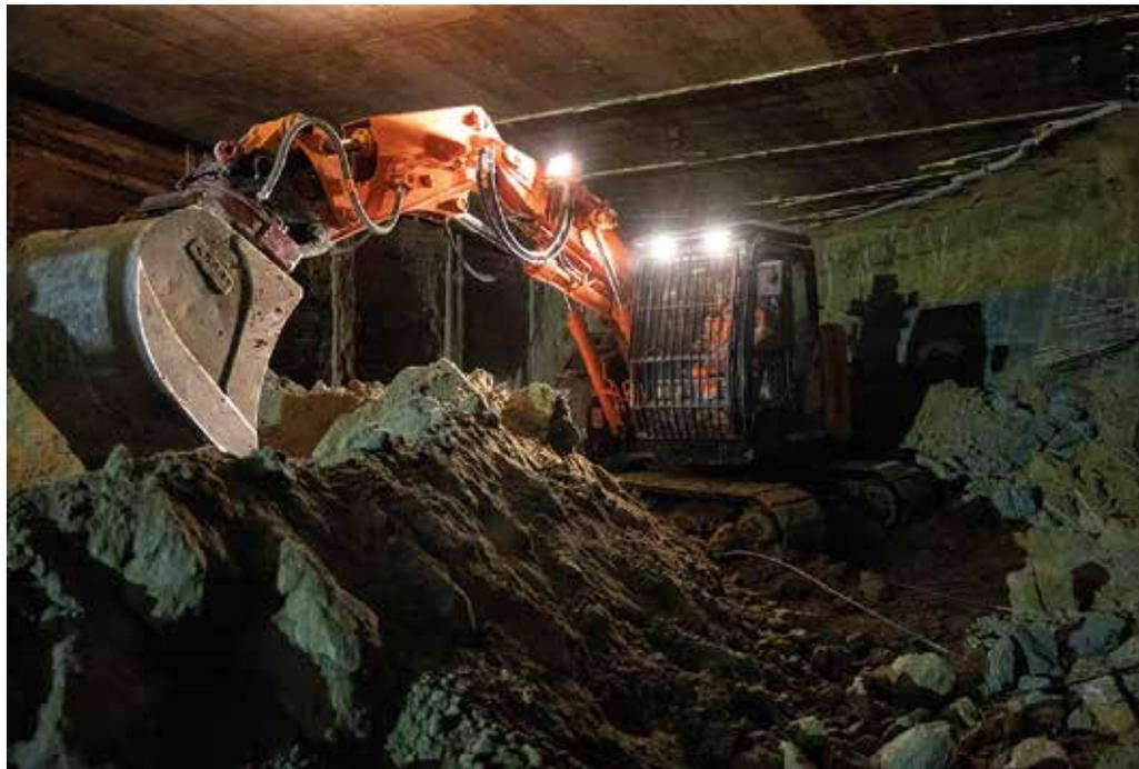
**Beengte Verhältnisse:** Der Kettenbagger musste beim Bau einer Tiefgarage im Zentrum Münchens unterhalb einer zuvor gegossenen Stahlbetondecke arbeiten. Der Arbeitsraum war teils nur 4 m hoch. (Foto: Kiesel)
