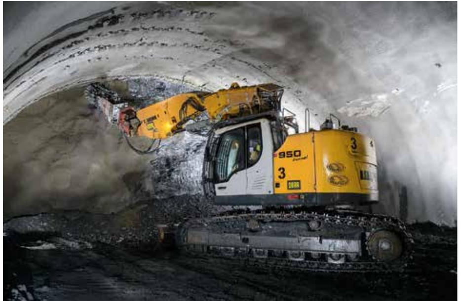
**Präzises Arbeiten:** Beim Bau eines Schnellstraßentunnels in Polen verwendet PORR einen Tunnelbagger mit einer Kettenfräse zum Auffahren der Tunnelröhren. (Foto: Kemroc/Thomas Exel)
