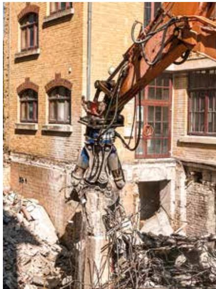
**Ein echtes Großmaul:** Die LST-Kombizange DS 230 stößt bei einem Abbruchprojekt in Leipzig auf starke und eisenbewehrte Betondecken. Mit einer Öffnungsweite von 890 mm ist sie dieser Herausforderung gewachsen. (Foto: LST Equipment)
