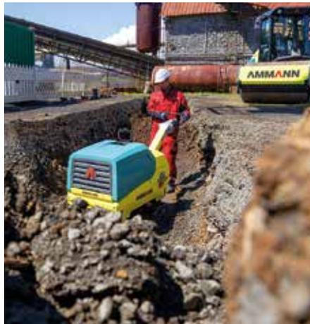
**Kraftvoll:** Mit dem Drei-Wellen-Antrieb verdichtet der Bediener mit der APH 85/95 problemlos auch nasse, bindige Böden in Gräben. (Foto: Ammann)
