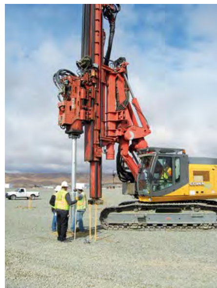
Spannen , Ausrichten und Einvibrieren...
