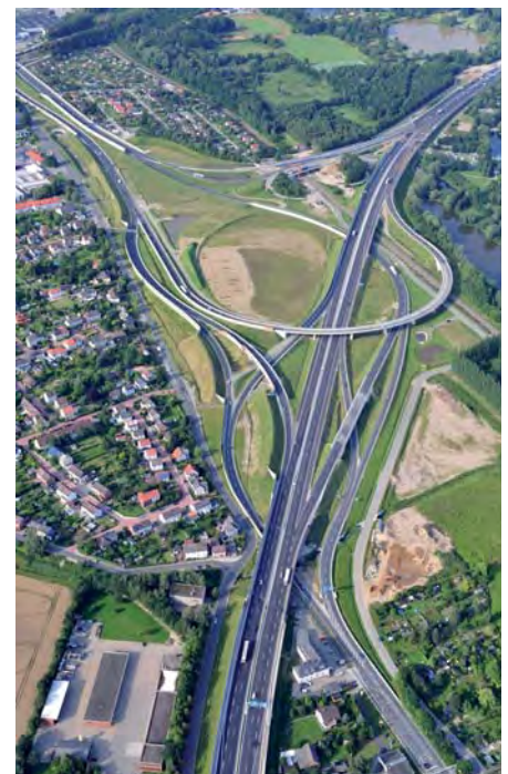
Das fertig gestellte Autobahndreieck Braunschweig-Südwest entlastet Anwohner und Verkehr. (Foto: Eurovia)
