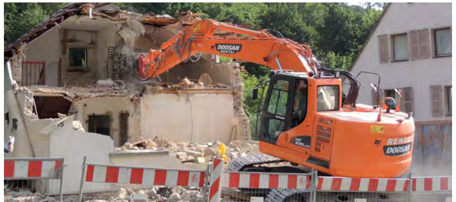
Aufgrund seiner kompakten Maße meisterte der Doosan Kettenbagger die komplizierten Abbrucharbeiten. (Foto: Doosan)
