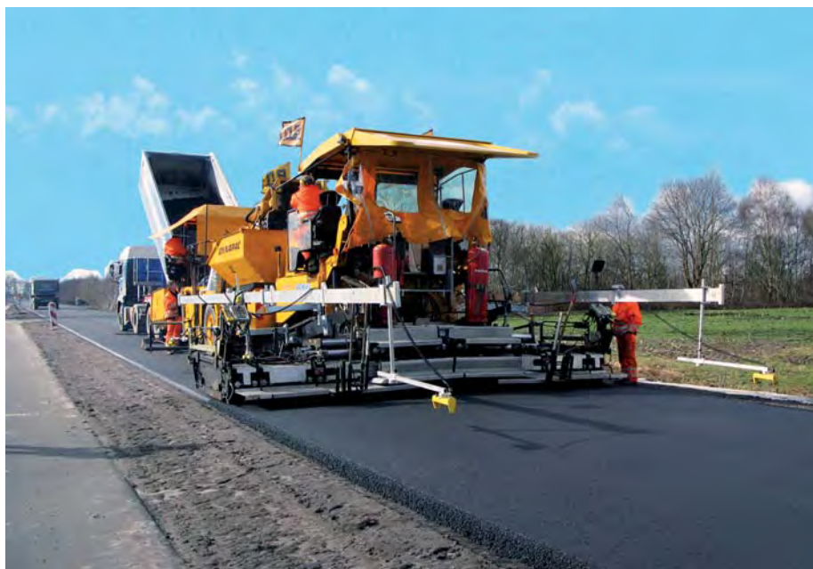
Moba bietet Mess-, Steuer und Regelsysteme für Baumaschinen, z. B. das Nivelliersystem Mobamatic mit Big Sonic-Ski.
