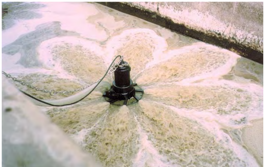
Tsurumi-Tauchbelüfter in Betrieb: Kraftvoller Sauerstoffeintrag ohne Verstopfungsgefahr. (Fotos: Tsurumi)
