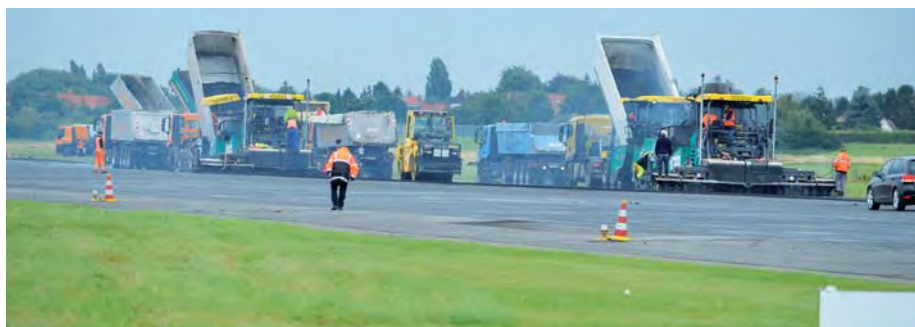
In nur sechs Tagen wurde die Start- und Landebahn saniert.
