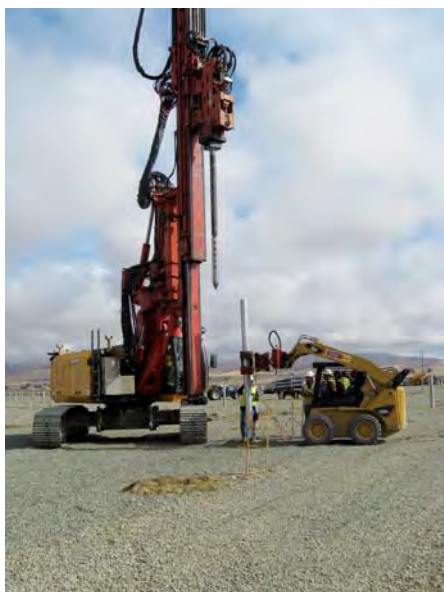
Aufstellen des Rohres...
