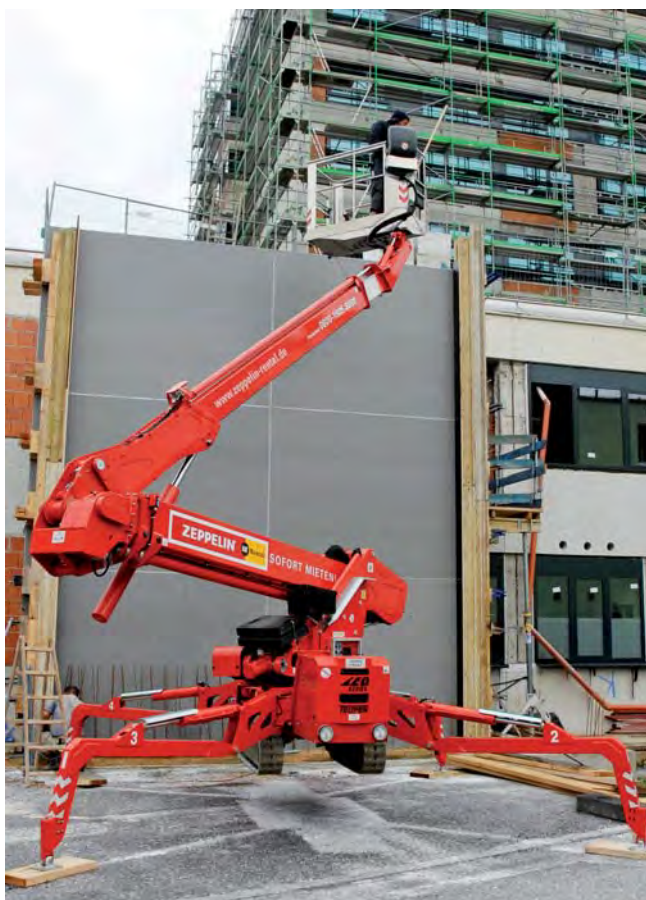
Die Raupenarbeitsbühne von Zeppelin Rental bei der Sanierung eines Klinikums. (Foto: Zeppelin Rental)
