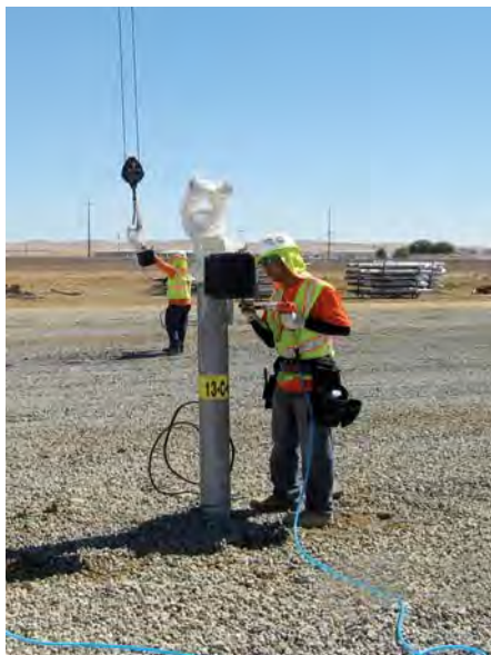
...und schließlich Montage der Aktuatoren und der Steuerkästen. (Fotos: ThyssenKrupp Tiefbautechnik)
