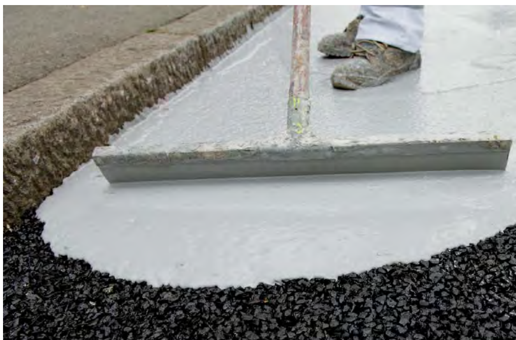
Eine spezielle Straßenbeschichtung hilft, die bodennahe Stickoxidbelastung aus Autoabgasen zu reduzieren. (Foto: Eurovia)
