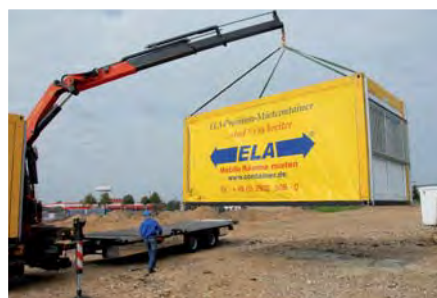
Container werden punktgenau per Lkw-Ladekran zur Baustelle geliefert.
