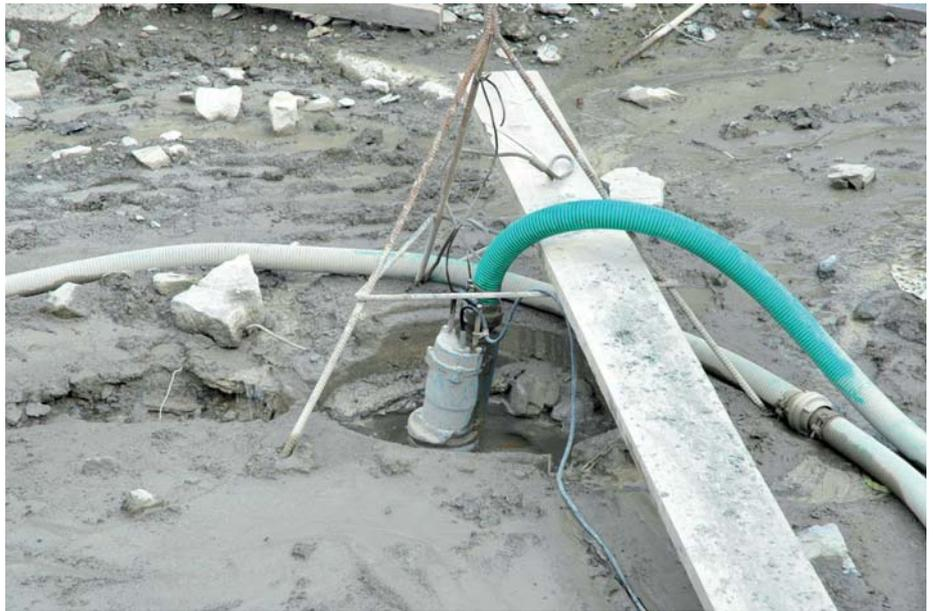
**Typischer Einsatz** einer Schmutzwasserpumpe im Pumpensumpf einer Baustelle (Foto: Tsurumi)
