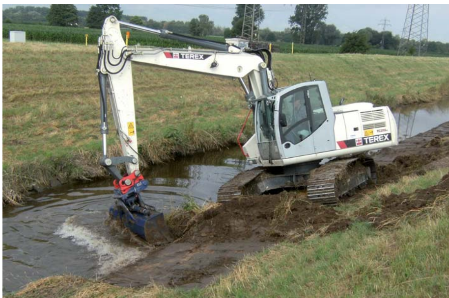
Gut zu tun: Der TC 210 LC bearbeitet auf einer Länge von etwa 200 km die Ufer der Flüsse Acher und Rench – zur Verbesserung des Hochwasserschutzes. (Foto: Terex)
