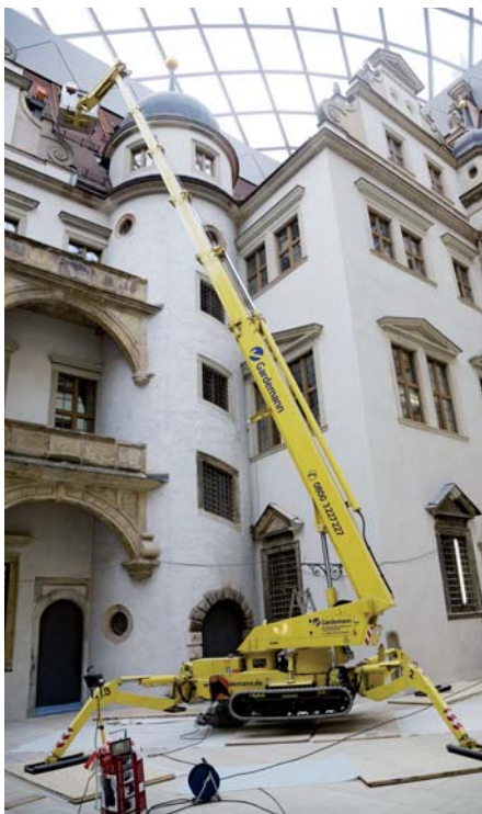
Leichte und kompakte Gummiketten-Arbeitsbühnen mit lastverteilenden Abstützplatten sind auf empfindlichen Untergründen genau die richtige Lösung. (Foto: Gardemann)
