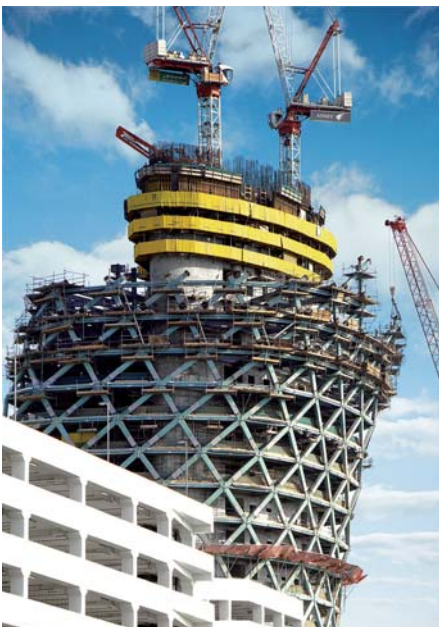
Mit insgesamt 78 Konsolen der Doka-Selbstkletterschalung SKE 100 wird der Turm gebaut. (Fotos: Doka)
