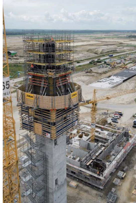
Der Tower und das zugehörige dreigeschossige Bodengebäude des neuen Hauptstadtflughafens BBI werden mit Schallösungen von Hünnebeck erstellt.
