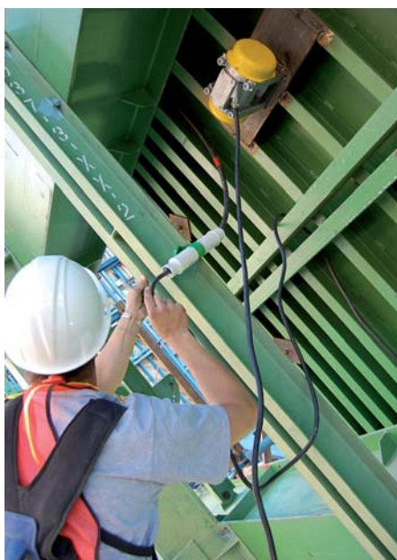
Die kompakten Außenvibratoren , die an den Schalungen angebracht waren, sorgten für eine 1A-Betonverdichtung. (Foto: Wacker Neuson)
