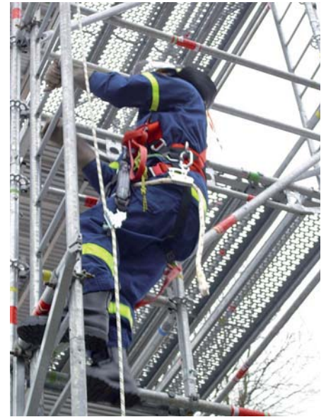
Nicht ohne: Gerade bei Arbeiten in der Höhe ist eine Persönliche Schutzausrüstung gegen Absturz Pflicht. (Foto: THW Bad Segeberg)
