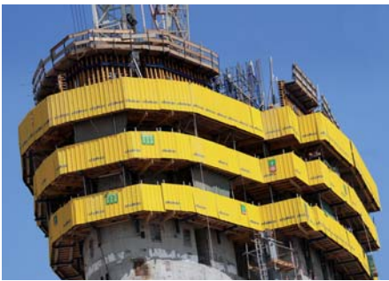
Ein elliptischer Grundriss und eine Vielzahl an Schächten kennzeichnen den Ortbetonkern des Turms.
