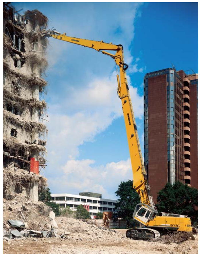
Der neue Raupenbagger R 974 C VH-HD ermöglicht das Arbeiten in 41 m Höhe. (Foto: Liebherr)
