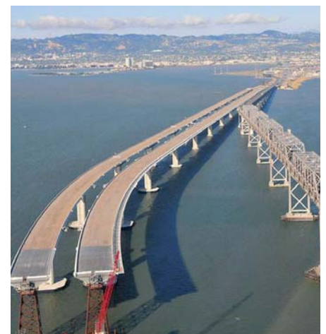
Blick auf den östlichen Teil der Bucht von San Francisco: rechts die alte doppelstöckige Brückenkonstruktion von 1936, links der Brückenneubau. (Foto: Wikipedia)
