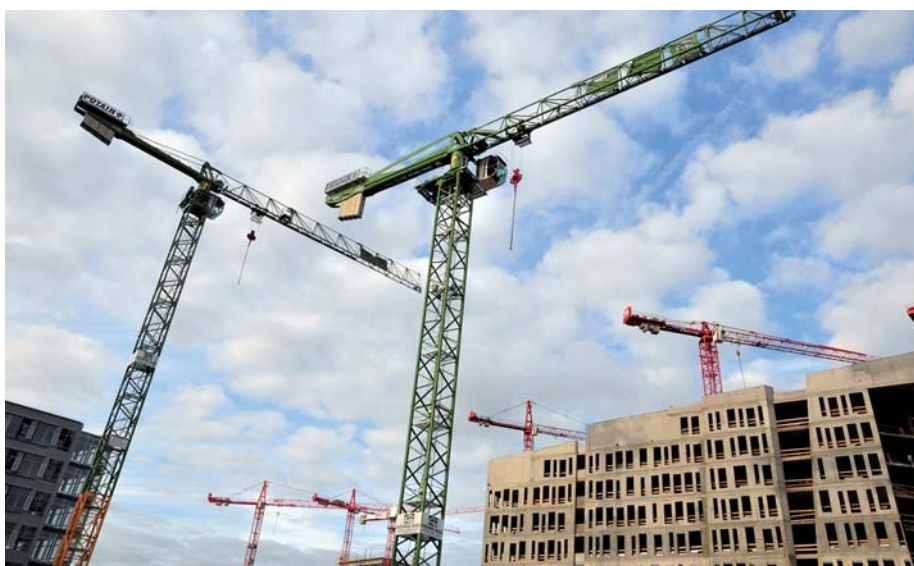
Der Topless-Kran MDT 268 mit 25-m-Ausleger erwies sich als die richtige Wahl, denn er dreht unter dem ersten Kran durch und hebt die 9 t schweren Fertigteile mühelos.
