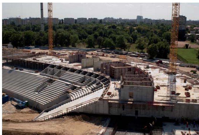
Der ovale Grundriss wird durch angewinkelte Wandflächen erreicht – ohne Anschlussbewehrung mit Hilfe von 373 Gelenkecken. (Fotos: Meva)
