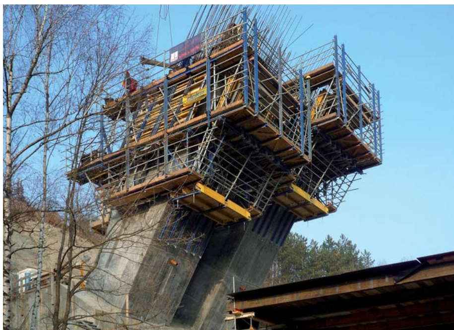
Zum Klettern der Außenschalung dienen pro Pfeiler vier Scheiben Kletterschalung SKE 50 auf der vorgeneigten und sechs Scheiben auf der Überhangseite. (Fotos: Doka)
