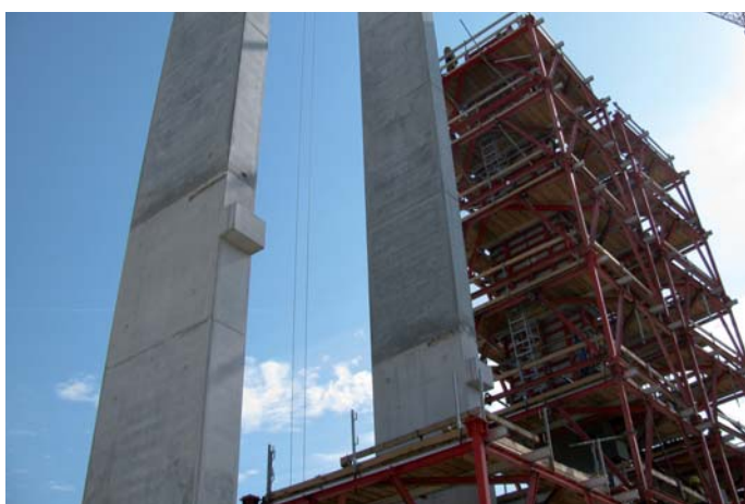
Mit dem Gerüstturm Space erfolgt das Betonieren der 120 Stützen einfach und sicher – in nur zwei Takten.
