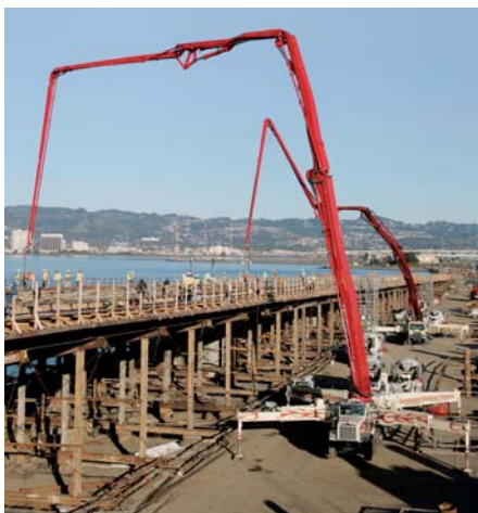
PM-Großmastpumpen auf der Brücken-Großbaustelle. Bei weniger Platzangebot hätten beide Maschinen in OSS-Position einseitig schmal abgestützt werden können.
