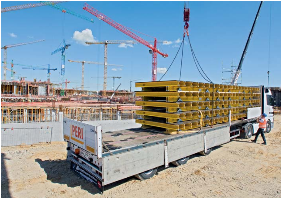
Das enge Zeitfenster für die Baustelle erfordert riesige Mengen an Schalungs- und Gerüstmaterial innerhalb kürzester Zeit. Die Deckentische werden von PERI vormontiert und just in time zur Baustelle geliefert. (Fotos: Peri GmbH)
