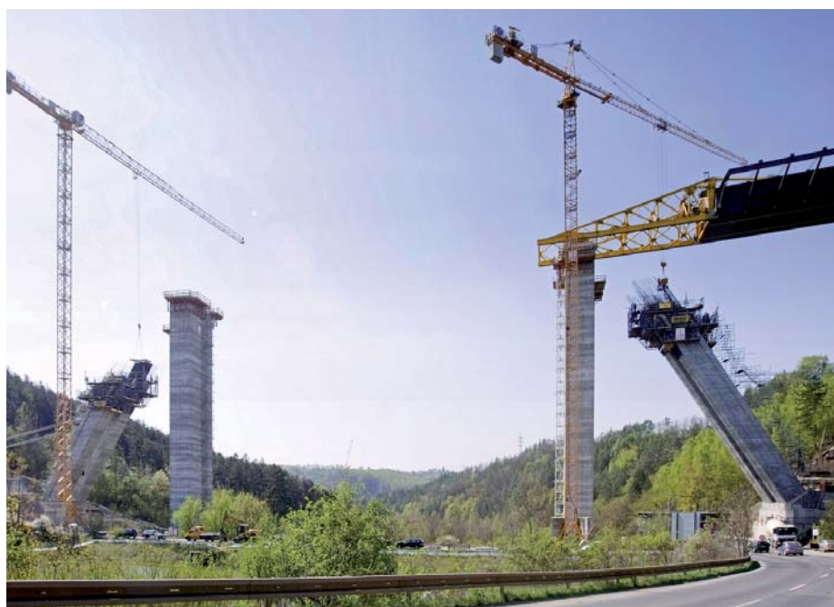
Die Selbstkletterschalung macht eine aufwändige Unterstellung überflüssig – ein Gewinn an Zeit und Einsparung an Material und Geld.
