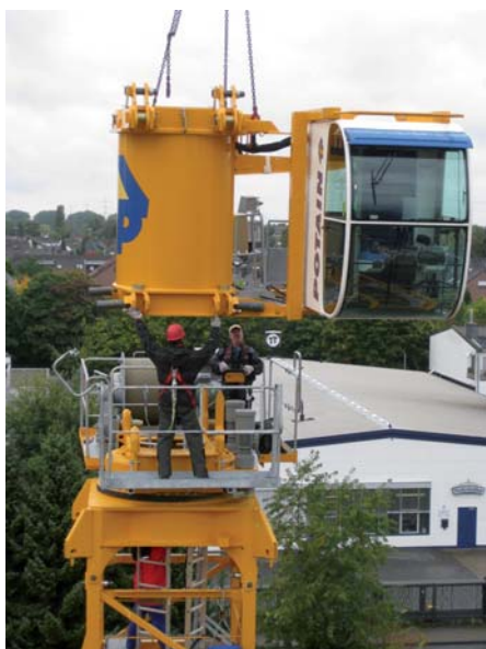
Der Kabinenmast mit Großraumkabine ist ein Montagehub und ruckzuck montiert und installiert. (Fotos: Manitowoc)
