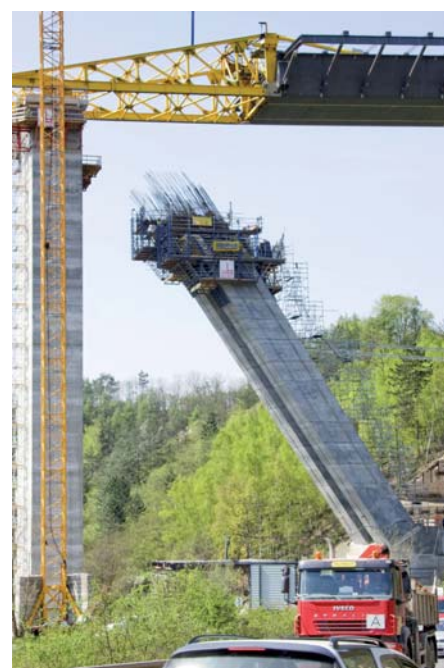
Die Doppelpfeiler sind um 33^\circ aus der Senkrechten geneigt und nach oben aufweitend.
