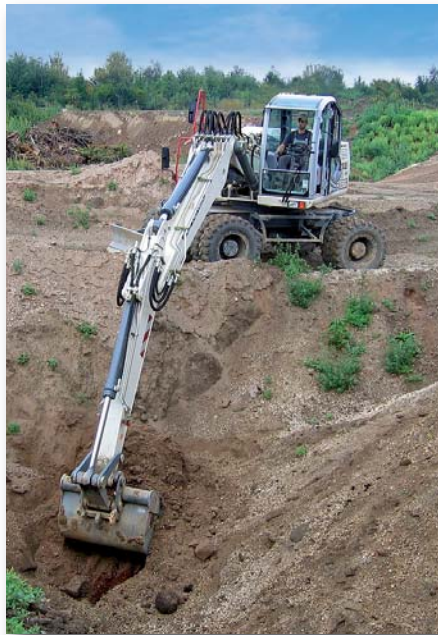
Bei den Aushubarbeiten sind besonders die Grabtiefe von 5,80 m und die Reichweite von 9,30 m des TW 190 gefordert. (Foto: Terex)
