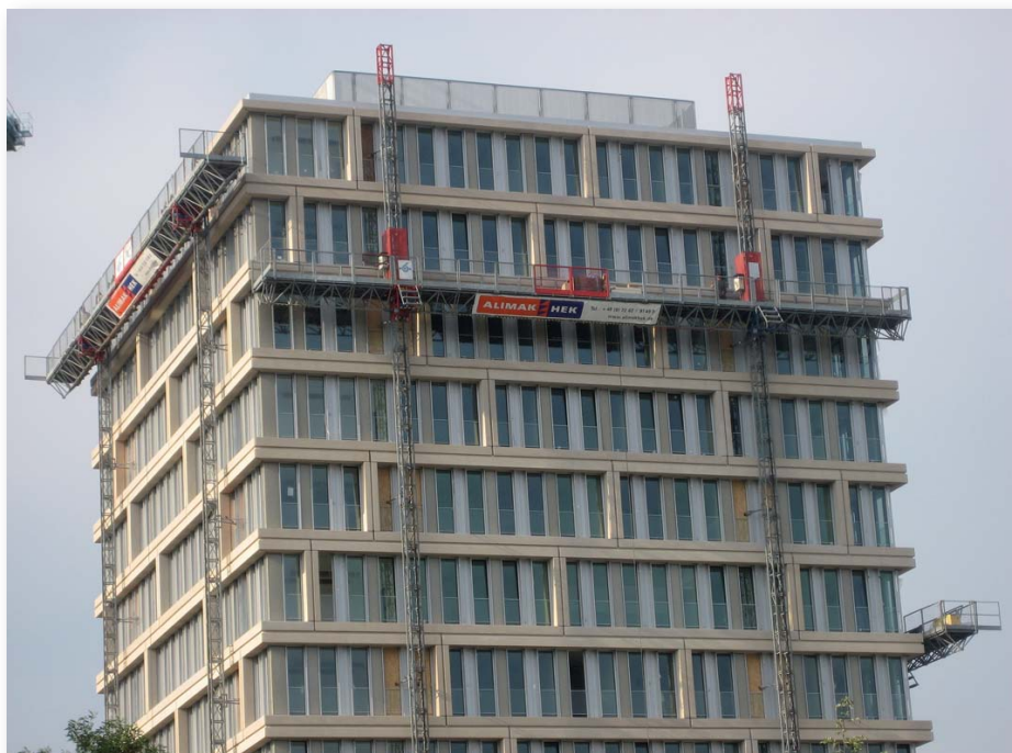
Ideal für die Fassadenmontage: Vier HEK MSM-Mastkletterbühnen mit je 28 m Länge umsäumen den Neubau des Bundesministeriums für Gesundheit in Bonn. (Foto: Alimak Hek)
