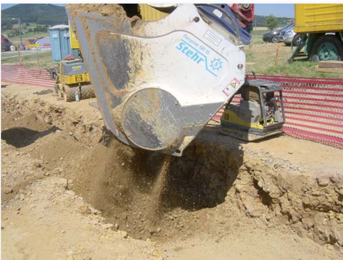
Der Anbau-Recycler SR 15 siebt den Bodenaushub ab, wie hier zu sehen. (Fotos: Stehr)
