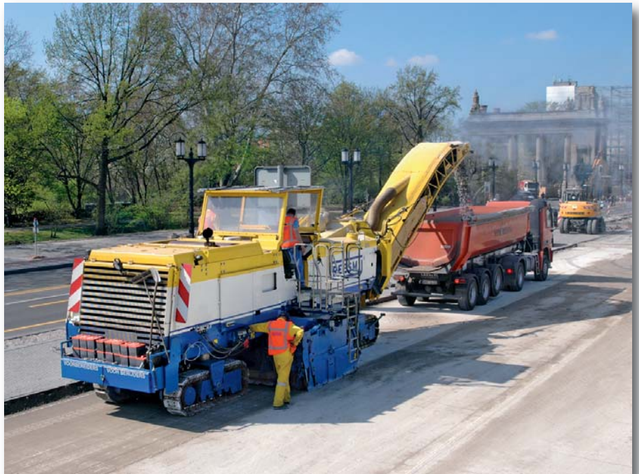
Um die Qualität der Fahrbahndecke langfristig zu sichern, musste nicht nur die 5 cm dicke Asphalt-Deckschicht, sondern auch ein Teil der darunter liegenden Betontragschicht abgefräst werden.
