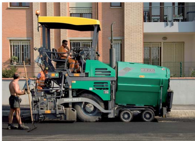
Mit hochgeklappten Behälterwänden reduziert sich die Gesamtbreite bei den Kompaktfertigern auf schmale 1,8 m. So kommt der Fertiger auch durch enge Gassen oder Einfahrten an den Einbautort.
