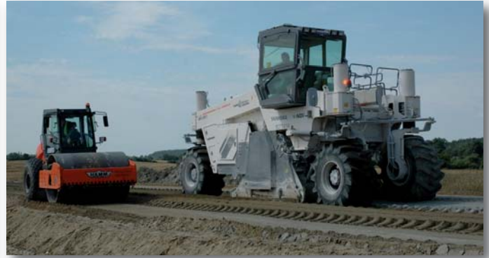
Das vom WR 2500 S aufbereitete Bodengemisch wird unmittelbar hinter dem Stabilisierer verdichtet. Die 12-t-Walze 3412 HT von Hamm arbeitet mit Oszillation und erreicht damit eine schnelle und effektive Verdichtung.
