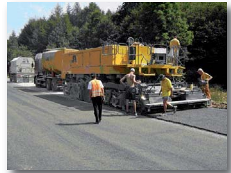
Einbau „frisch an frisch“ durch Einbauzug mit Streuer, Wasserwagen und Mixpaver. (Foto: SAT)
