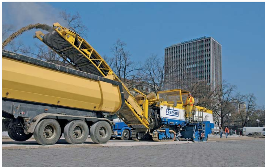
Die W 2200 von Wirtgen mit dem 3,80 m breiten FCS-Frässaggregat bot auf der Straße des 17. Juni in Berlin eine großartige Performance. (Fotos: Wirtgen)
