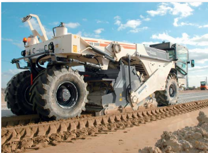
Seit zwei Jahren in Polen im Dauereinsatz: Die Stabilisierer von Wirtgen, hier der WR 2000, sind äußerst vielseitig einsetzbar und einfach zu transportieren.
