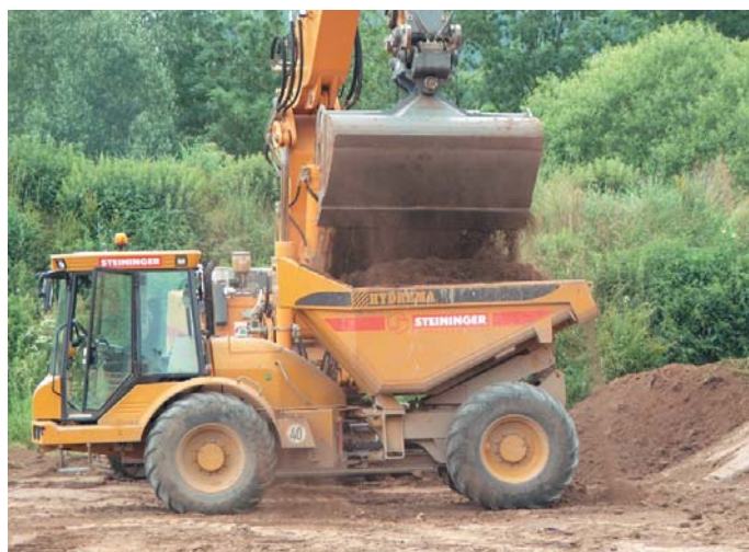
Hier wird der Dumper 912 mit wenigen Ladespielen beladen. (Fotos: Hydrema)
