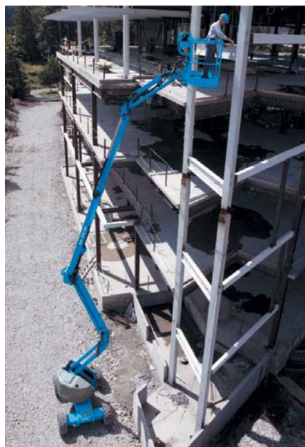
Die Gelenkteleskoparbeitsbühne Z-51/30J RT: Kompakte Abmessungen. (Foto: Genie)
