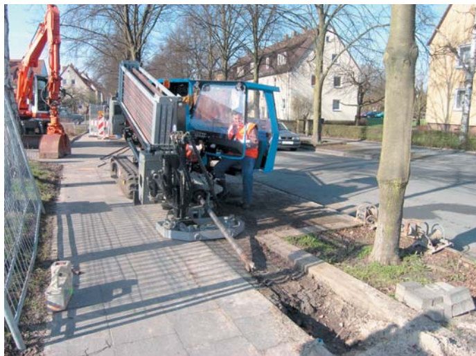
Hier im Bild ist die gesteuerte Bohranlage Grundodrill 15 X beim Überbohren zu sehen.
