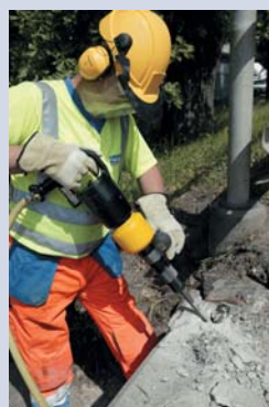
Mit einer Schlagleistung von 1.770 bpm bei 6 Bar vereint der TEX 07PE viele Vorteile in sich.
