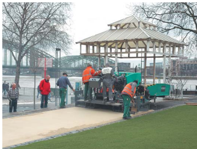
Das gelbe Mischgut hat die gleichen Eigenschaften eines schwarzen Asphalts. (Fotos: Vögele)
