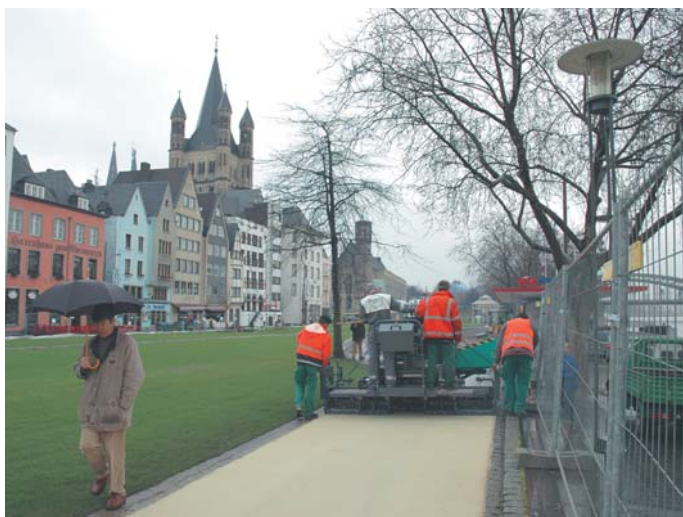
Mehrfach gelobt wurde der kleine Fertiger von Bedienern, Anwohnern und Passanten wegen der geringen Geräuschemissionen.
