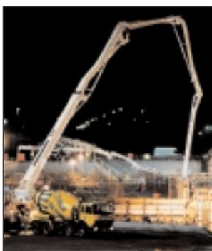
Unser Titelbild zeigt zwei Putzmeister Großmast-Betonpumpen des Typs BSF 5 einer Nachtbetonage.
