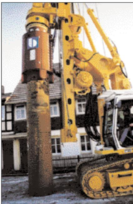
Automatischer Bohrrohradapter von Bilfinger Berger.
