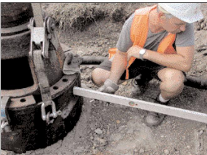
Das Stahlrohr wird bis zur GOK abgerammt.
