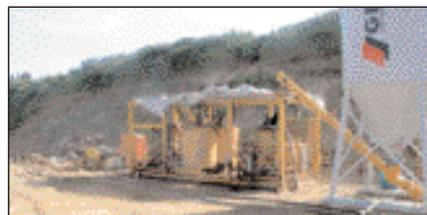
Hergestellt wird die Suspension mit einer Kompaktmischanlage.
