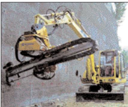
*Baugrubensicherung mit Spritzbeton und Rückverankerung mit einem Komatsu-Bagger PC110 und Morath-Baggeranbau 10 – 15 t.*
