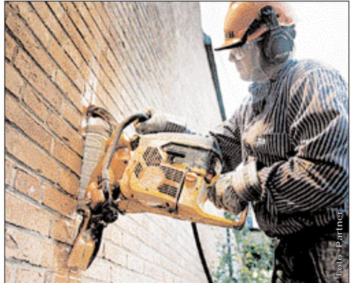
Fast der komplette Durchmesser der Trennscheibe des Partner K950 Ring befindet sich im Material.
