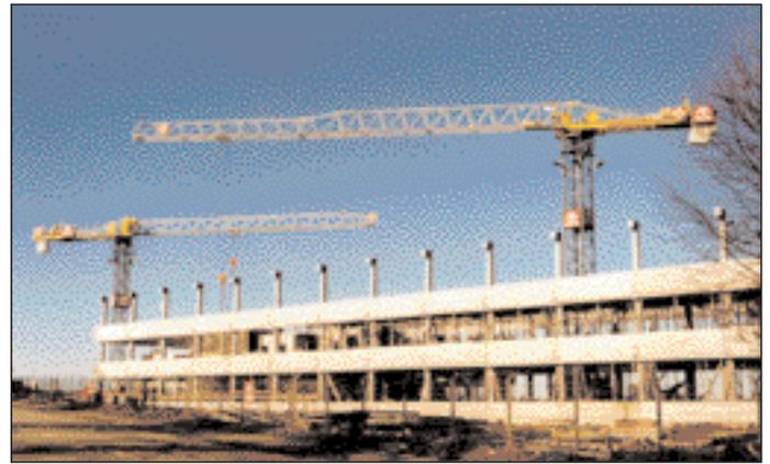
Bild 11: Einsatz von spitzenlosen Obendrehern mit Katzausleger in der Einflugschneise eines Flughafens (Zeppelin).
