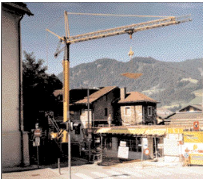
Bild 10: Untendreher mit teleskopierbarem Turm und Katzausleger auf beengter Baustelle (Liebherr).
