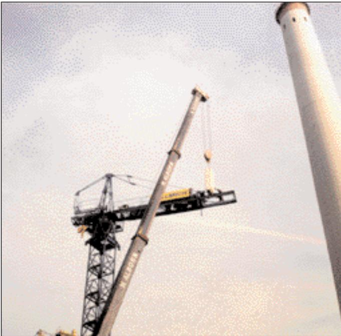
Bild 13: Autokran (Allterrain-Kran) mit Teleskopausleger bei der Turmdrehkranmontage.
