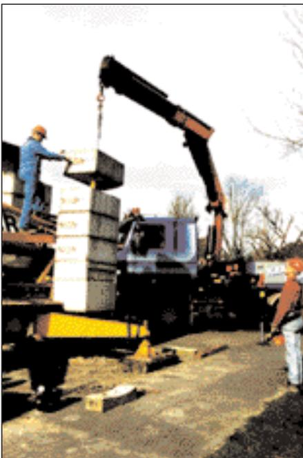
Bild 19: Kran-Ballastierung mit Hilfe eines LKW-Ladekranes (Palfinger).
