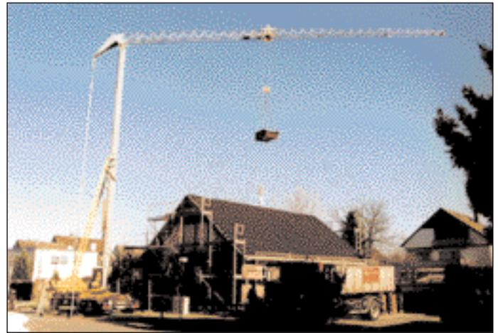
Bild 8: Kleiner Schnellmontagekran mit Katzausleger auf LKW bei Dachdeckerarbeiten.
