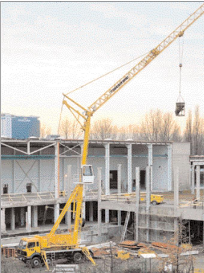
Bild 9: Leistungsstarker Katzauslegerkran auf LKW bei Rohbauarbeiten in einer Baulücke (Liebherr).
