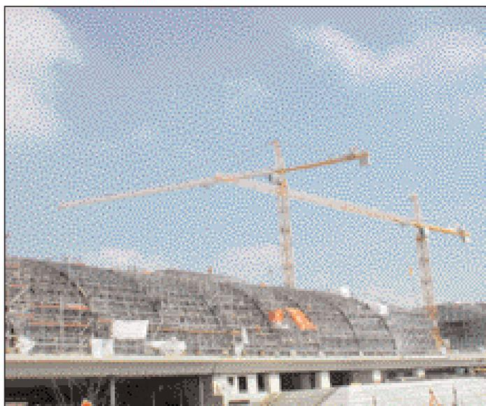
*Aus Sicherheitsgründen waren alle Krane so programmiert, dass sie abschalteten, bevor sie die Gebäudekontur im Norden verließen.*
