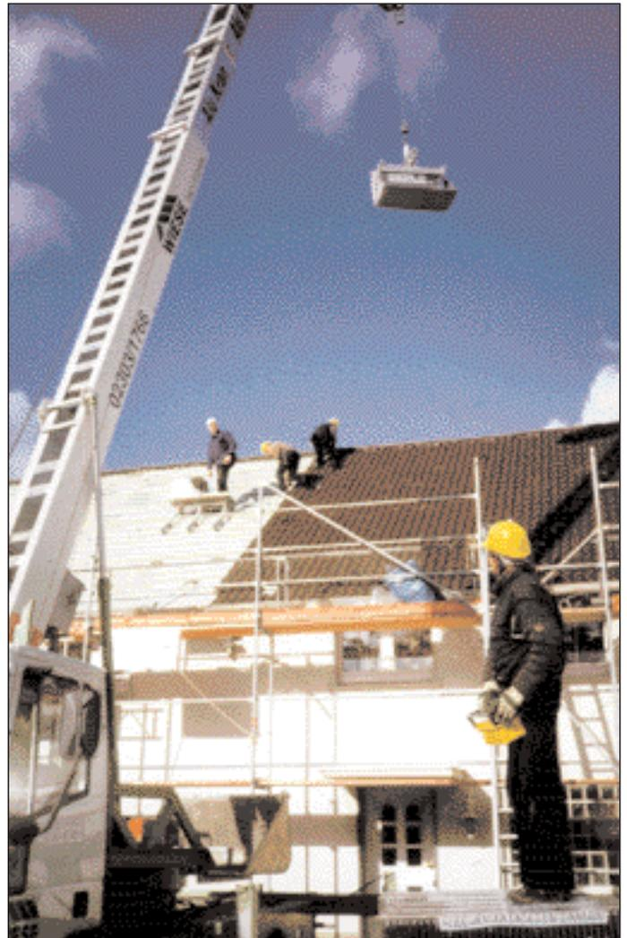
Bild 15: Einsatz eines leichten Auto-kranes bei Dachdeckerarbeiten (Klaas).
