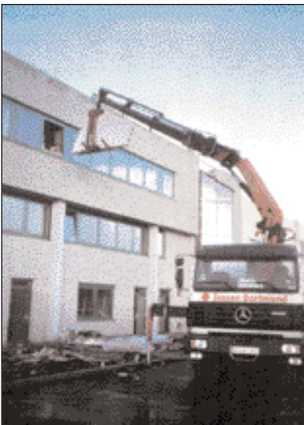
Bild 20: Transport von Bauplatten zur Einbaustelle mit LKW-Ladekran und speziellem Lastaufnahmemittel (Palfinger).
