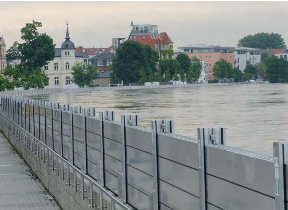
Der Scheitelpunkt der diesjährigen Flut erreichte 8,51 m. Aluminium-Dammbalken von ThyssenKrupp schützten die Dresdener Altstadt. (Foto: ThyssenKrupp Bautechnik)
