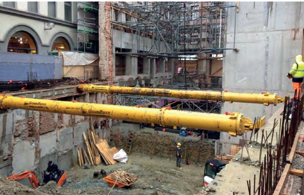
Die Steifen des Groundforce-Systems lassen sich beim Einbau problemlos mit der Hydraulikpumpe anpassen und optimal positionieren. Das bietet zusätzliche Sicherheit für die historische Fassade. (Foto: Groundforce)
