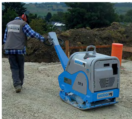
Zu sehen auf der Musterbaustelle: Der extrem leistungsstarke Bodenverdichter CR 9 MSM überzeugt mit einer leichten, ermüdungsfreien Bedienung. (Foto: Weber MT)
