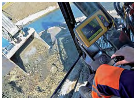
Satellitengestützte Raumerfassung und Maschinensteuerung von Topcon steigert die Produktivität und sorgt für höchste Präzision. (Foto: Topcon)
