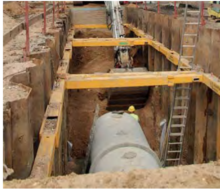
Der hydraulische Gurtungsrahmen lässt sich schnell und flexibel einbauen. (Foto: Groundforce)
