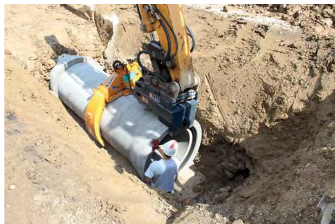
Mit dem neuen hydraulischen Rohrschieber von MTS lassen sich Rohre exakt positionieren und ohne Beschädigungen sicher ineinander fügen. Dabei wird kein zusätzlicher Mann in der Baugrube benötigt. (Foto: MTS)
