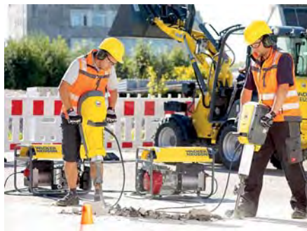
Seine breite Palette an Baugeräten und Kompaktmaschinen zeigt Wacker Neuson auf der TiefbauLive in Aktion. (Foto: Wacker Neuson)
