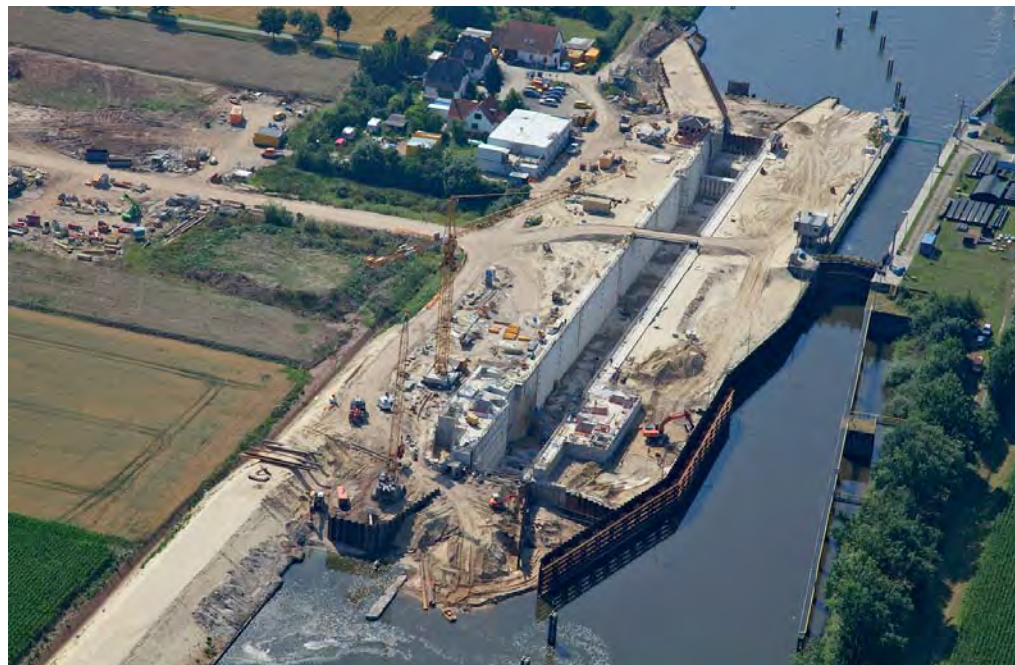
Das neue Schleusenbauwerk Dörverden mit einer Gesamtlänge von 201 Metern soll im Herbst 2013 fertiggestellt werden. (Luftbild: Dirk Laubner)
