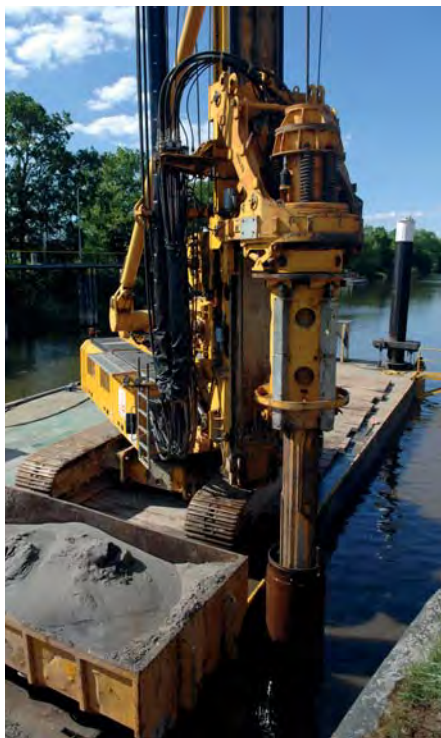
Die Kammersohle wurde mit über 300 rund 16,60 m langen Verpresspfählen tief im Baugrund rückverankert. (Fotos: Studio Gielen)
