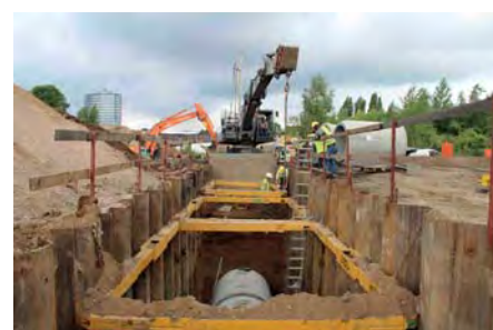
Der hydraulische Groundforce-Gurtungsrahmen ersetzt einen aus Stahlträgern geschweißten Rahmen. Er lässt sich schnell und einfach in die Baugrube einsetzen und spart dadurch Zeit und Geld. (Foto: VP Groundforce)
