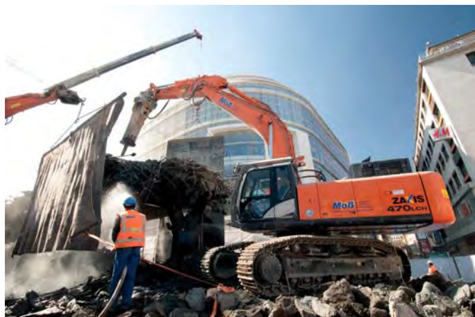
Beim Abbruch der Hochstraße „Tausendfüßler“ mitten in der Düsseldorfer Innenstadt setzte MoB seinen neuesten ZX470ein.
