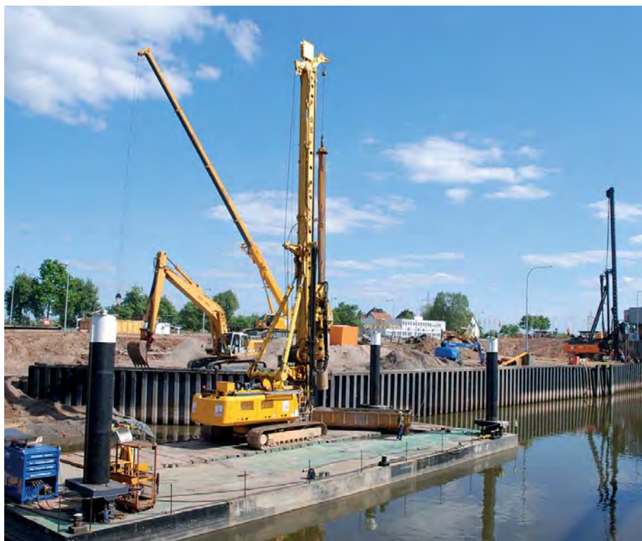
Die umfangreichen Spezialtiefbauarbeiten erfolgen größtenteils mit einem Ponton vom Wasser aus.
