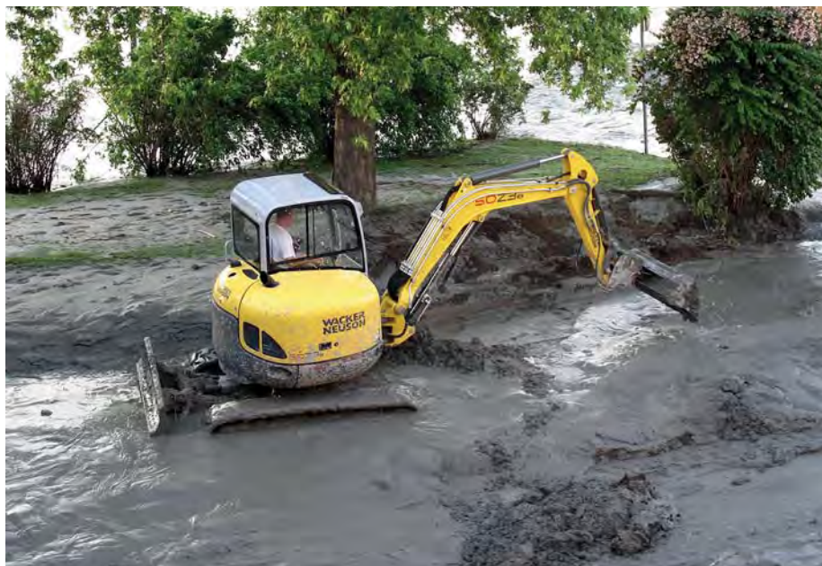
Donau-Hochwasser bei Linz: Hier hilft ein Kompaktbagger 50Z3 beim Beseitigen der Schlamm-massen. (Foto: Wacker Neuson)
