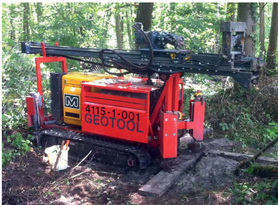
Ausgerüstet mit Hatz-SilentPACK-Motoren sind die Geotool-Geräte in der Lage, in jedem Gelände Bodenuntersuchungen durchzuführen. (Foto: Hatz)
