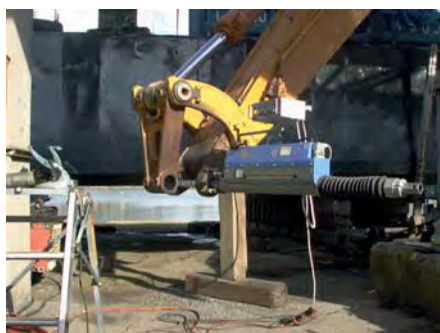
Der Einsatz der mobilen Bohr- und Schweißgeräte führt zu einer erheblichen Zeit- und Kostenersparnis. (Foto: MBS)
