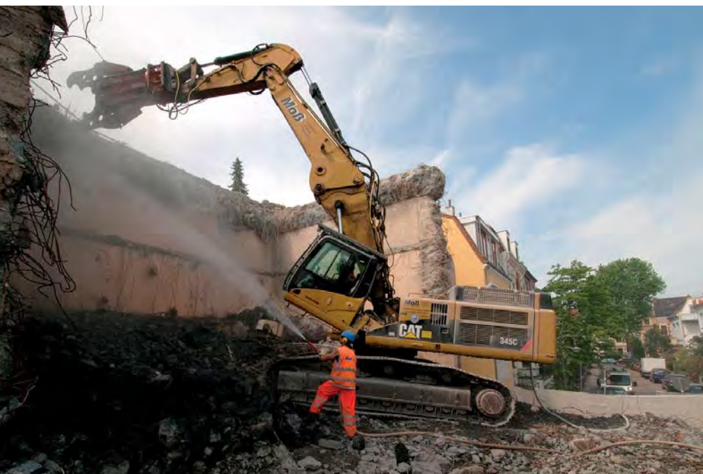
Ein optimales Einsatzwerkzeug für den Bunkerabbruch ist dieser NPK SV-65XR von MoB. (Fotos: MoB)
