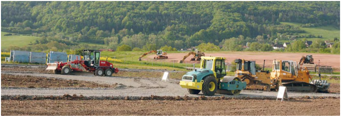
Mit zwei Baggern , zwei Raupen, zwei Walzen und vier Lkw wurde auf dem Testgelände gezeigt, wie AutoBauLog die komplette Baulogistik einschließlich Controlling und Abrechnung verbessert. (Foto: Ammann)
