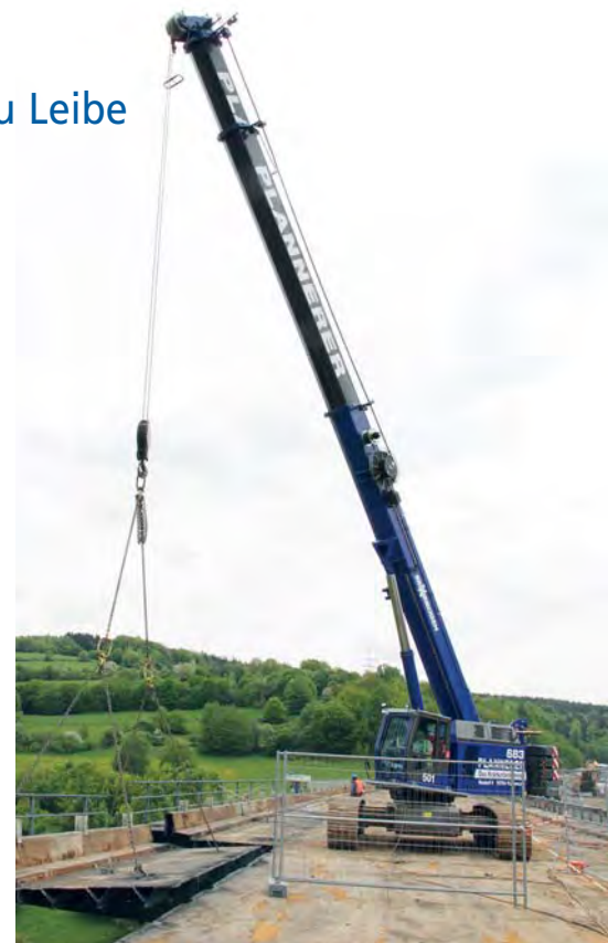
Der 80-t-Raupenteleskopkran hält die 16 t schweren Stahlteile, bis sie mit Schneidbrennern losgeschnitten sind und 50 Meter ins Tal hinabgelassen werden können.
