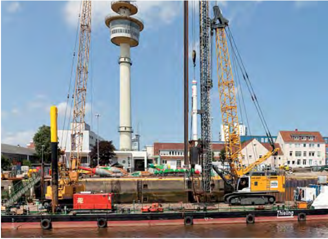
Das Liebherr-Rammgerät LRH 400 rammt von einem Ponton aus wasserseitig die Spundbohlen vor die bestehende marode Kaimauer. (Foto: Liebherr)
