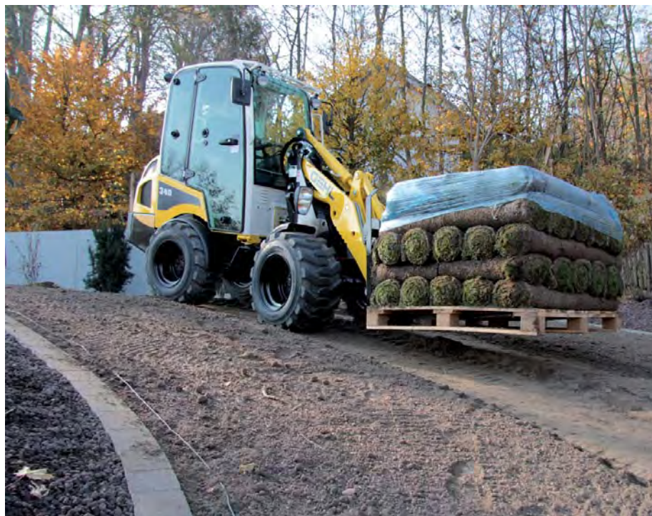
Lade- und Transportarbeiten von Paletten sind für den Knicklader Gehl AL 340 ein Kinderspiel. (Foto: Manitou)
