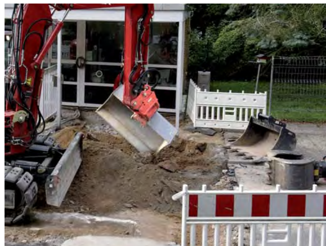
Mit 2 x 70° Schwenkwinkel bietet der Lehmatic Powertilt höchste Flexibilität auf der Baustelle. (Foto: Lehnhoff)
