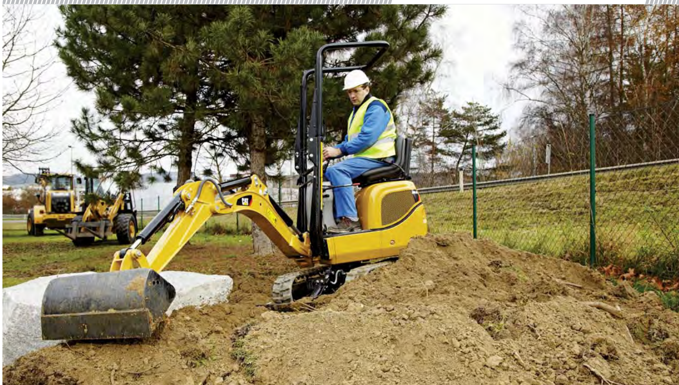
Maschinen wie dieser Mikrobagger sind im GaLaBau vielseitig einsetzbar. (Foto: Zeppelin)
