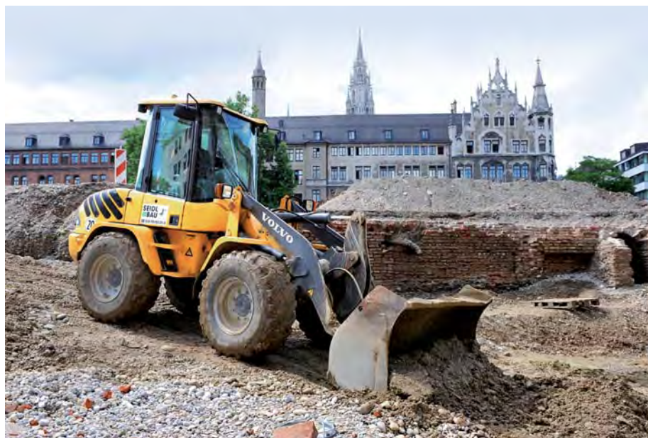
Der LB30 PRO leistet bei der Freilegung der historischen Fundamente Präzisionsarbeit. (Foto: Volvo CE)
