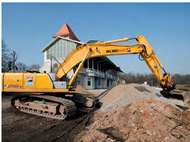
Aus dem HKL-Mietpark war u. a. ein Kettenbagger von Kobelco bei der Sanierung der Leipziger Galopprennbahn im Einsatz. (Foto: HKL)
