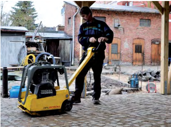
Die Verdichtungsplatte DPU 3050 lässt sich leicht transportieren und erzielt beste Verdichtungsergebnisse.
