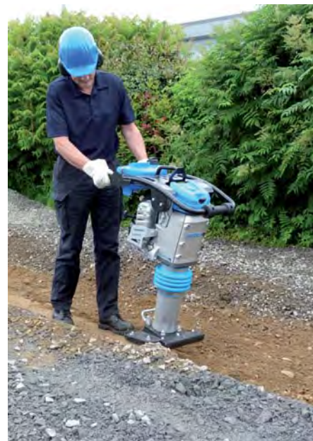
Der neue Vibrationsstampfer SRV 650 wiegt 70 kg und hat eine Schlagzahl von 670 1/min. (Foto: Weber MT)
