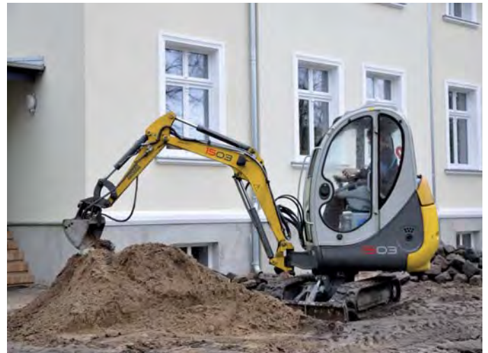
Kompakt, wendig und zuverlässig erledigt der Kleinbagger 1503 sämtliche Tiefbauarbeiten. (Fotos: Wacker Neuson)
