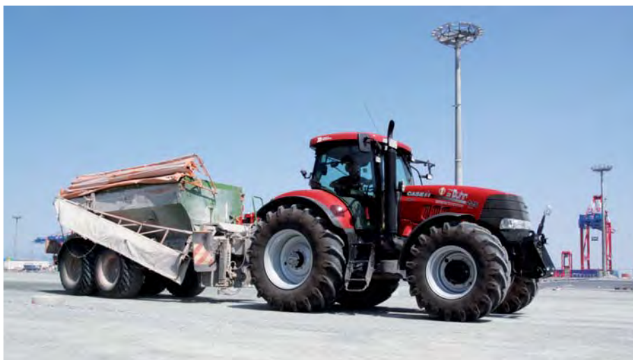
Ein Puma verteilt mit Hilfe eines Kalkstreuers Rollsplitt, der anschließend mit Asphalt aufgespritzt wird. (Fotos: CNH)
