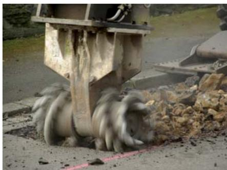
*Die TW110 reißt Asphalt-schichten zuverlässig auf – eine ideale Lösung, wenn es schnell und günstig gehen muss. (Foto: Terex)*
