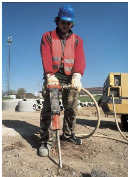
*Presslufthammer der neuen Generation erfüllen werksseitig die Anforderungen der neuen Vibrationsrichtlinie. (Foto:DGUV)*
