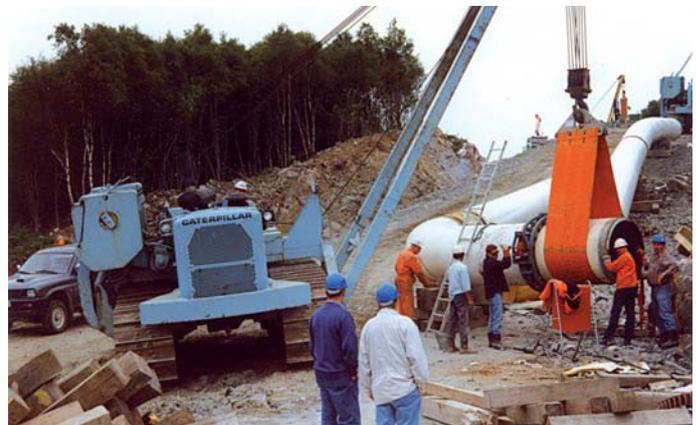
**Seilbaggerfahrer müssen sehr präzise** und abgestimmt arbeiten, um den fertig geschweißten Rohrstrang in den vorbereiteten Graben abzusenken. (Fotos: vdbum)
