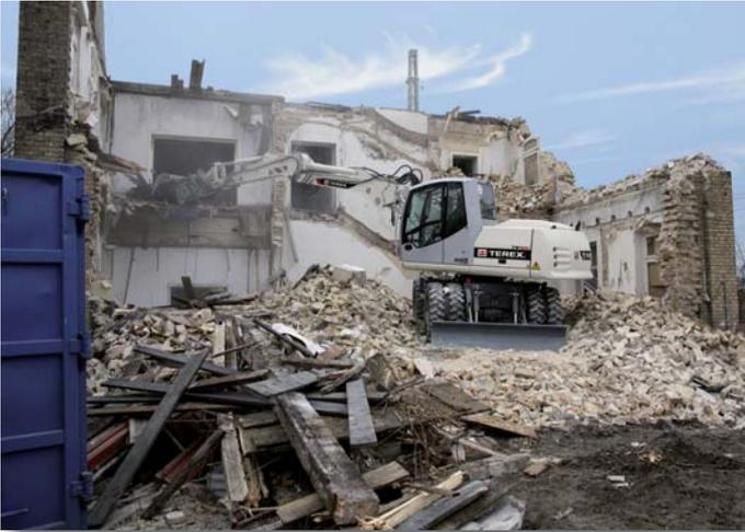
Beim Abbruch der Innenwände entpuppte sich die Reichweite des Baggers von 9,2 m als äußerst vorteilhaft.
