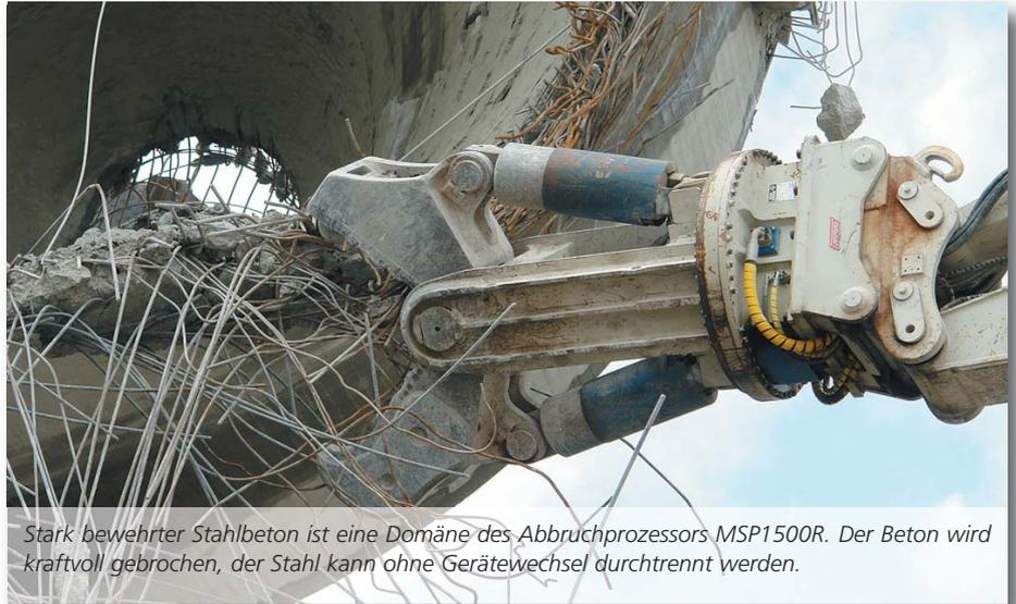
Stark bewehrter Stahlbeton ist eine Domäne des Abbruchprozessors MSP1500R. Der Beton wird kraftvoll gebrochen, der Stahl kann ohne Gerätewechsel durchtrennt werden.
