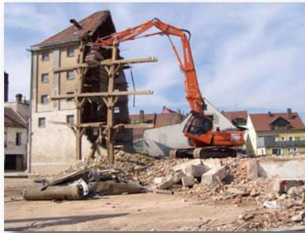
*Gerätebreite, Höhe und Einsatzgewicht mit Werkzeug erlauben dem Doosan DX 300 demolition den Transport auf einem gewöhnlichen Tieflader ohne Sondergenehmigung.*
