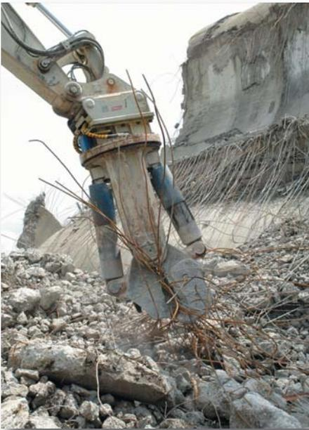
In der Nachzerkleinerung am Boden überzeugt der robuste MSP1500R mit hoher Produktivität. Die gute Brechleistung sorgt für sortenreines Material, das oft ohne Zwischenstufe dem Brecher zugeführt werden kann.
