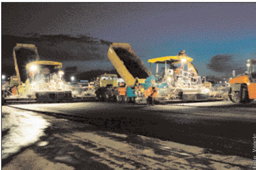
Einbau des Niedrigtemperaturasphaltes auf der Nordbahn des Frankfurter Flughafens. Im Einsatz: je ein Fertiger vom Typ Super 1900 und Super 2100 von Vögele.
