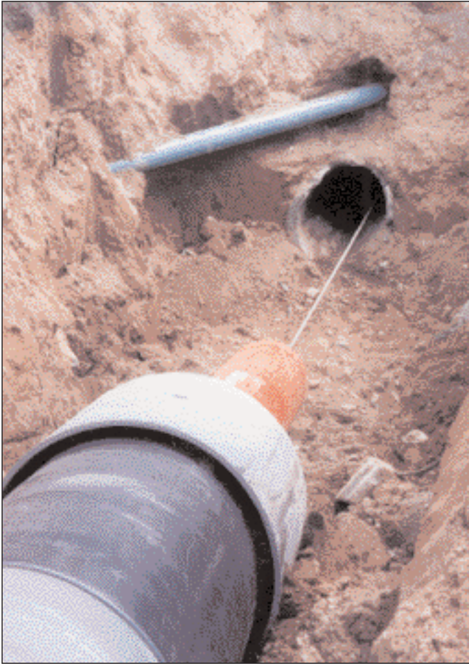
Dynamisches Berstlining: Der Rammkörper mit Aufweitung wird in die berstfähige Altleitung gezogen und zieht gleichzeitig ein Neurohr ein.
