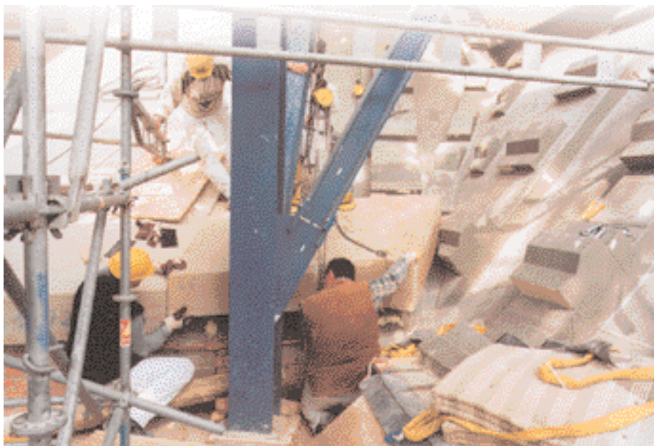
Plangerechte Präzisionsarbeit über alle Bauphasen
