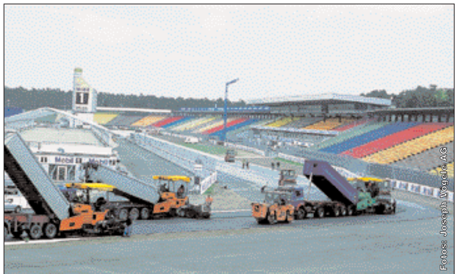
Rennstreckenumbau im Renntempo: Bei Einbaubreiten zwischen 9 und 18 m waren insbesondere in den Kurvenbereichen – wie hier in der Nord-Kurve – bis zu drei parallel einbauende Fertiger vom Typ Super 1900 im Einsatz
