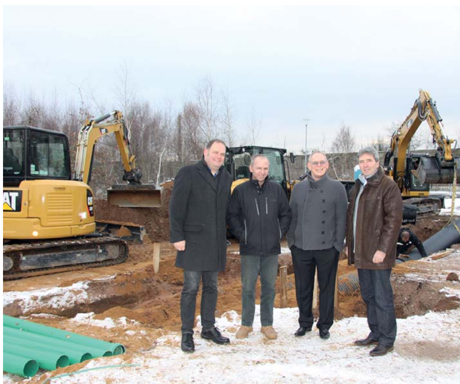
Mithilfe der neuen Cat-Geräte , die Oliver Odendahl, Zeppelin-Verkäufer (l.), übergab, packen sie die Erschließung von Wohnraum an: Ralf Reuß, Geschäftsführer der Abbruchfirma Reuss, Dirk van Hoek, Geschäftsführer von Traumhaus, und Otfried Sinner, Geschäftsführer von RSH Tiefbau (v.l.). (Fotos: Zeppelin)
