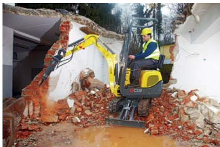
Der Kompaktbagger ist bestens für Renovierungen und Abbrucharbeiten in Gebäuden geeignet.
