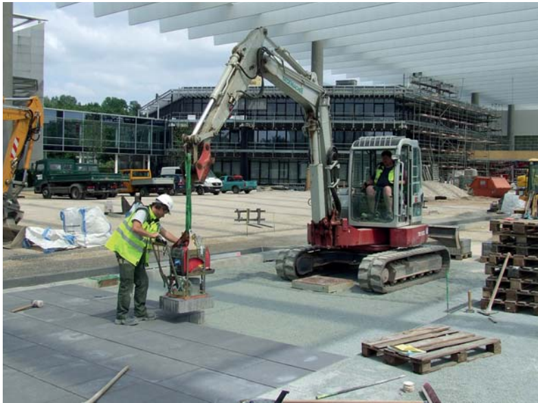
Mit dem Vakuum-Anbaugerät lassen sich auch besonders großformatige und schwere Steine sicher handhaben und exakt verlegen. (Foto: Probst)
