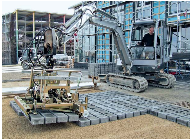
Eine hydraulische Verlegezange am Bagger steigert die Produktivität bei Pflasterarbeiten. (Foto: Probst)
