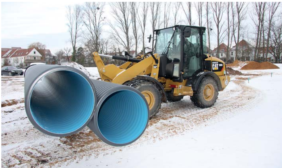
Die Kompaktgeräte müssen dafür Sorge tragen, dass 220 m Schmutzwasserleitung DN 600 und 150 m Schmutzwasserleitung DN 550 verlegt werden.
