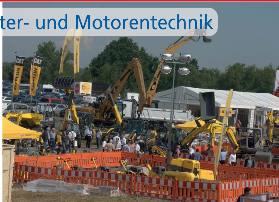
Maschinen im praxisnahen Einsatz werden auf der Musterbaustelle Straßen- und Kanalbau zu sehen sein. (Foto: VDBUM)
