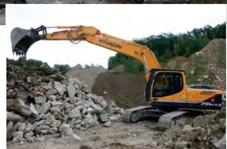
Die Gesteinsbrocken werden für den Brecher herausgesiebt, der das Recyclingmaterial auf die gewünschte Körnung für die Wiederverwendung bricht.
