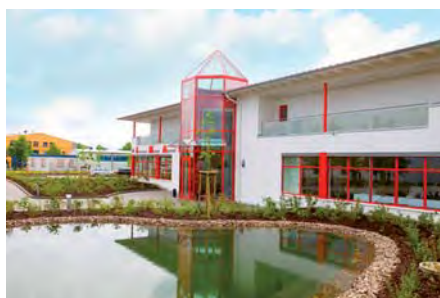
Die Internationale Hydraulik Akademie in Dresden veranstaltet zum dritten Mal eine Instandhaltungs- und Servicetagung. (Foto: IHA)
