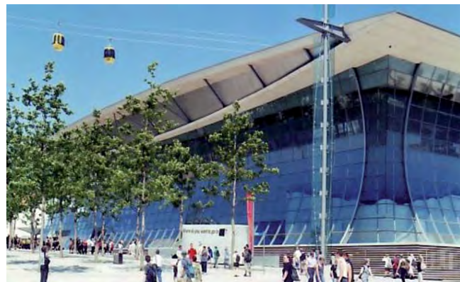
Zur Expo 2000 übernahm die Firma Duensing die Stahlbetonarbeiten am Deutschen Pavillon.
