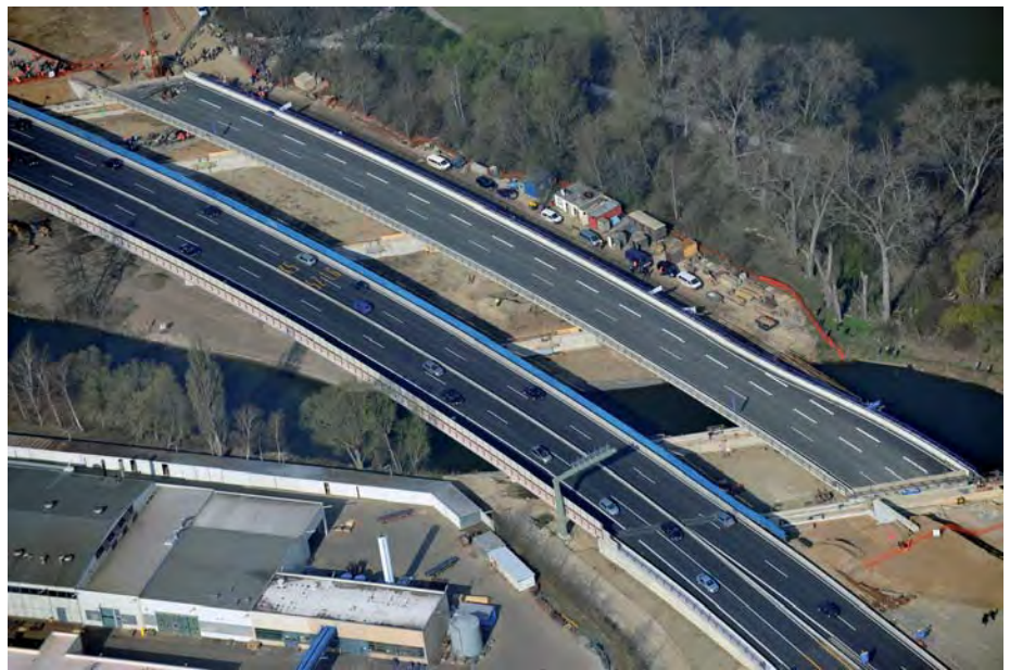
Die 212 m lange und 8.000 t schwere Brückenhälfte wird in ihre endgültige Position verschoben. (Foto: Eurovia)
