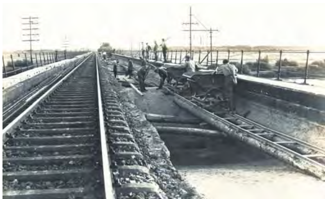
Großauftrag: Die Gleisbauarbeiten 1932 an der Allerbrücke bei Verden dokumentieren den Aufstieg des Unternehmens Duensing.
