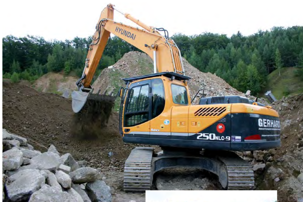
Mit einem SMP-Gitterlöffel separiert der Bagger das vorgebrochene Abbruchmaterial. (Fotos: MK/Hyundai)
