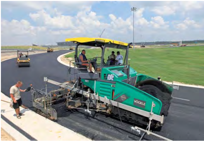
Zur Nivellierung von langen Unebenheiten wurde der Big-MultiPlex-Ski eingesetzt.
