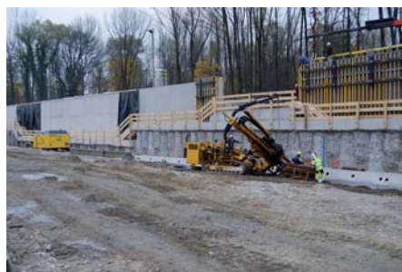
Mit mehr als 20 bar Betriebsdruck wird der Imlochhammer mit dem Compair-Hochdruckkompressor betrieben und gleichzeitig das Bohrloch frei geblasen.
