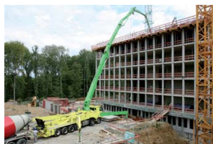
Eine Putzmeister M58-5 bei einer Hochhausbetonage. Der Beton wird über einen Fahrmischer zugeführt. (Foto: Putzmeister)
