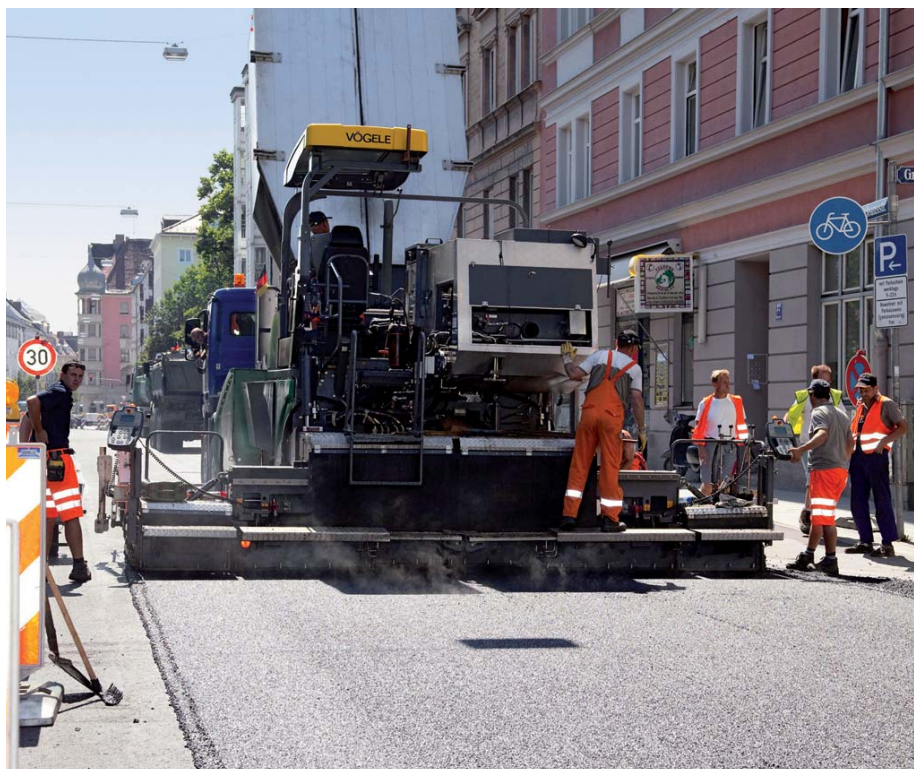
Die Einbaubreite des Vögele-Fertigers mit SprayJet-Modul betrug in der Münchner Orleansstraße 6 m.
