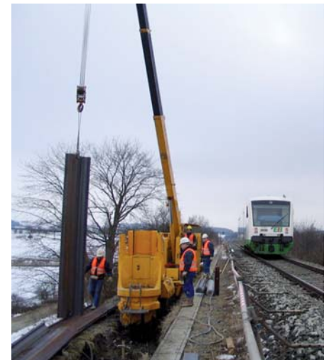
GRB-System (Presse, Klemmkran, Unit Runner) im Einsatz.
