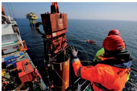
Alpha Ventus – Rammen von 160 t schweren Rohren mit dem Vibrator MS-200 H HF. (Foto: Alpha Ventus Pressebild).
