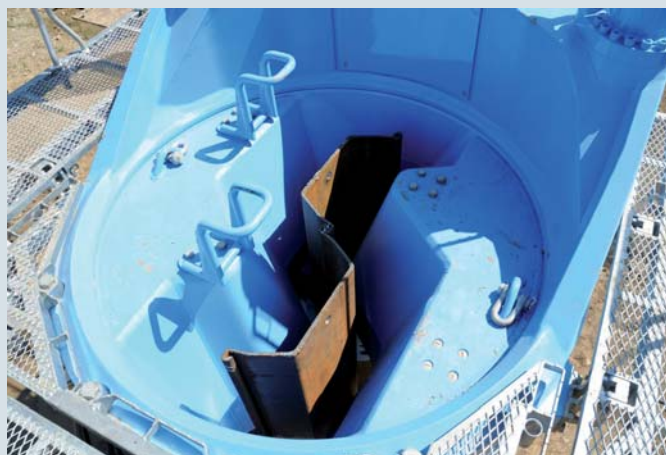
Einbringen von Doppel-U-Profilen Illw (entspricht Larssen 604/605).
