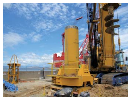
Je nach Bodenbeschaffenheit kommt die Verrohrungsanlage BV 2000 zum Einsatz, um die Bohrrohre bis auf 42 m Tiefe einzubringen.
