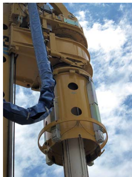
Der Drehmomentverstärker BTM 720K verdoppelt die Kraft, mit der das Bohrgerät Typ BG 40 das Bohrrohr in den Boden einbringt.
