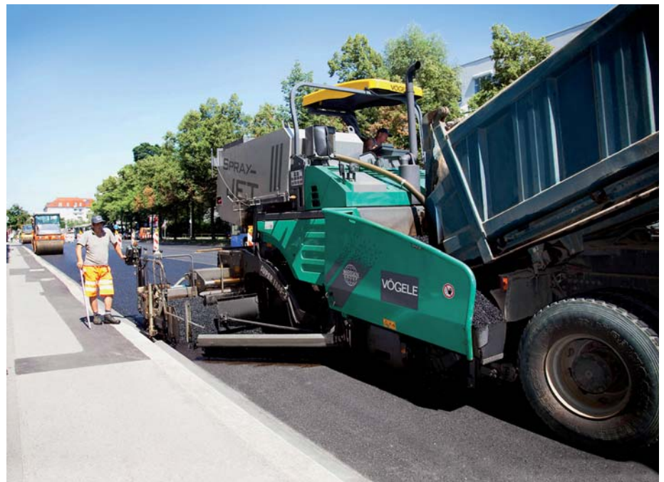
Deckschichteinbau mit lärmarmem Splittmastixasphalt durch einen Vögele Sprühfertiger. (Fotos: Vögele)
