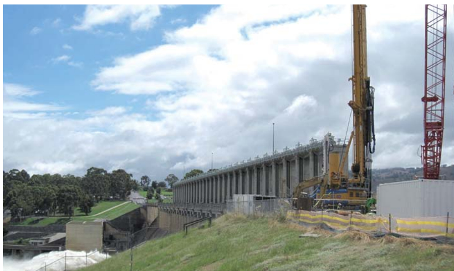
Der Hume Damm im Südosten Australiens wird saniert und erhält ein neues Filter- und Drainagesystem aus 130 voll verrohrten Kies- und Sandpfählen. Der Spezialtiefbauer AFS setzt dafür eine Bauer BG 40 ein. (Fotos: Bauer)
