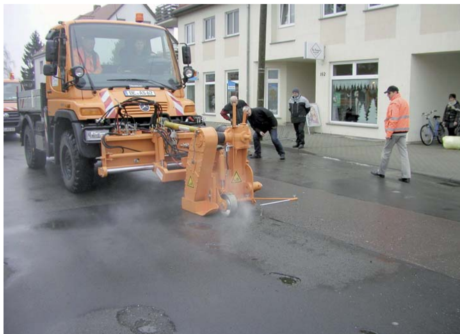
Die Fräsleistung des Unimog beträgt in der Breite bis 500 mm bei einer stufenlos einstellbaren Tiefe zwischen null und 100 mm. (Foto: Daimler)
