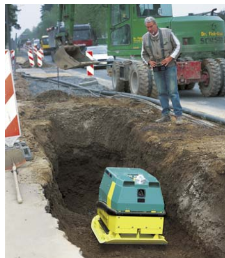
Kann bequem vom Grabenrand aus gesteuert werden: Die Rüttelplatte AVH 1.000 TC von Ammann. (Fotos: Ammann)
