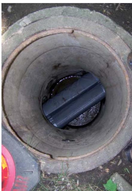
*Blick auf den Schlauchliner am Zwischenschacht, wo er durch Überdehnenschutz gesichert wird.*
