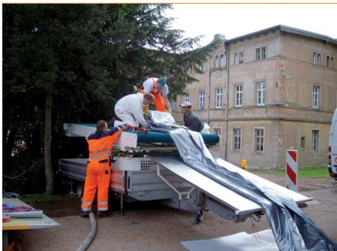
Inzwischen gehört die grabenlose Sanierung von defekten, undichten Kanal- und Rohrleitungen zum Standard. Dafür gibt es heute eine Vielzahl an Verfahren, die je nach zu sanierendem Kanal entscheidende Vorteile mit sich bringen. So entschied sich die bauausführende Unternehmung Max Bögl zur Sanierung zweier Mischwasserleitungen an historischer Stätte für das nahtlose, lichthärtende Schlauch-Liner-Verfahren von Brandenburger. Lesen Sie dazu den Beitrag auf Seite 6.
