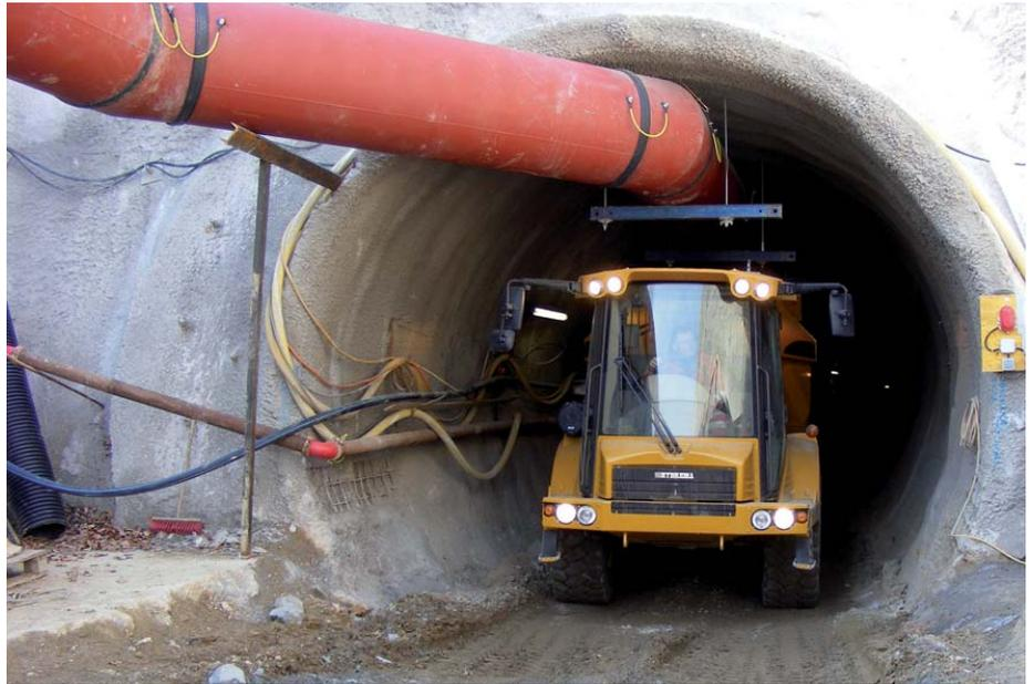
Der Hydrema 912D transportiert den Abraum aus dem Tunnel.
