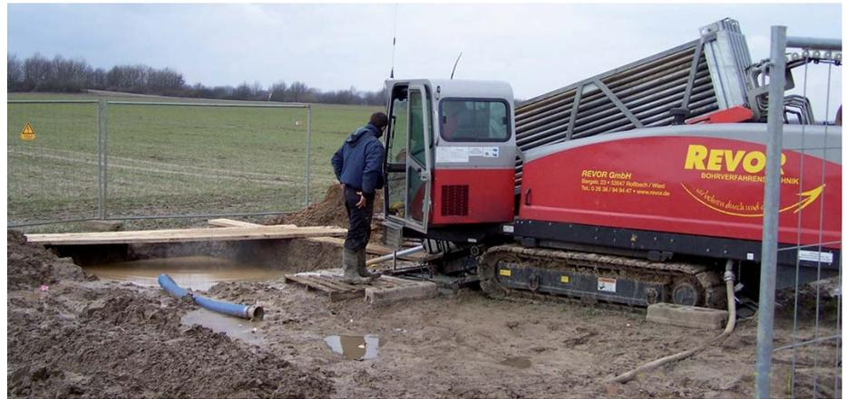
Die Bohrung erfolgte mit einer Grundodrill-Bohranlage, hier bei der Pilotbohrung.
