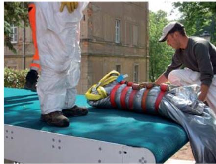
Der fertig gebundene Schlauchlinerkopf wird über das Förderband eingezogen.
