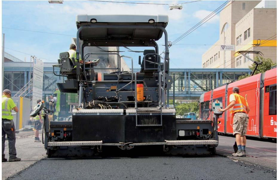
Im Bereich des Düsseldorfer Busbahnhofs erfolgte der Einbau des Spezialmaterials Densiphalt mit Super-Fertigern.
