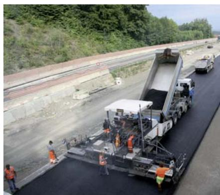
**Beschicken, einbauen, kontrollieren:** Das Einbauteam hatte keine Mühe, alle wichtigen Parameter im Blick zu behalten. (Fotos: Vögele)
