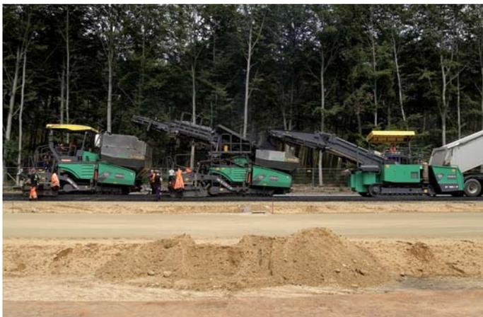
**Der Zug besteht** aus 3 Maschinen: einem Materialbesicker, einem Binderschichtfertiger und einem Deckenfertiger. (Fotos: Hamm)
