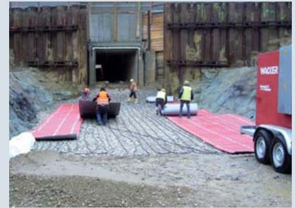
**Durch die ausgelegten** Schläuche fließt ein 80 °C heißes Gemisch, das den Boden erwärmt. Eine Plane hält die Wärme am Boden. (Foto: Wacker Neuson)
