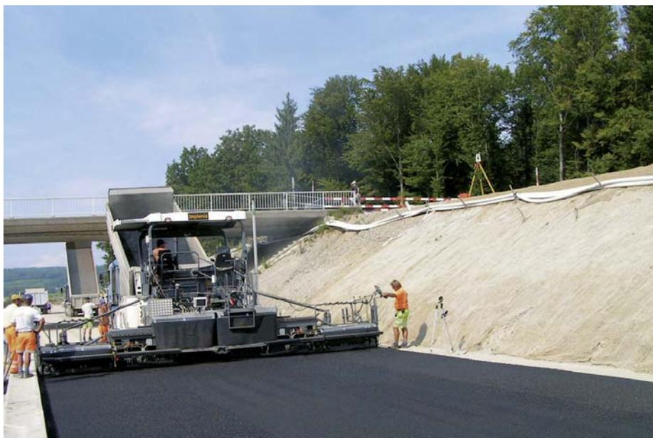
**Neubau ohne Leitdraht:** Das 3D-Steuerungssystem Navitronic Plus führt den Super 2100-2 zu einem hochpräzisen Ergebnis.
