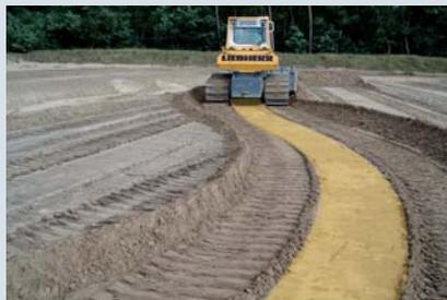
Mit der neuen Maschinensteuerung erfolgt die Planie schneller und ist trotzdem präzise. (Foto: Topcon)
