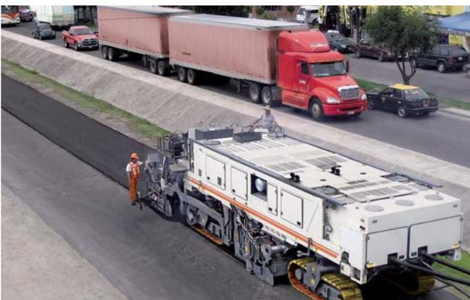
**Kaltrecycling mit Schaumbitumen:** Das Verfahren zur Straßensanierung ist kostengünstig und erzeugt langlebige Tragschichten, hier im Einsatz der WR 4200, der größte Wirtgen-Recycler.
