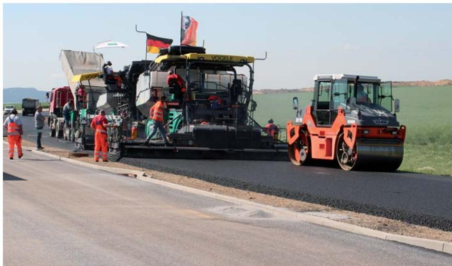
Bei Bautzen wurde die 5,5 km lange Strecke mit dem InLine Pave-Einbauverfahren erstellt und mit Hamm-Oszillations-Tandemwalzen verdichtet. (Foto: Hamm)
