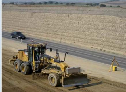
Mit dem GCS900 3D Maschinensteuerungssystem und der Trimble UTS erstellt der Graderfahrer die Feinplanie ganz ohne Absteckpflöcke. (Foto: Trimble)
