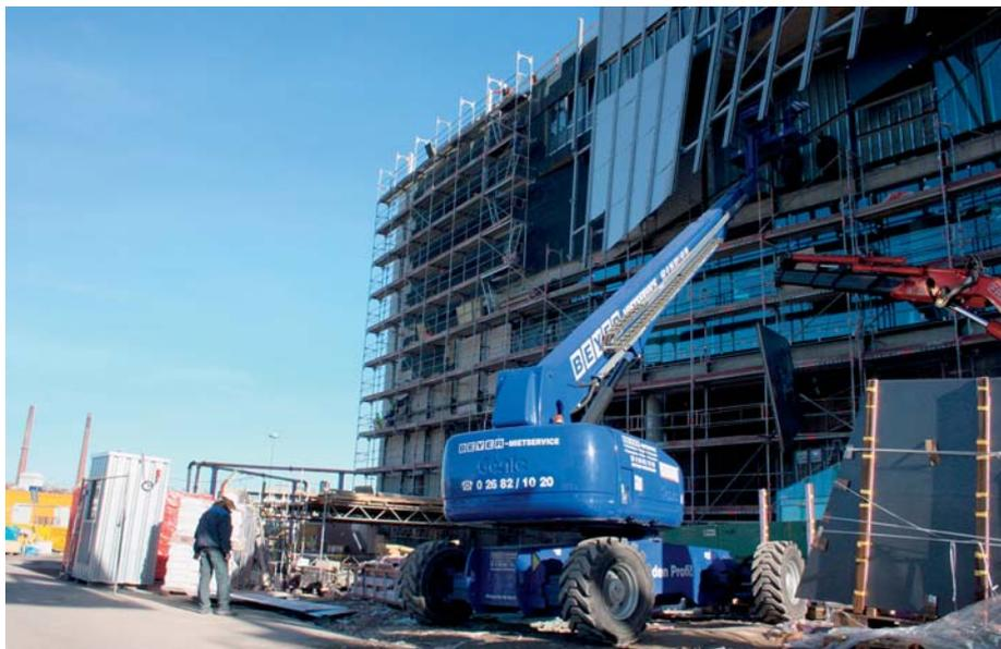
Mit Hilfe einer Beyer-Teleskopbühne erfolgen Montagearbeiten an der Unterkonstruktion der attraktiven Fassade. (Foto: Beyer)
