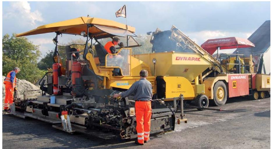
Der DF 145 CS und der Beschicker MF 250 bilden ein erfolgreiches Gespann. So sind theoretische Förderleistungen von bis zu 2.500 t/h möglich.
