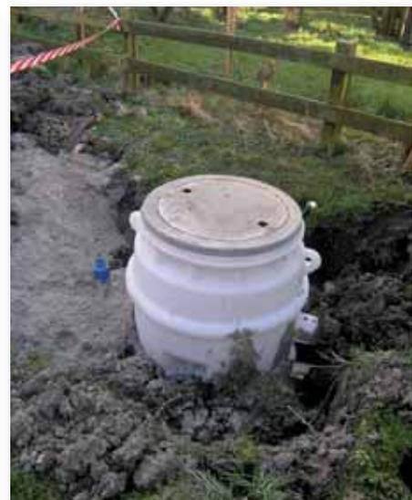
Hier im Bild ein Abwasserpumpschacht, an dem bis zu zwei Häuser angeschlossen sind.
