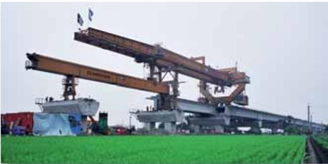
Sieger Kategorie „Bauwerk/Bauverfahren“: koppelbarer Schwerlast-Portalkran für die Herstellung und Verlegung für Betonfertigteillbrücken. (Foto: Bilfinger Berger)
