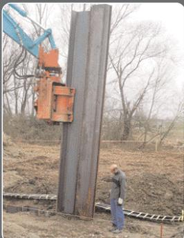
Einfädeln der Spundbohle ohne fremde Hilfe.
