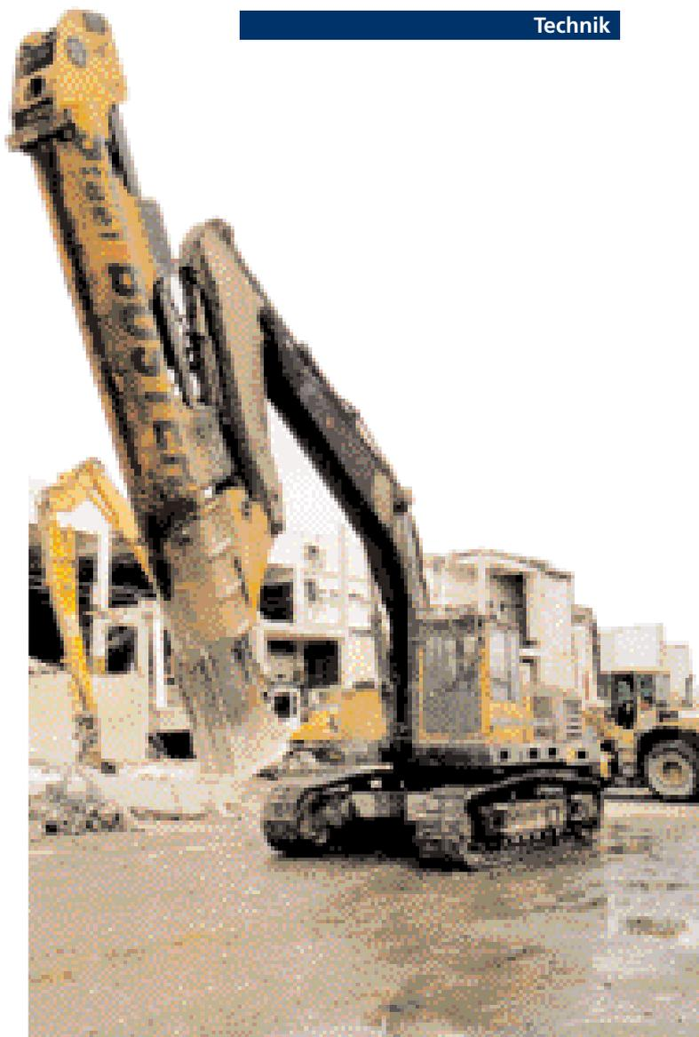
Beton schon zu einem großen Anteil sauber von der Armierung getrennt, der nachträgliche Einsatz einer Pulverisierzange reduziert sich erheblich. Die Korngröße der Betontrümmer liegt bei maximal 45 cm – ideal für die Weiterverarbeitung in Prallmühlen. Die nahezu sauberen Stahlelemente lassen sich fast ohne weitere Aufarbeitung z.B. an Stahlwerke verkaufen.
