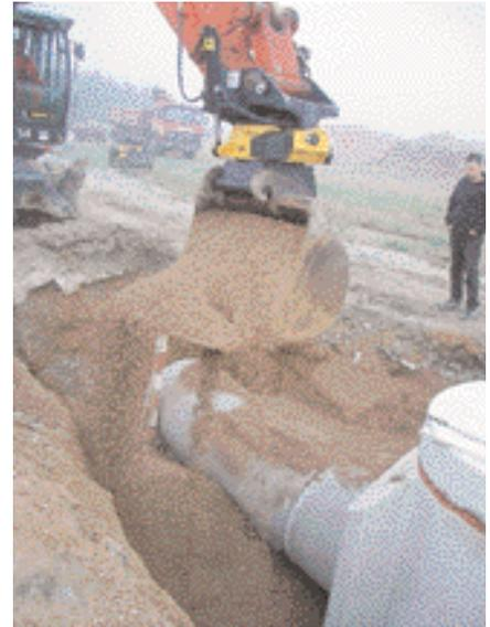
Seitliches Verfüllen von Rohren im Zwickel – egal wie der Bagger steht.
