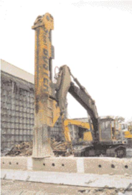
Mit bis zu 200.000 Joule können selbst große Beton-Bauteile in kurzer Zeit zertrümmert werden. (Fotos: Olaf Meier)
