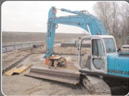
Mit der Seitengriff-Doppelklemmzange wird die Spundbohle gefasst...
