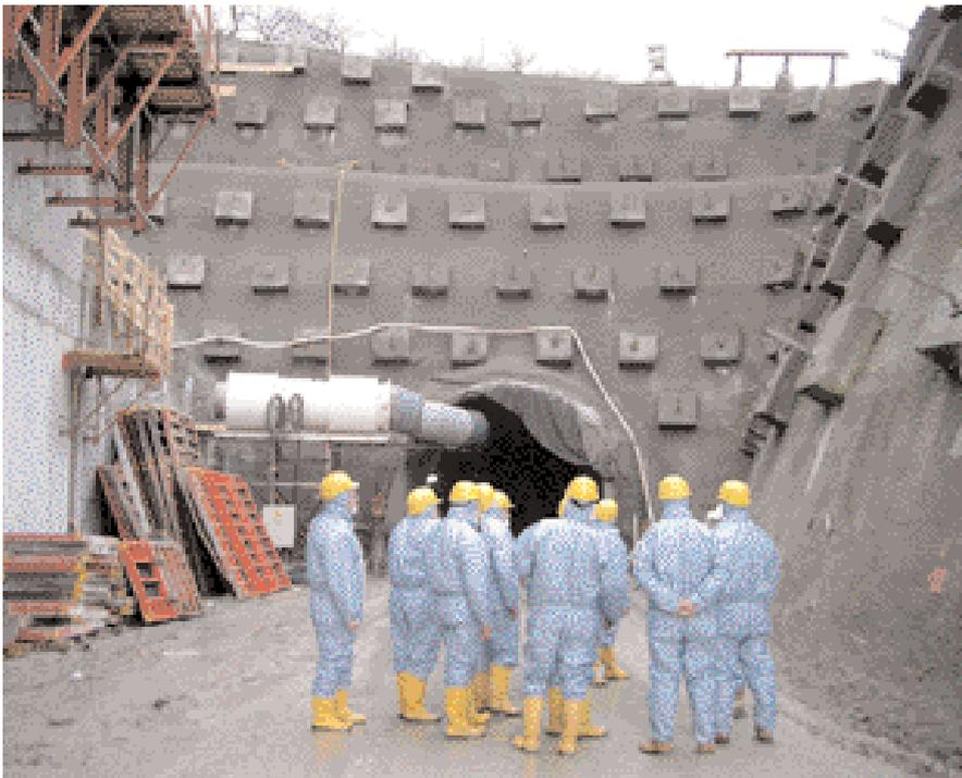
Baustellenbelüftung durch Luttenlüfter und Belüftungsleitungen durch den Fluchttunnel am Südportal.
