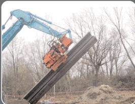
...aufgerichtet und zum Rammansatzpunkt verschwenkt.
