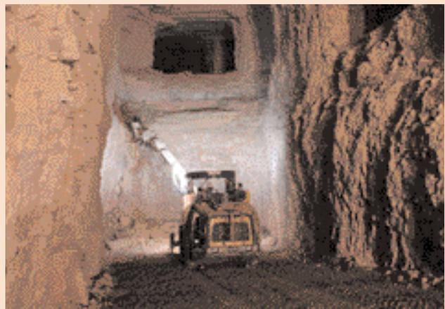
Für die Bohrarbeiten kommt ein Rocket Boomer L1D, mit aufgebautem COP 1836 HF Bohrhämmer zum Einsatz.
