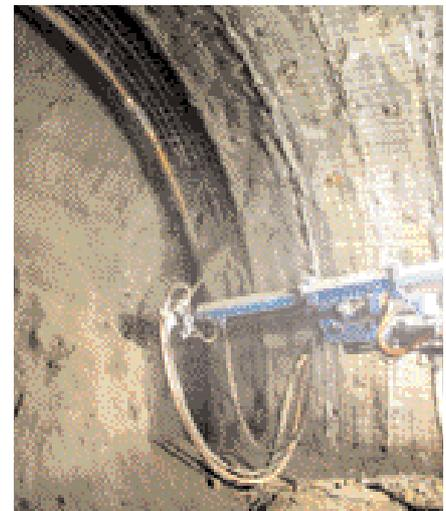
Schritt vier per Foto: Bogen stellen und Betonieren.
