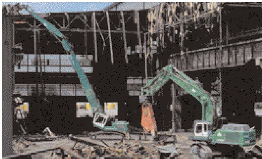
Ganz stark im Verbund: Bagger R 954 B V-HDW Litronic und R 984 C HD Litronic beim Abbruch einer Industriehalle.
