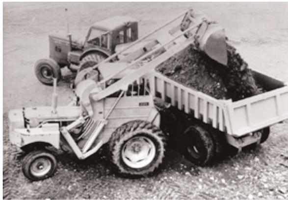
Aus einem „umgedrehten“ Traktor wurde der Radlader H 10, der schon eine erstaunliche Ausbrechkraft entwickelte (Foto: Volvo)
