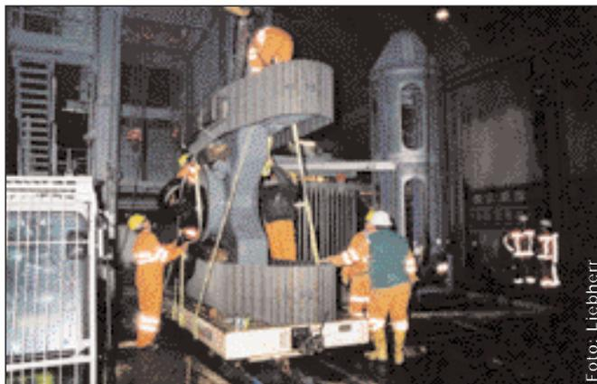
Der komplette Unterwagen des R 904 Litronic wird hochkant auf den Transportwagen verladen und gesichert.
