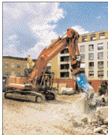
Der Pulverisierer CP 2300 bei der Sekundärzerkleinerung
