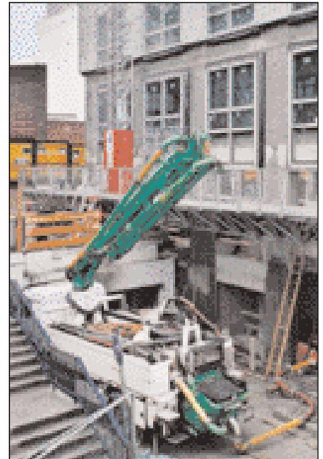
Selbst auf extrem engem Raum findet die 2-Achser-Betonpumpe einen Stellplatz.
