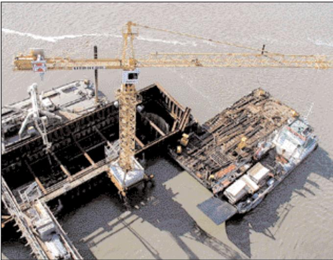
*Baugrube Pfeiler 3 (Autobetonpumpe auf Ponton)*
