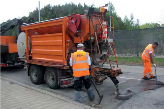
**Die Mischung** des Sanierungsmörtels erfolgt genau dosiert, verteilt wird naht- und kantenlos per Hand. (Foto: VSI)
