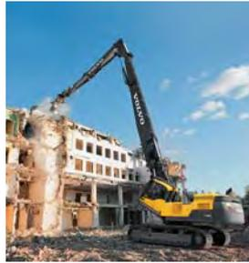
**Abbruchbagger EC480D: Die hydraulisch kippbare Kabine lässt sich 30 Grad ankippen.**
