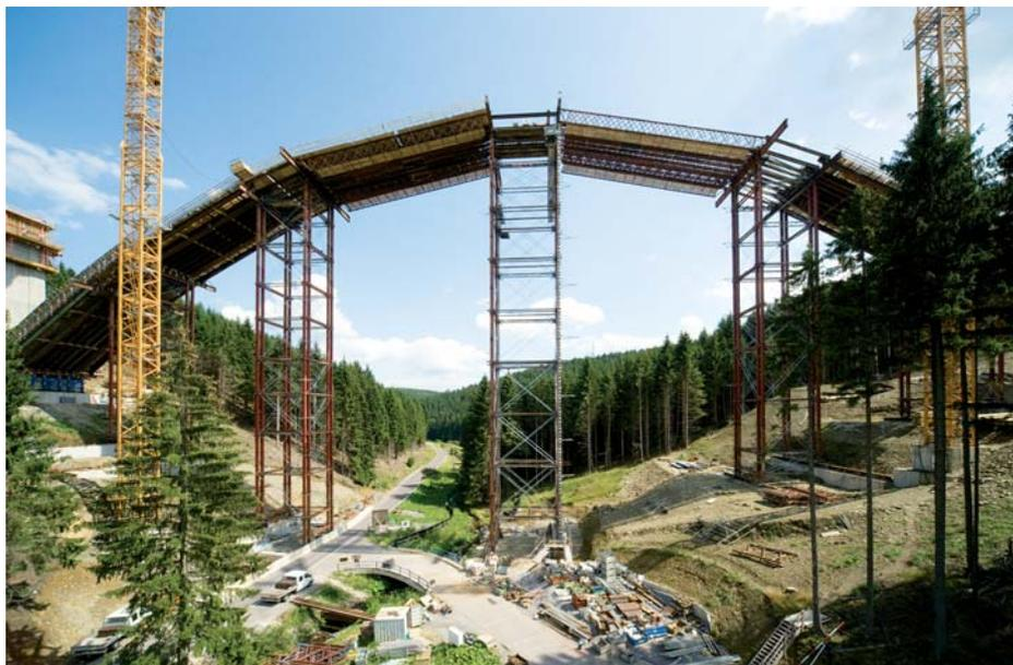
**Der Stahlbetonbogen** der Massetalbrücke hat einen Hohlkastenquerschnitt. Nicht die hohen abzutragenden Lasten, sondern die enorme Bauhöhe stellt eine technische Herausforderung dar. (Fotos: RöRo Traggerüstsysteme)
