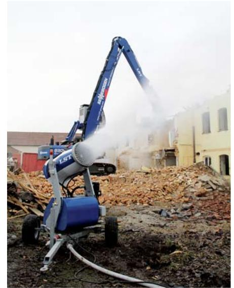
LST Staubbindesystem der Serie DSS im Einsatz. (Fotos: LST)
