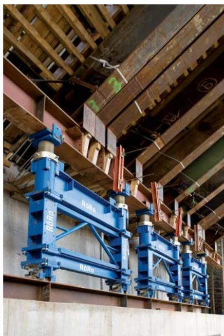
**An den beiden Kämpfern** endet das Traggerüst mit jeweils einem ca. 4 m hohen Stützjoch.
