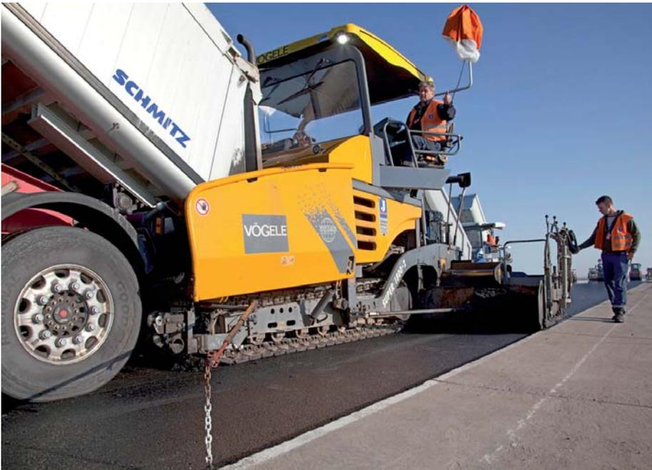
**Daumen hoch** für die Nivellierung. Ultraschall-Multi-Sensoren tasteten die Ränder der Bahnen ab.
