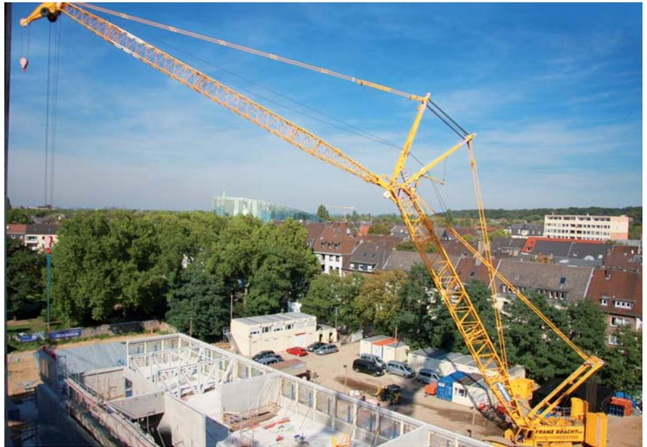
**Der neue Sennebogen 7700** mit 300 t Traglast ist bei dem Neubau des Berufskolleg Mitte in Duisburg im Einsatz. Mit 29,9 m Hauptausleger und 41,1 m Spitzenausleger werden die erforderlichen Arbeitsradien bis 60 m erreicht. (Foto: Sennebogen)
