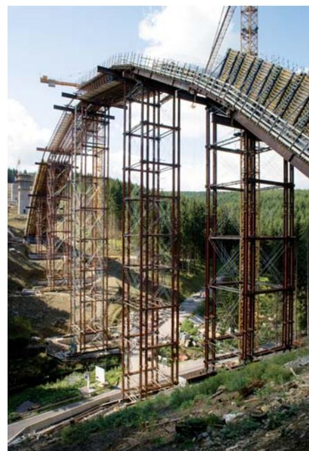
**Alle fünf Gerüsttürme** bestehen aus dem Schwerlaststützen-System S 250 von RöRo.
