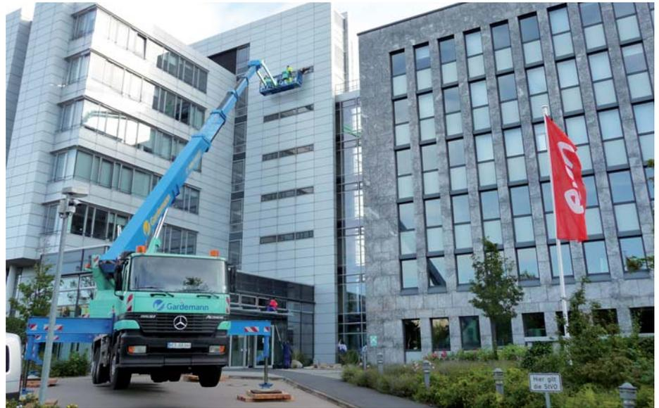
**Eine optimale Lastverteilung** auf eine größere Fläche erreicht man durch die Wahl des richtigen Arbeitsbühnenmodells und die Unterlage von Holzbrettern oder Hart-Kunststoff. (Foto: Gardemann)
