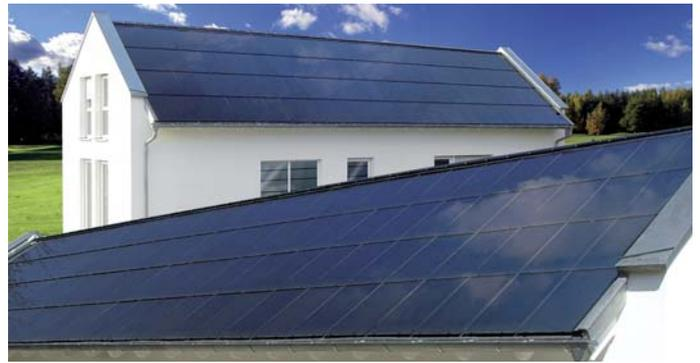
DesignLine Photovoltaikanlage mit GeneCIS-Modulen. Diese Photovoltaikmodule ersetzen Dachziegel. (Foto: Würth Solar)
