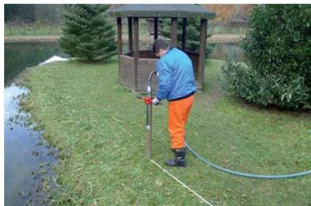
**Einsatzbeispiel der Grundomat-Erdrakete: kurze vertikale Bohrungen für Pfahlgründungen.**
