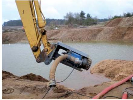
**Innovative Lösung: der Bagger-Adapter nimmt eine Schmutzwasserpumpe auf.**
