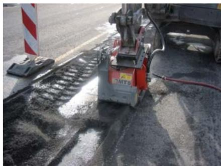
**Ankuppeln und losfräsen funktioniert mit der Asphalt- und Betonfräse problemlos.**
