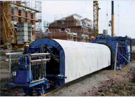
**Der begehbare ISK** zeichnet sich durch eine optimierte Querschnittsgeometrie sowie durch eine spezielle Betonrezeptur aus, die eine Stahlbewehrung erübrigt.
