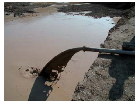
Am andere Ende schießt der verflüssigte Boden aus der Spülleitung. (Fotos: Tsurumi)
