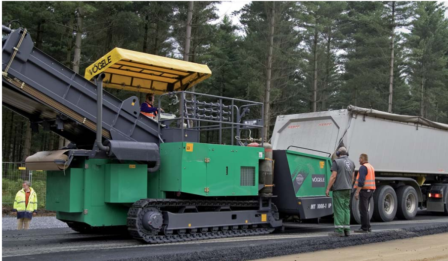
So erfolgt der Asphalteinbau per so genanntem Shuttle.
