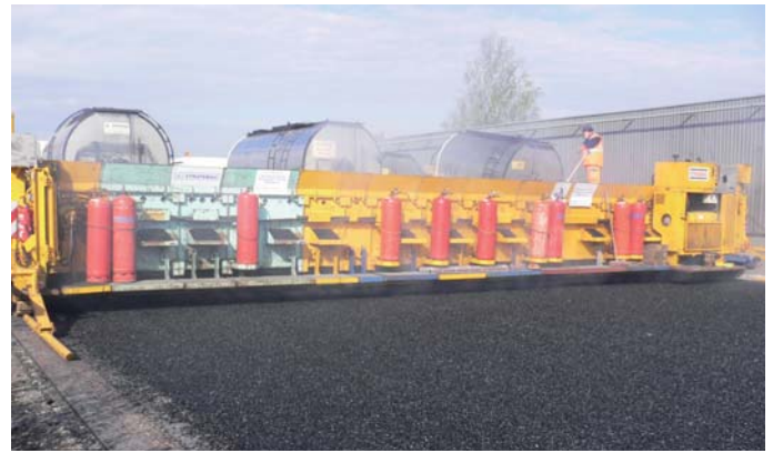
Einbau von Gussasphalt 0/8 als Abdichtung unter PA 8 in einer Breite von 15,50 m.
