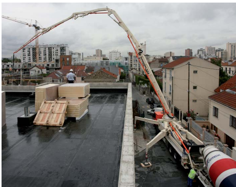
Einsatz einer Autobetonpumpe M 47-5 in einer schmalen Wohnstraße mitten in Paris. Durch das OSS-System kann der große 4-Achser bei nur 8 m Abstützbreite (vorn) sicher aufgestellt und betrieben werden. (Foto: Putzmeister)
