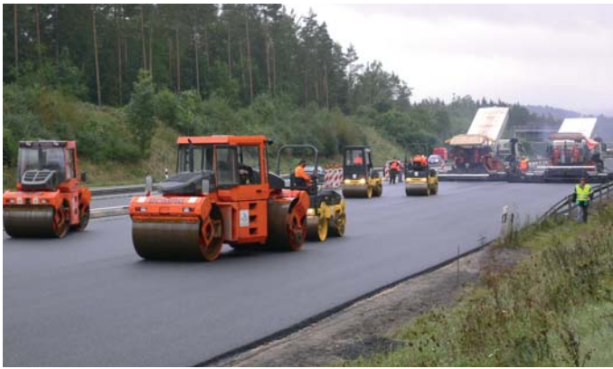
Einbau von einschichtigem offenporigem Asphalt.
