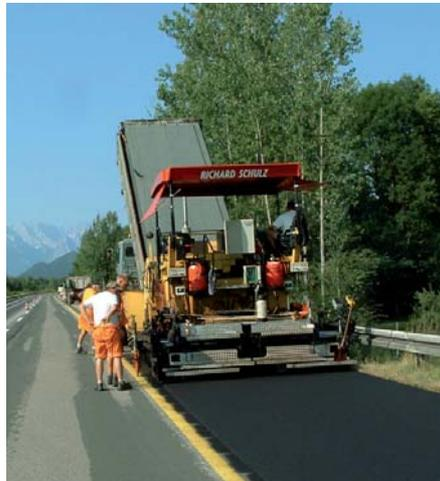
Um die originale Fahrbahndecke zu erhalten, wurde eine dünne Verschleißschicht aufgebracht.
