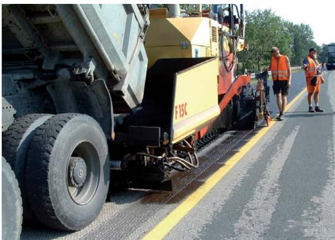
Für die Autobahnsanierung setzte das Bauunternehmen einen Dynapac-Straßenfertiger F 15 C mit integriertem Emulsionssprühverfahren ein.
