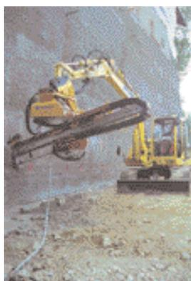
Baugrubensicherung durch Rückverankerung
