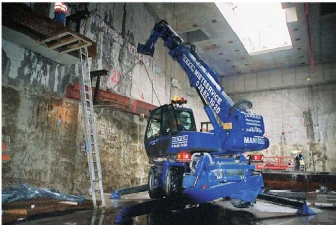
Hoch hinaus untertage: Der Teleskoplader MRT 1850 sorgt beim Bau des neuen U-Bahn-Tunnels in München für einen reibungslosen Ablauf.
