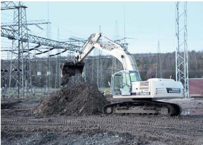
Der Terex TC 240 LC beim Bodenaushub für die neuen Fundamente. Für diese Arbeit ist der Bagger mit einem 700-l-Grabenräumlöffel ausgerüstet.
