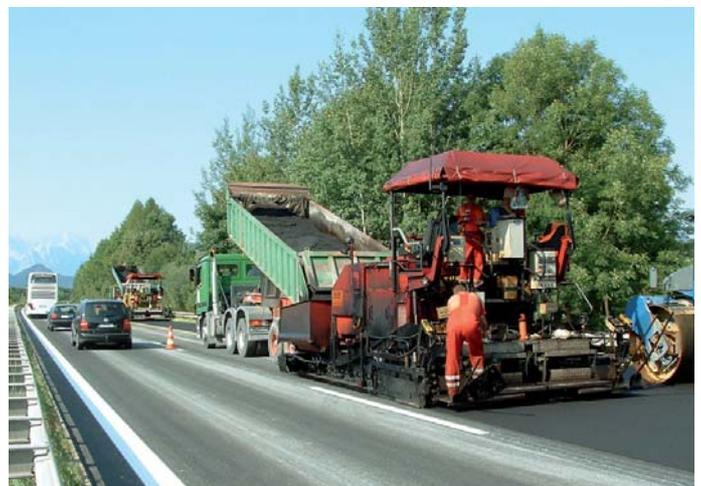
Der Dynapac-Straßenfertiger F 150 C aus der 22-t-Klasse hat eine maximale Fertigungsbreite von 9 m. (Fotos: Dynapac)
