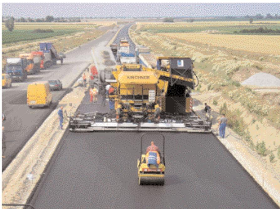
Einbau und Verdichtung von Kompaktasphalt auf der BAB A20.
