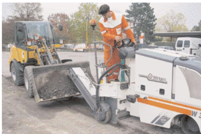
Über das kurze Ladeband kann das Fräsgut ohne Handarbeit z.B. direkt in eine Radladerschaufel verladen werden. (Fotos: Wirtgen)
