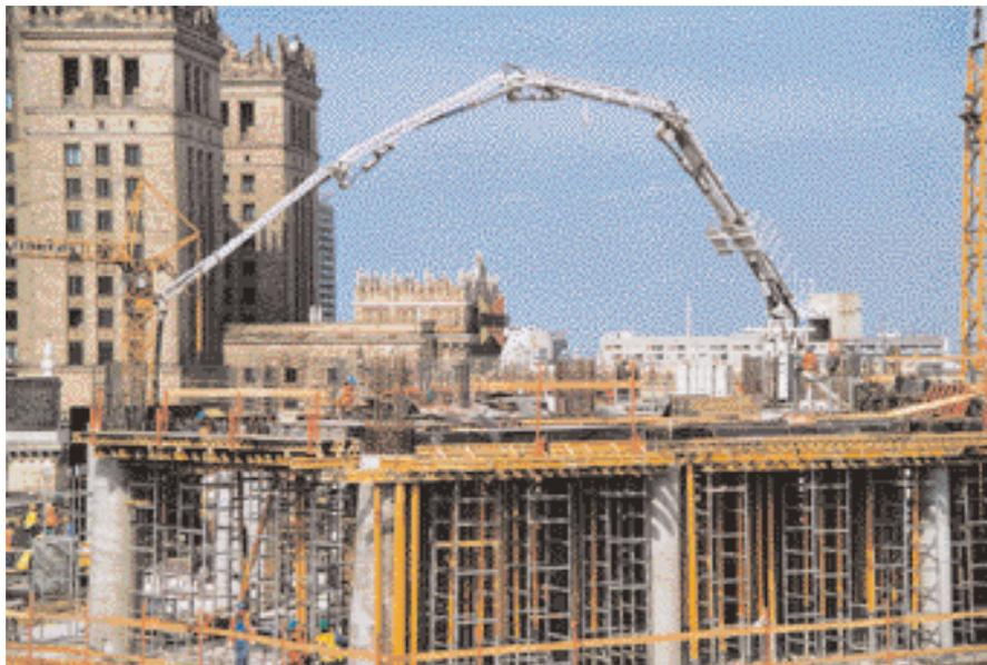
Von einer zentralen Position aus übernimmt der Stationärmast MX 32 T die Betonverteilung in Zone 4. (Fotos: Putzmeister)
