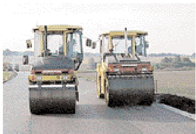
Nachwalzen: Einsatz einer Tandem-Vibrationswalze vom Typ Dynapac CC 432 (rechts).
