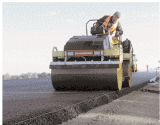
Statisches Andrücken: Einsatz einer Tandem-Vibrationswalze vom Typ Dynapac CC 142 mit extra breiter Bandage.
