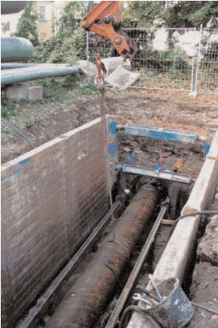
Nach dem Einbau des ersten Vortriebsrohres wurde der Bohrschlitten zurückgefahren und das nächste Vortriebsrohr angesetzt und verschweißt.
