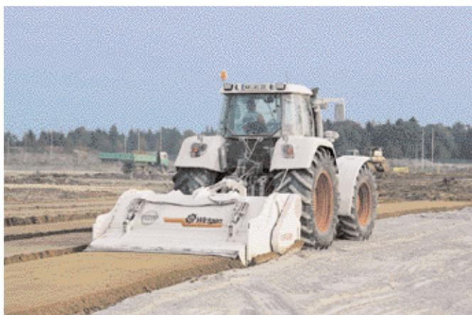
Der mechanisch angetriebene Fräs- und Mischrotor mischt das Bindemittel gleichmäßig über die gesamte Arbeitsbreite ein.
