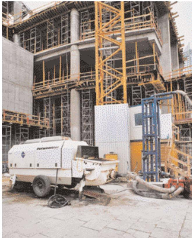
Betonpumpe BSA 2110 HP-D mit „Reinigungs-Galgen“ (blau) und Sperrschieber (rechts im Bild).
