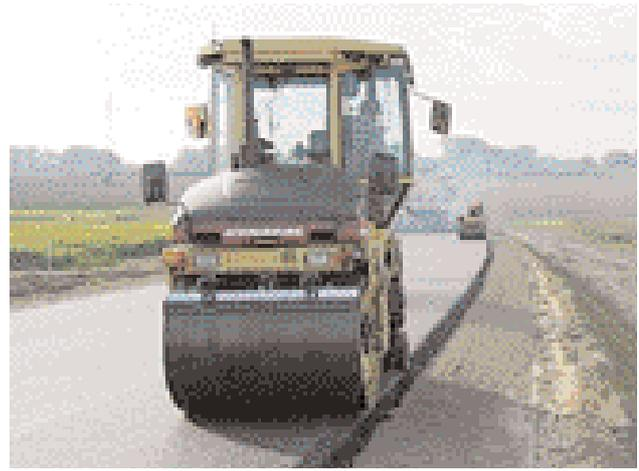
Hauptverdichtung: Einsatz einer Tandem-Vibrationswalze vom Typ Dynapac CG 233.
