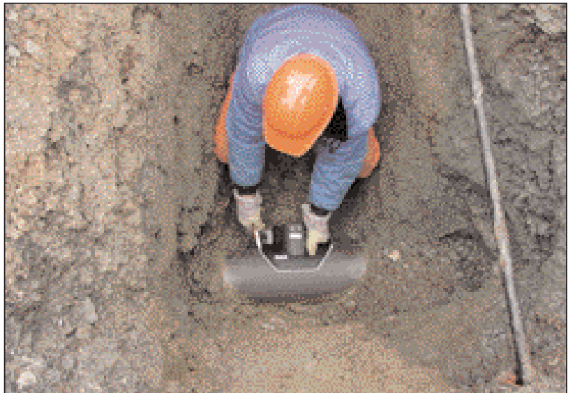
Anbindung der Seitenzuläufe durch passgenaue Friatec-Formteile.
