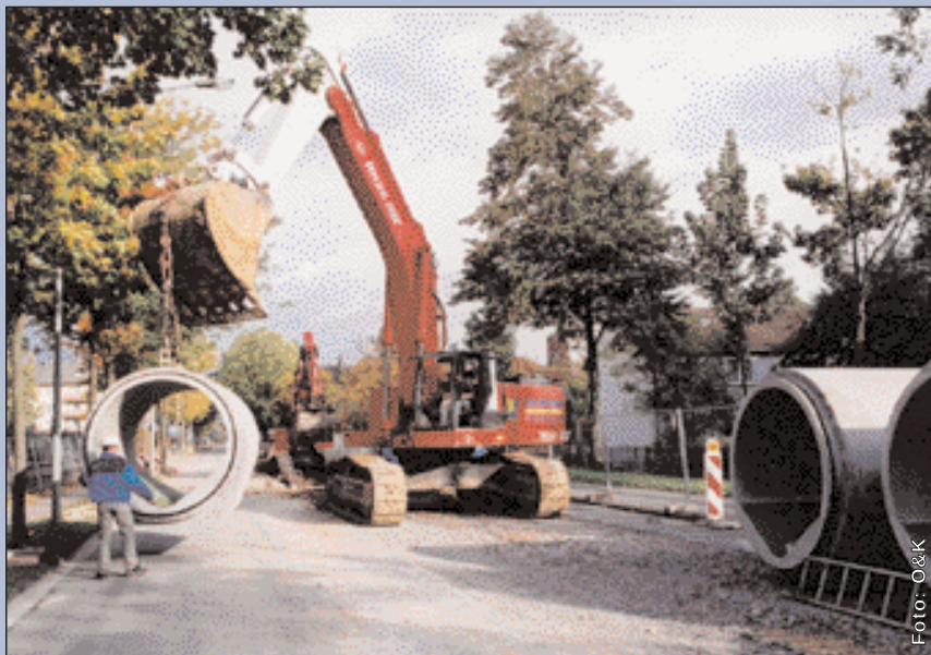
12-t-Rohre und sogar 21 t schwere Schächte hebt er mühelos.
