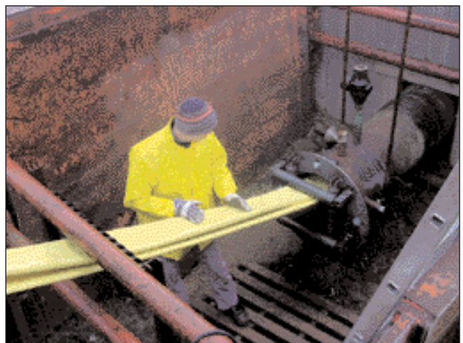
Einziehen der flexiblen Hochdruckleitung.
