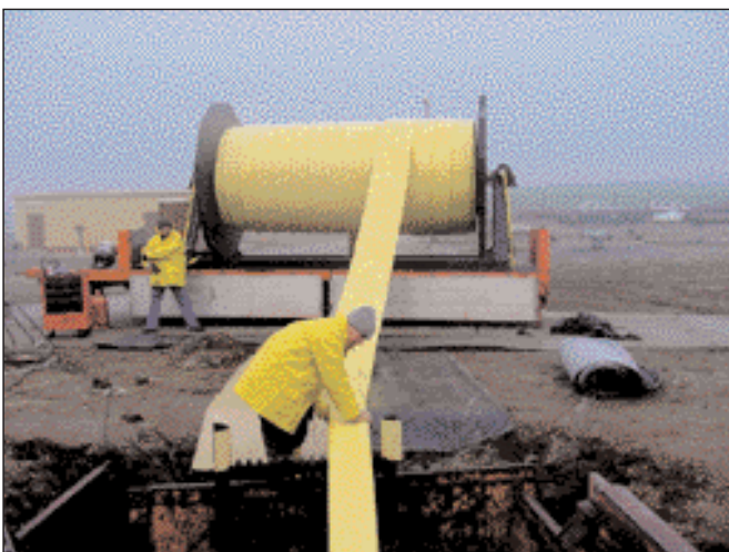
Einziehen der flexiblen Hochdruckleitung.
