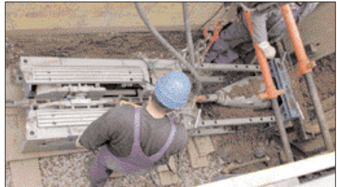
Grabenlose Rohrerneuerung durch das statische Berstliningverfahren von Tracto-Technik.
