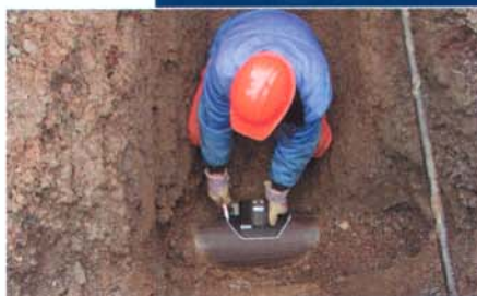
Grabenlose Verfahren bei der Rohrerneuerung
