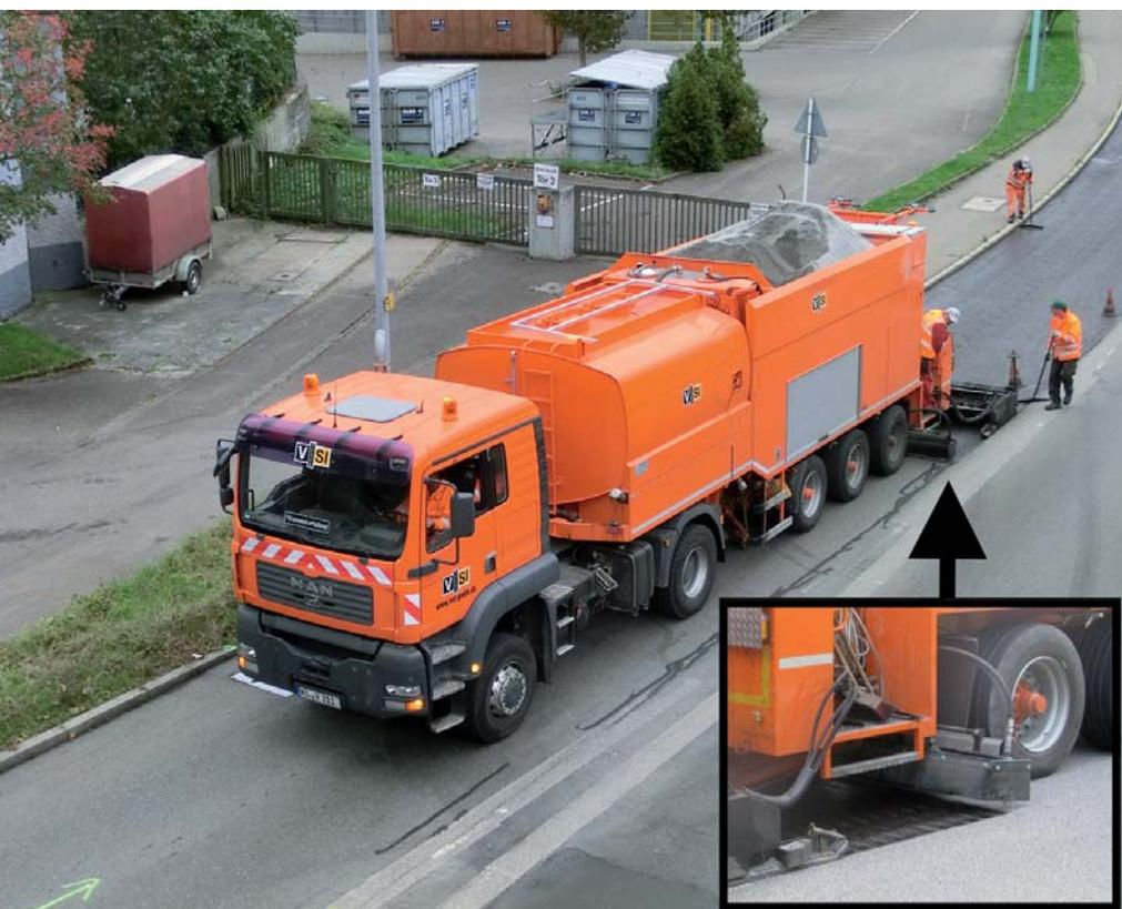
*Die DSK-Maschine mit integriertem Spritzbalken ermöglicht das Vorspritzen von Emulsion vor dem Verteilerkasten während des DSK-Verlegens. (Foto: VSI)*
