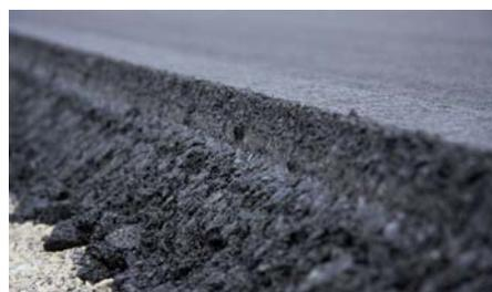
**Die Poren** der Asphalttragschicht werden mit der Gummiradwalze verschlossen, ohne dass der Asphalt aus der Form gerät.
