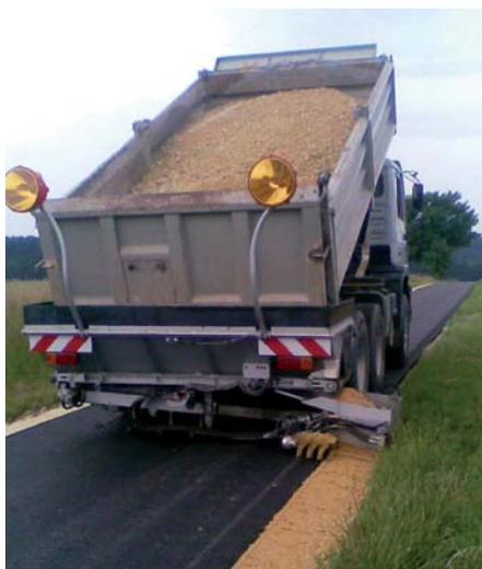
**Der neu entwickelte Anbaufertiger** automatisiert den Bankettbau und die Bankettinstandhaltung. (Foto: Friedl)
