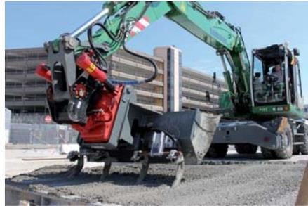
Zum Verdichten des Betons wird der Speziallöffel gedreht, so dass die hydraulischen Innenrüttler durch den Beton gezogen werden können.
