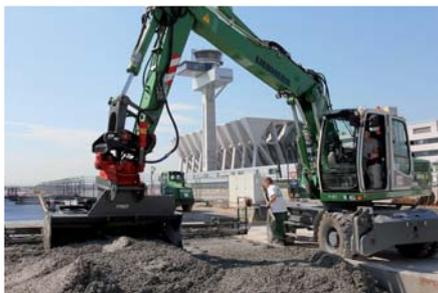
Zunächst wird die Funktion des Grabenräumlöffels zur gleichmäßigen Verteilung des frischen Betons eingesetzt.
