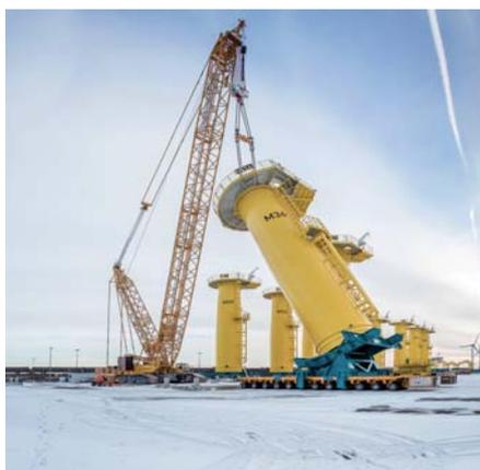
Die Haken des Krans werden am vorderen Teil der Ladung befestigt und angehoben, die IHT-Fahrzeuge können aus dem Verbund fahren.
