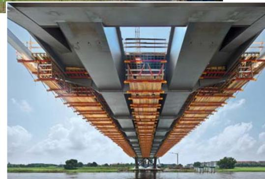
*Die für die 21 Betonierabschnitte konstruierten Gespärreinheiten basieren auf mietbaren Systemteilen des Variokit Ingenieurbaukastens.*
