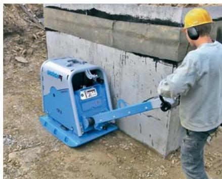
**Das Modell CR 8 MSM** ist eine von drei Rüttelplatten mit der Verdichtungskontrolle Compatrol. (Foto: Weber MT)
