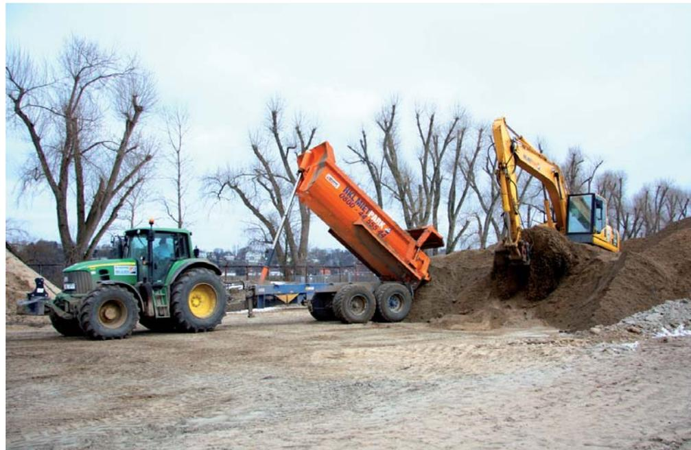
Ein Komatsu Kettenbagger PC 210 LC und ein John Deere 7530 Traktor mit Anhängemulde unterstützten den Tausch der kontaminierten Erdmassen. (Foto: HKL)
