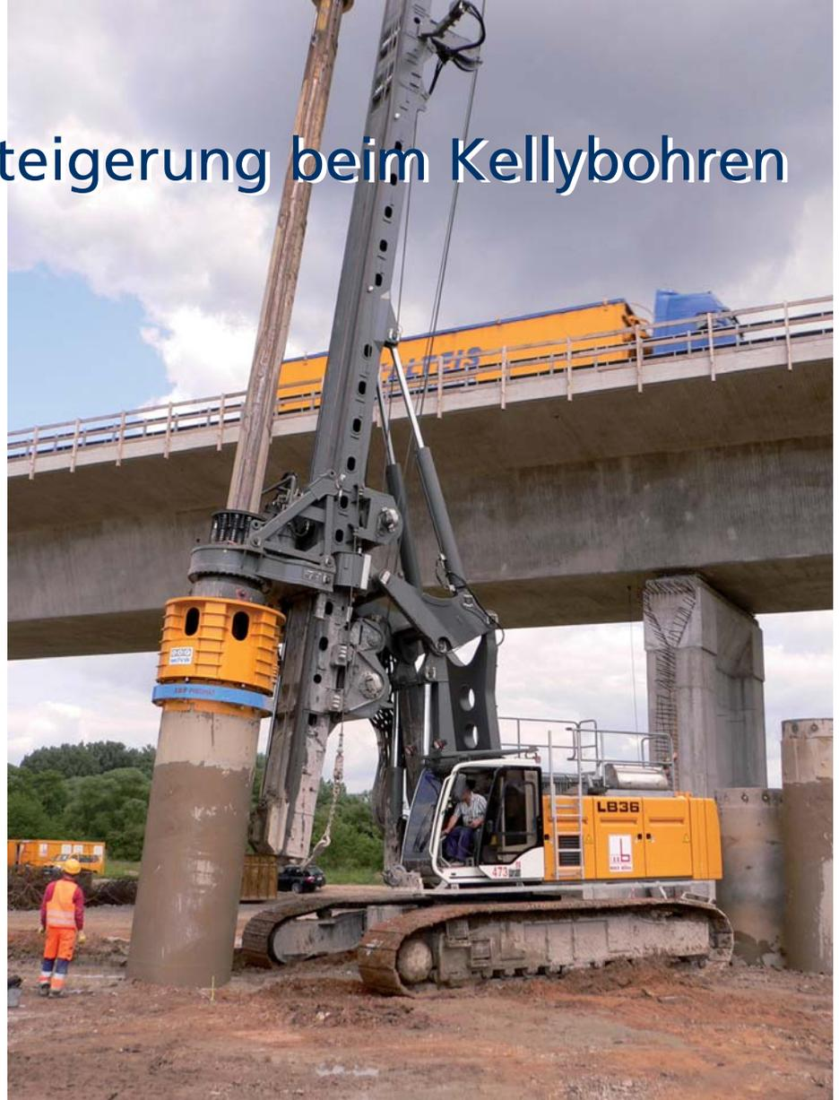
**Der ABF-Pneumat** wird mittels einer professionellen Sicherheits-Funkfernbedienung von der Kabine aus verriegelt. (Foto: ABF)
