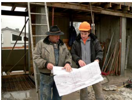
Luis Schneller absolviert im Berufskolleg für Bautechnik die Ausbildung zum Beton- und Stahlbetonbauer, hier im Gespräch mit seinem Ausbilder. (Foto: Bauwirtschaft BW)
