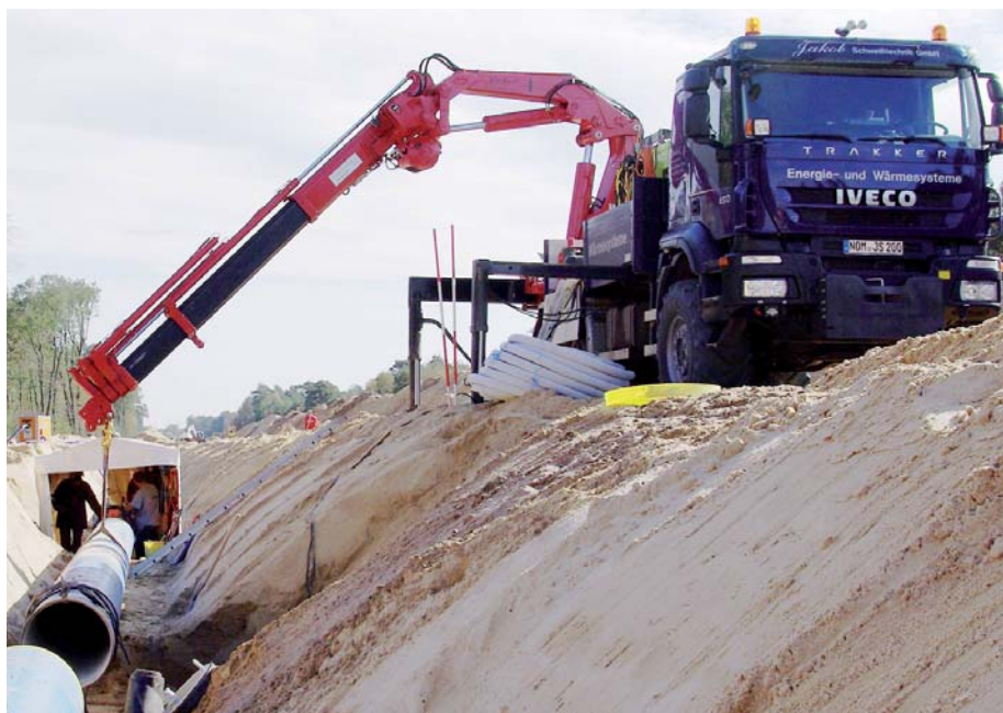
Selbst auf weichem Untergrund leistet der Iveco Trakker mit Hochleistungs-Einzelbereifung ganze Arbeit beim Verlegen der Trinkwasser-Fernleitung. (Foto: Iveco)
