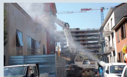
Bei innerstädtischen Abbrucharbeiten hat sich die dct40 als perfekte saubere Lösung bewährt. (Foto: Wansor)
