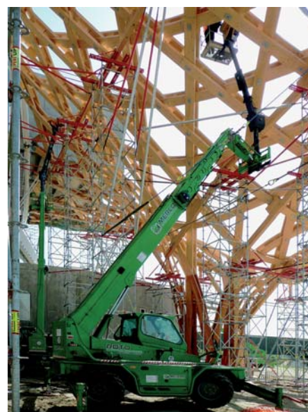
Alle Grundmaschinen hatten einen artikulierten Aufbau mit einem auf einem automobilen Unterwagen voll durchschwenkbaren Oberwagen. (Foto: Merlo)
