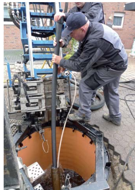
Hier folgt der Einschub der Erdwärmesonden in die Bohrung. (Fotos: TractoTechnik)
