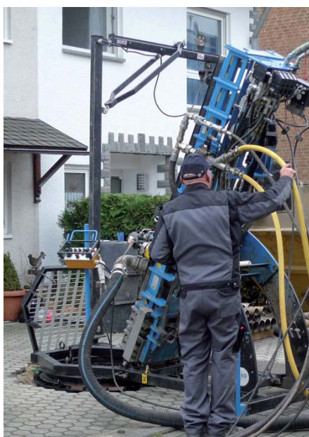
Die Bohrung mit der GRD-Bohranlage erfolgt nur wenige Meter vor der Haustür.
