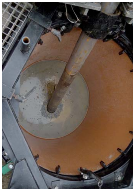
Vom Schacht aus werden sechs Bohrungen in den Boden vorgetrieben.
