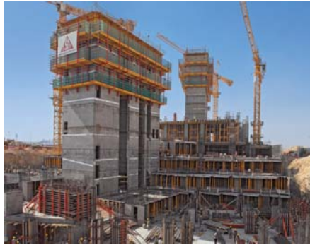
Für die Errichtung von fünf Hochhauskernen des neuen Finanzzentrums Saudi-Arabiens liefert Peri Kletterschalungen. (Foto: Peri)
