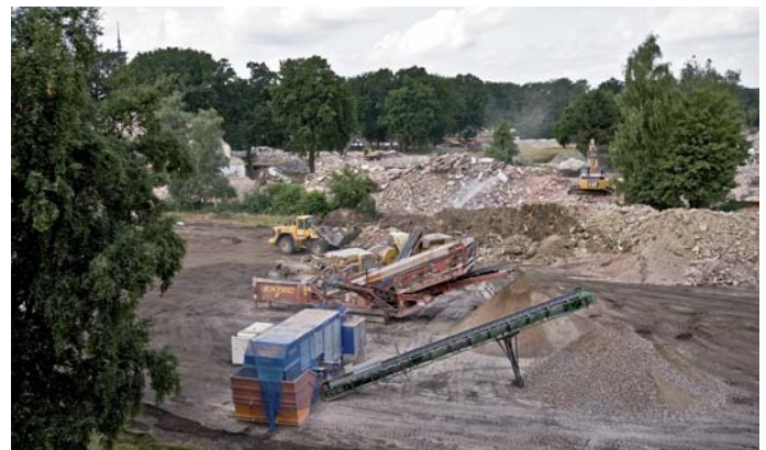
Die Abbruchmassen wurden direkt vor Ort mittels Brech- und Siebanlagen aufbereitet. (Fotos: Moß)
