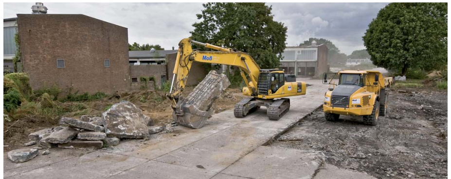
Der Kasernenabbruch war eine Herausforderung, die mit schwerer Technik und planerischem Können gemeistert wurde.
