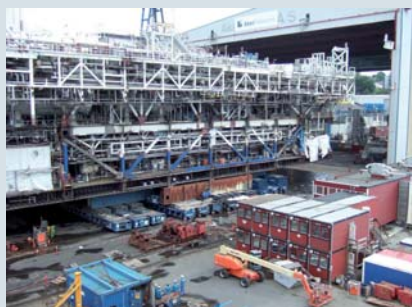
Schwerstarbeit: Die gigantische Anlage wird aus der Produktionshalle gefahren. (Foto: Scheuerle)
