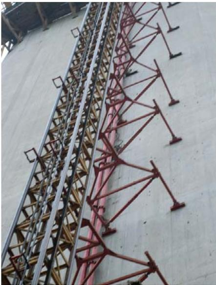
Die Hochdruck-Betonförderleitung ist an der Außenwand der über 300 m hohen Pylone befestigt. (Fotos: Putzmeister)
