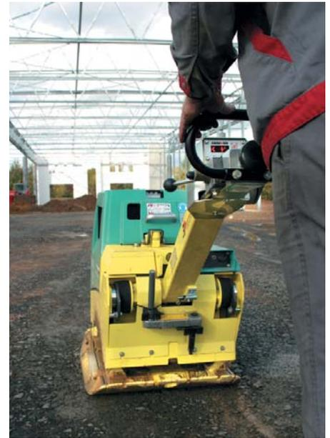
Sicherheit während der Verdichtung und verwendbare Messergebnisse danach – das sind die Vorteile der Intelligenten Rüttelplatte.
