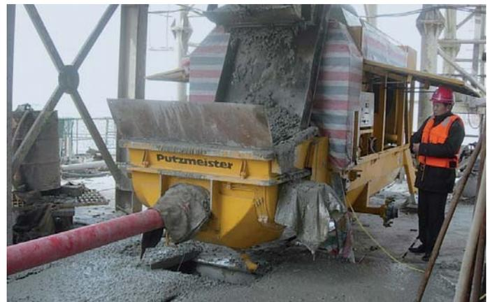
Eine Putzmeister Hochdruck-Betonpumpe BSA 14.000 HP-D. Man beachte die Beton-„Schüttung“.
