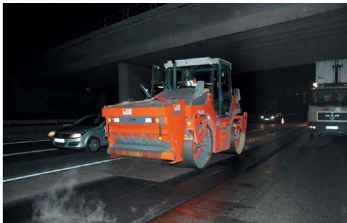
Für optimale Anfangsgriffigkeit waren zwei Walzen mit einem Präzisionsstreuer ausgestattet. Sie verteilen den bituminierten Splitt gleichmäßig auf der Fahrbahn.
