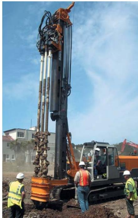
Das Bohrgerät MG 15 wurde vorrangig für den japanischen Markt entwickelt. Es arbeitet mit zwei Hatz-Motoren des Typs 4L41C mit Schallschutzkapsel. (Foto: Bauer)
