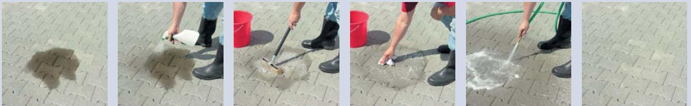
Den vorhandenen Ölfleck mit Kleenoil ASB R6 einsprühen, die Lösung einarbeiten, überschüssige Flüssigkeit abtupfen, gegebenenfalls mit Wasser abspritzen und fertig. Der Ölfleck ist weg. (Fotos: Kleenoil Panolin)
