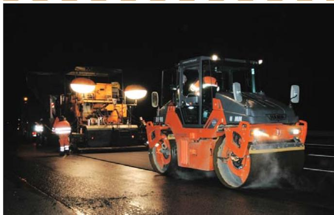
Dünne Asphaltdeckenschichten, wie hier der DSH-V-Belag, kühlen schnell aus. Das erfordert eine besonders effektive Verdichtung. Hierfür eignen sich Walzen von Hamm mit Oszillationsbandagen besonders gut.
