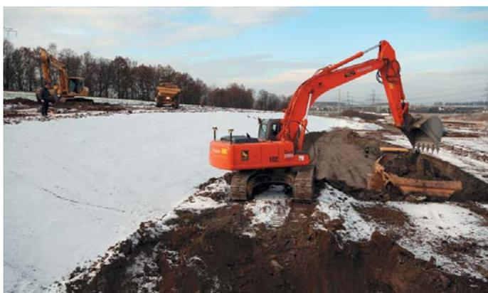
Durch das plangenaue Vermessen dank GPS-Steuerung erfolgt der Ausbau der A72 zwischen Chemnitz und Leipzig schneller als gedacht.
