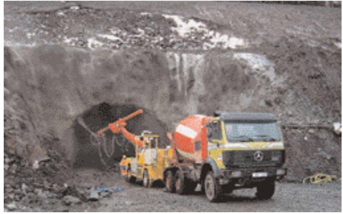
Spritzbeton-Auftrag mit einer Putzmeister Wetkret WKM 103 am Portal eines Zwischenangriff-Stollens.
