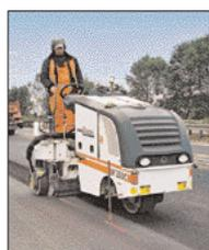
Top-Leistung ist keine Frage von Größe: Extrem kompakt ist die neue W 35 DC mit ihrer Antriebsleistung von 42,5 kW. Beim Freifräsen von Kanaldeckeln, partiellen Fahrbahnreparaturen, Hallensanierungen, Markierungs- und Demarkierungsarbeiten kommt die W 35 DC mit ihrer Fräsbreite von 350 mm und einer Frästiefe bis zu 110 mm groß raus. Knifflige Spezialaufgaben sind ihr Terrain, denn durch ihre „Größe“ ist sie dafür wie geschaffen. Und das geht nicht auf
