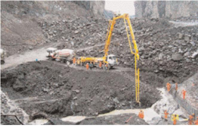
Bei kleineren Betonagen wird eine BRF 36.14 H eingesetzt.
