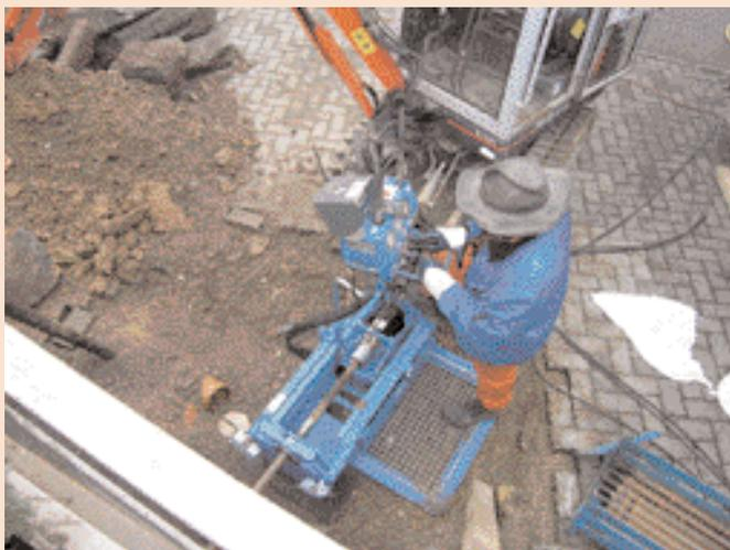
Bohrgerät Grundopit in Arbeitsposition.
