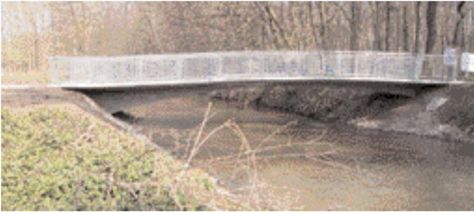
Brücke Gaulis: Pilotprojekt für die Anwendung von SVB im Brückenbau.
