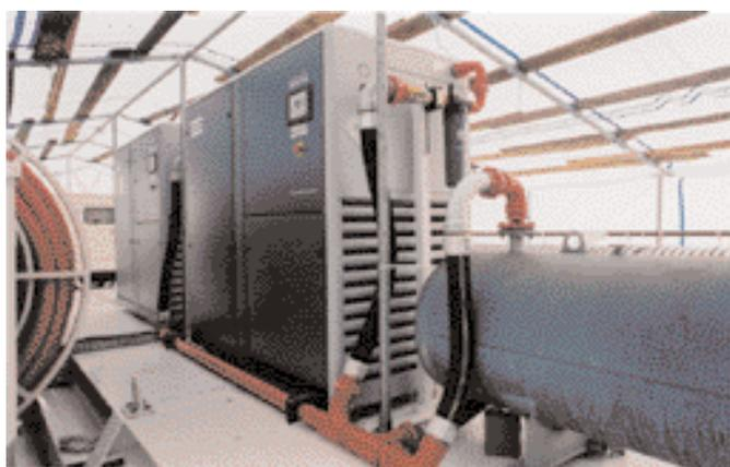
Schaumlufte liefern diese beiden Schraubenkompressoren.
