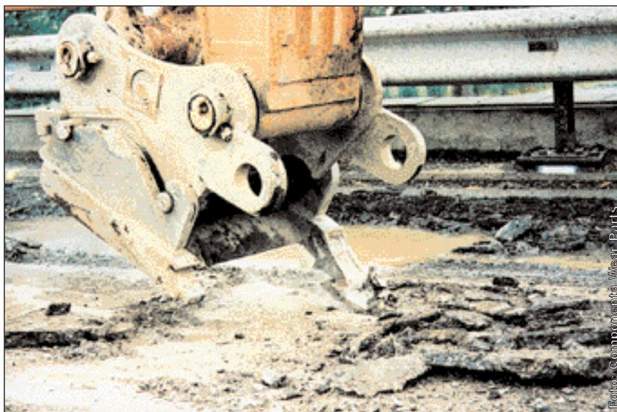
Mit dem neuen Bagger-Anbauwerkzeug, dem Asphalthobel, wird die Verschleißschicht in Schollen vom Beton-Unterbau abgelöst.
