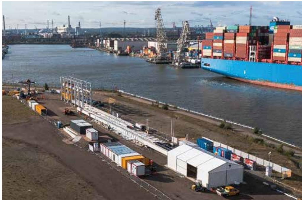
**Volle Kraft:** Ein Bredenoord Batteriespeicher lässt Container des Max Bögl Transportsystems auf der Teststrecke im Hamburger Hafen schweben. (Fotos: Bredenoord)
