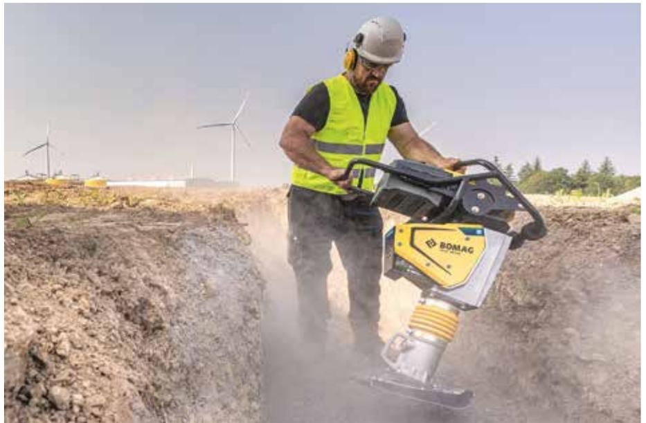
**Ein deutlicher Vorteil:** Der batterie-elektrische BT 60 e von Bomag erreicht die gleiche Leistung wie der konventionelle Stamper, hält aber strikte Emissionsgrenzwerte ein. (Foto: Bomag)
