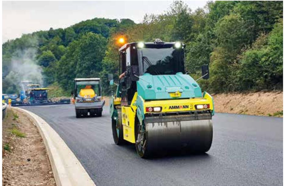
**Erfolgreicher Test:** Zwei Ammann-Tandemwalzen ARP 95, ausgestattet mit dem Verdichtungsmess- und Regelsystem ACEpro und dem flächendeckenden Dokumentationssystem von Q-Point / Völkel, konnten bei den Raumdichte-Messungen der FGSV überzeugen. (Foto: Ammann)
