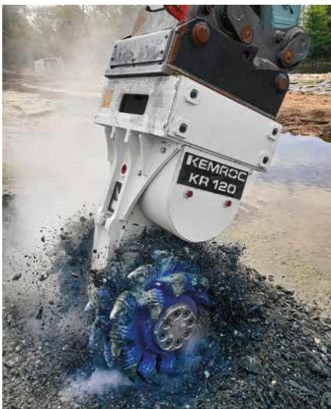
Gestein abtragen an einer historischen Wehranlage mit der Querschneidkopfräse KEMROC KR 120 – präzise und ohne schädliche Erschütterungen am Bauwerk. (Foto: Kemroc)
