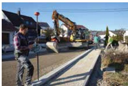
**Arbeitserleichterung:** Polier Klaus Schnitzer sieht die flächendeckende Verdichtungskontrolle einen wesentlichen Vorteil einer BIM-gestützten Bauausführung.
