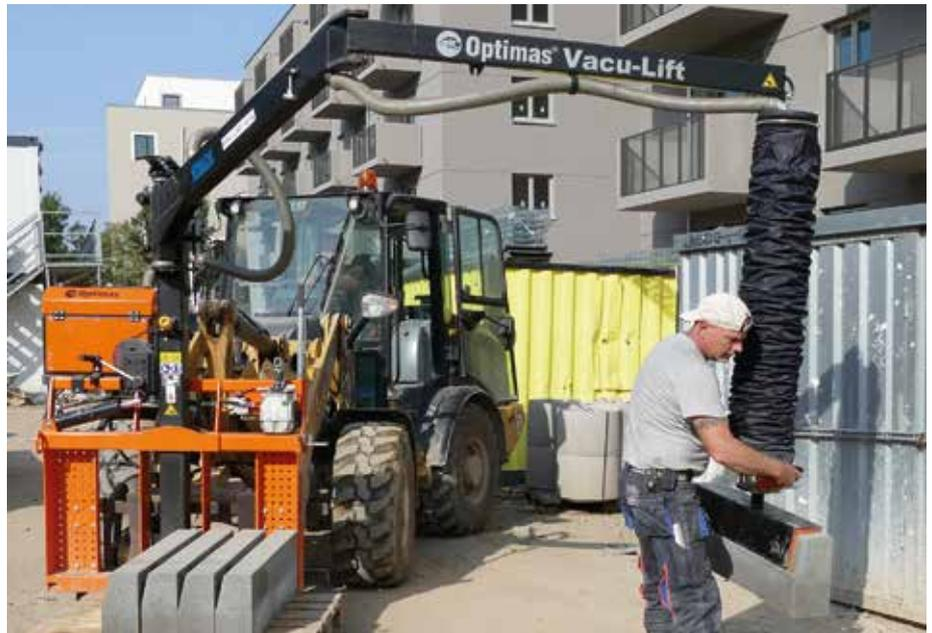
**Stark:** Quasi mit zwei Fingern und ohne den Einsatz von Körperkraft können die Bauarbeiter mit dem Optimas Vacu-Lift 120 kg schwere Betonteile bewegen. (Foto: Optimas)
