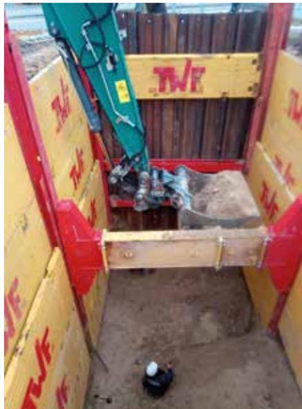
**Gut geplantes Projekt:** Beim Ersatzneubau eines Gebäudes in Wismar wird die Arbeitsebene für die Rohrvortriebsmaschine, in der Startgrube hergestellt.
