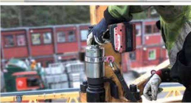
Dreherschrauber ADS 600 Eckstielverbindung M45, M<sub>A</sub> = 5.850 Nm
