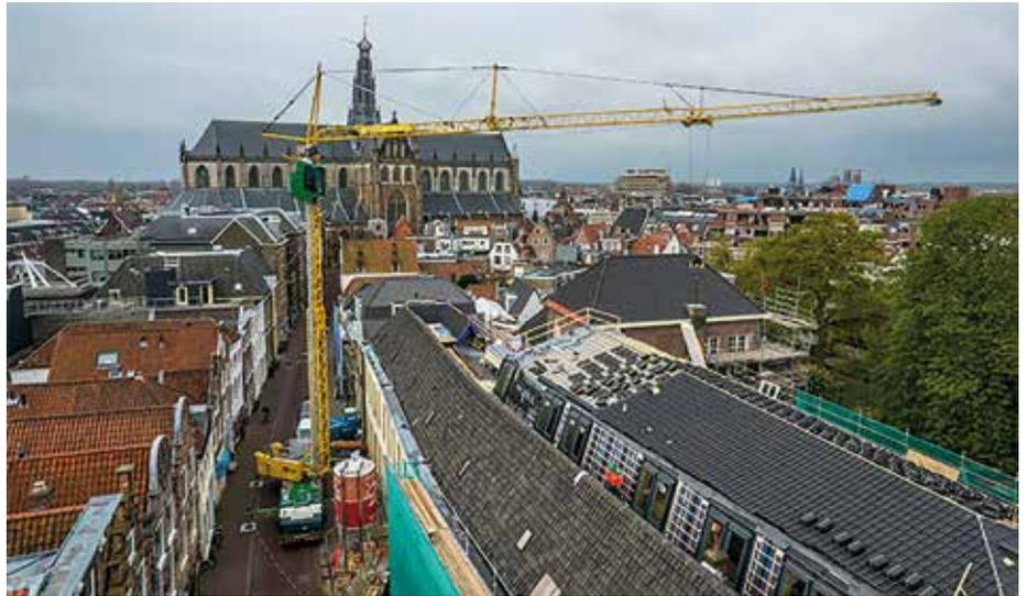
**Findet die Lücke:** In dicht bebauten Innenstädten, wie bei einem Einsatz in Haarlem, überzeugt der Mobilkran MK 73-3.1 mit kompakten Maßen und großer Reichweite. (Fotos: Liebherr)
