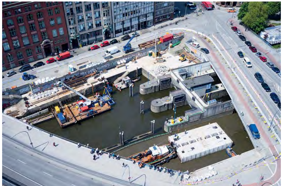
Einbau unter laufendem Verkehr: Durch die gezeitenabhängigen Wasserstände kann unter Brücken nur in sehr begrenzten Zeitfenstern gearbeitet werden. (Foto: HOCHTIEF/Sky View Imaging)
