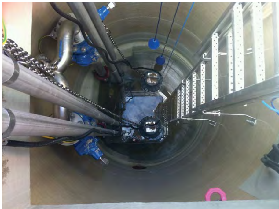
Xylem-Abwasserlösungen in Isernhagen: der Top 3D-Schacht mit selbstreinigender Pumpe und innovativer MyConnect-Steuerung. (Foto: Xylem)
