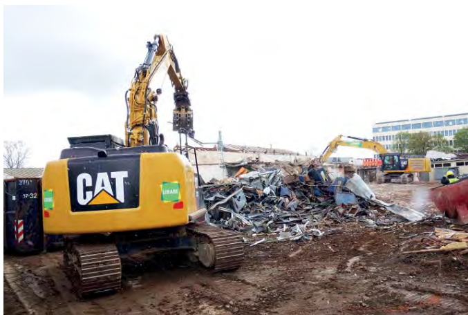
Teamwork: Das Verladen ist Sache eines Kurzheckbaggers 320E LRR, der dem Hybridbagger zuarbeitet.
