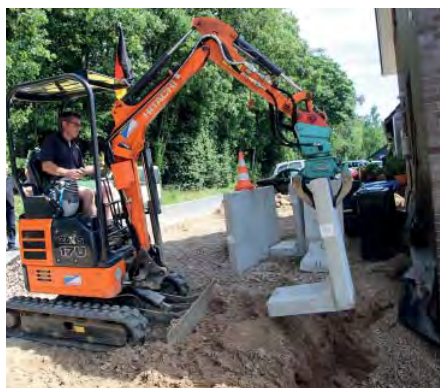
Verlegt selbst schwere Steine: Durch den Umbau sind den Einsatzmöglichkeiten des Minis kaum Grenzen gesetzt. (Foto: Kiesel)
