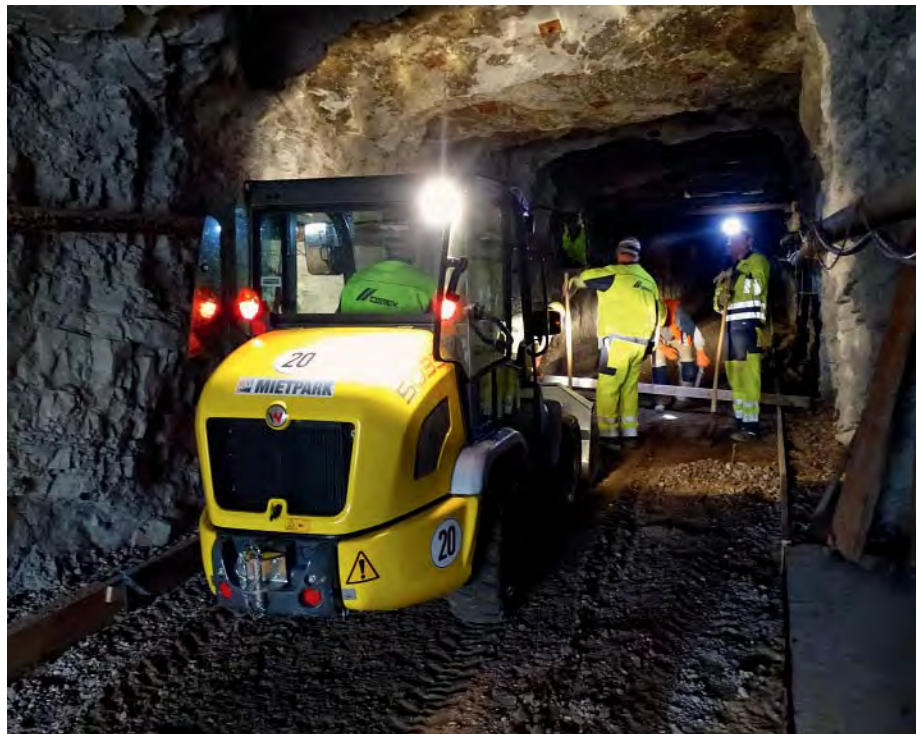
Ein gemieteter Radlader unterstützt bei der Begradigung des Zufahrtsbereichs des Stollens und transportiert das aufgenommene Material nach außen. (Foto: HKL Baumaschinen)
