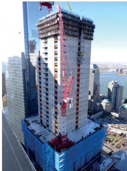
Der Kran musste sehr dicht an den Stahlbetonkern platziert werden, was seine Bewegungsfreiheit stark einschränkte. Während seines Einsatzes kletterte er mit dem Gebäude auf insgesamt 300 m Höhe. (Foto: Wolffkran)
