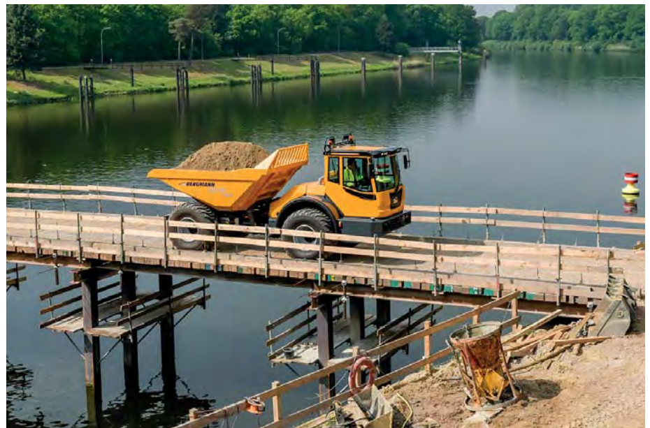
Die Kabine des Dumpers 3012 bietet mit dem in dieser Klasse einzigartigen drehbaren Fahrerstand eine gute Sicht auf den Arbeitsbereich. (Foto: Bergmann)
