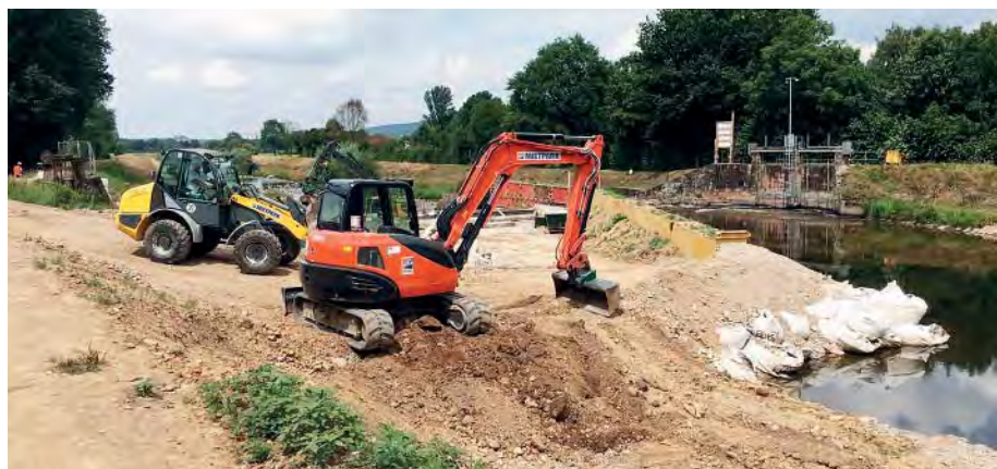
Ein gutes Team: Gemietete Radlader und Kompaktbagger helfen bei der Sanierung des Kollmarsreuter Wehrs. (Fotos: HKL Baumaschinen)
