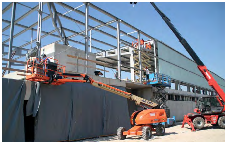
Eingespieltes Quartett: die Cramo-Arbeitsbühnen und -Teleskoplader bei der Montage der Stahl-Dachelemente auf dem neuen Jugend-Trainingsgelände. (Foto: Cramo)
