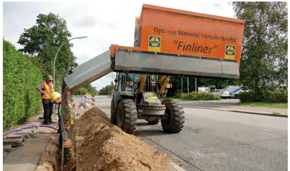
Das Material lässt sich exakt dosieren und verteilen. Der Radlader fährt parallel zum Kabelkanal, das verkürzt das Verfüllen enorm.
