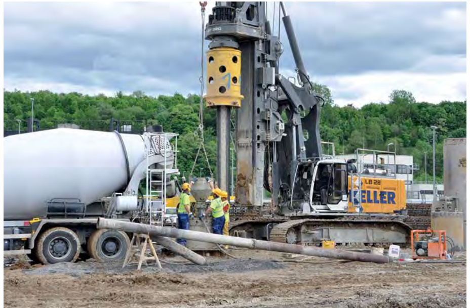
Rückbauzentrum für Kernkraftwerke: Die Gründungsarbeiten in Neckarwestheim erfolgen mit leistungsstarken Drehbohrgeräten. (Foto: Liebherr)
