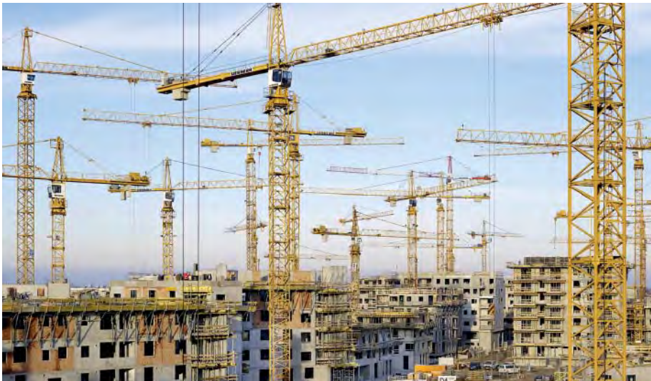
Insbesondere im innerstädtischen Bereich kann nur in den seltensten Fällen ein Kran so aufgebaut werden, dass er nicht mindestens ein Nachbargrundstück überschwenken muss.
