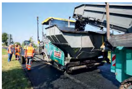
Das Mischgut wird auf den Beschicker verladen, dieser füllt es dann in den Kübel des Fertigers. Dahinter rollt bereits die Walze zur Verdichtung an.
