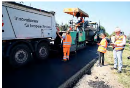
Die Temperatur des Mischguts wird permanent kontrolliert: Spezielle Thermocontainer sichern eine gleichbleibende Temperatur für einen nachhaltigen Einbau.
