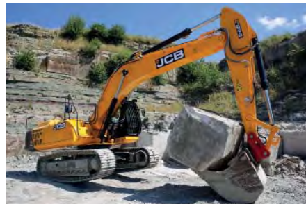
Mit wenigen Bewegungen wird der Sandsteinblock auf den Baggerlöffel genommen. Selbst unter der Last dieses rund 15 t schweren Sandsteinblocks lässt sich der Bagger punktgenau steuern und manövrieren.
