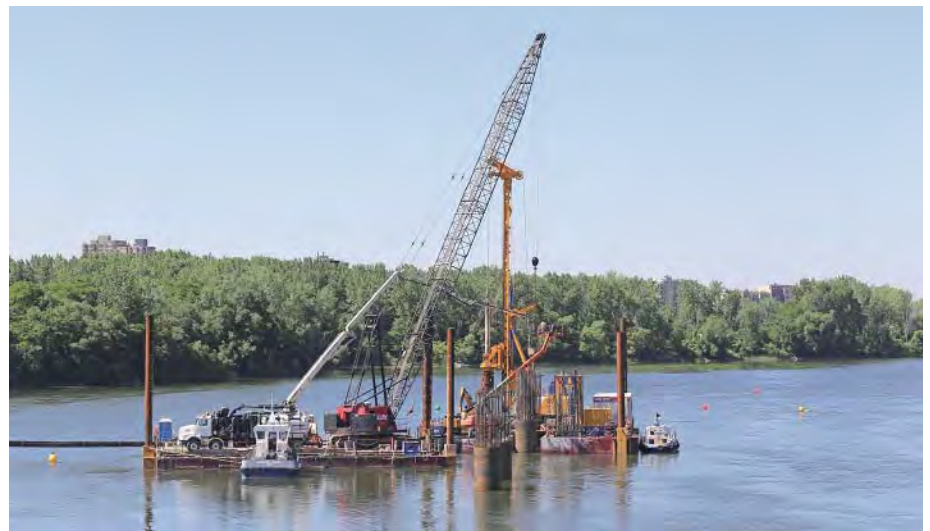
Brückenbau in Montreal: Bauer stellte insgesamt 200 Gründungspfähle her, zehn davon offshore im St. Lawrence River. (Foto: Bauer-Gruppe)
