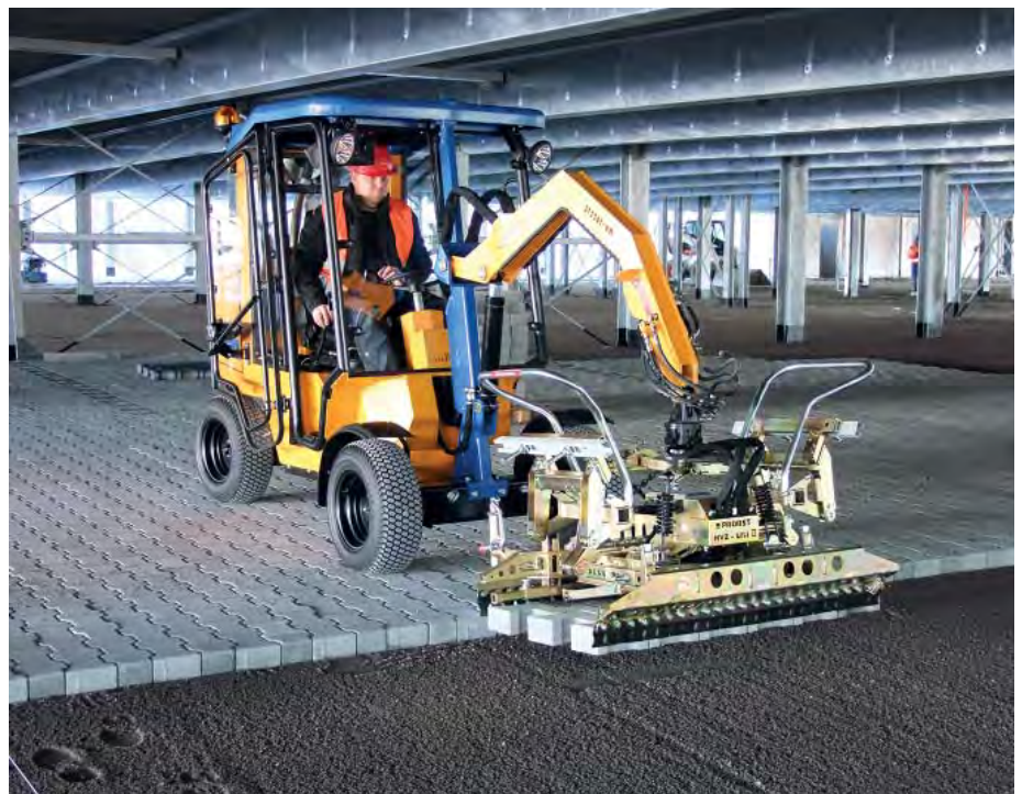
Die Verlegemaschine VM-301-K-Pavermax in Verbindung mit der dazugehörigen hydraulischen Verlegezange HVZ-Uni-II überzeugte beim Einsatz im Parkhaus. (Fotos: Probst)
