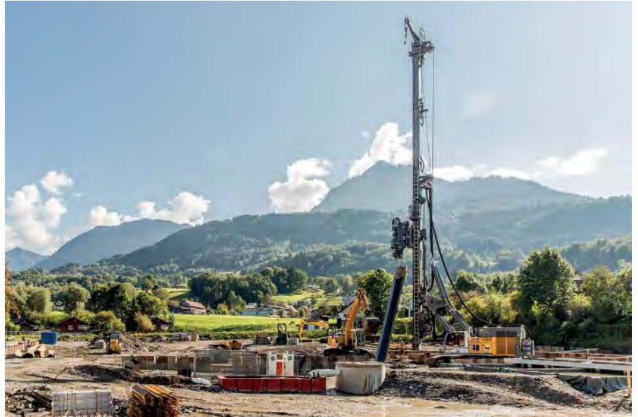
Vielseitig: Neben dem Setzen von Spundwänden mit einem Rüttler eignet sich das LRB 355 auch für alle gängigen Bohrverfahren sowie Bodenmischen und Einsätze mit Hydraulikhammer. (Foto: Liebherr)
