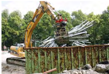
Zwischendurch sortieren – mit dem Schnellwechselsystem rechnet sich der häufige Werkzeugwechsel.
