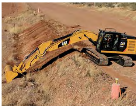
Der Cat 323F L ist mit integrierter 2D-Maschinensteuerung und erstmals mit halbautomatischer Planiersteuerung Grade mit Assist verfügbar. (Foto: Caterpillar / Zeppelin)
