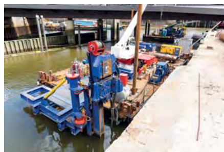
Spezialkonstruktion: Der Mätkler wird dieselhydraulisch angetrieben und ist für das Einbringen der Lot- oder Schrägtragrohre individuell verstellbar. (Foto: HOCHTIEF)
