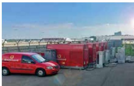
**All inclusive:** Der Bredenoord Service lieferte die Geräte, Kabel, Verteiler und zwei Kraftstofftanks mit dem firmeneigenen Lkw, lud alles ohne Hilfe ab und legte die ersten Anschlüsse.
