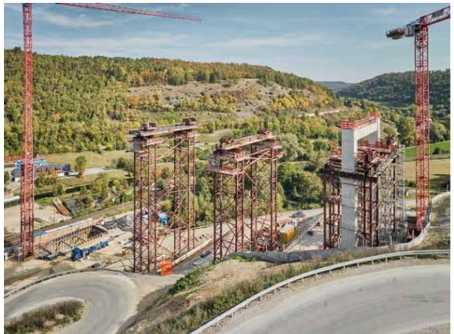
**Beachtlich:** Die Montage des bodengestützten Traggerüsts vermittelt einen ersten Eindruck von der Höhe der Brücke. (Foto: Porr)
