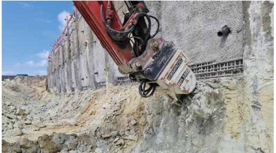
**Perfekt:** Die Kemroc-Fräse KR 120 ist bestens für Profilierungsarbeiten in der Baugrube der „Königsteiner Höfe“ geeignet. (Fotos: Kemroc)
