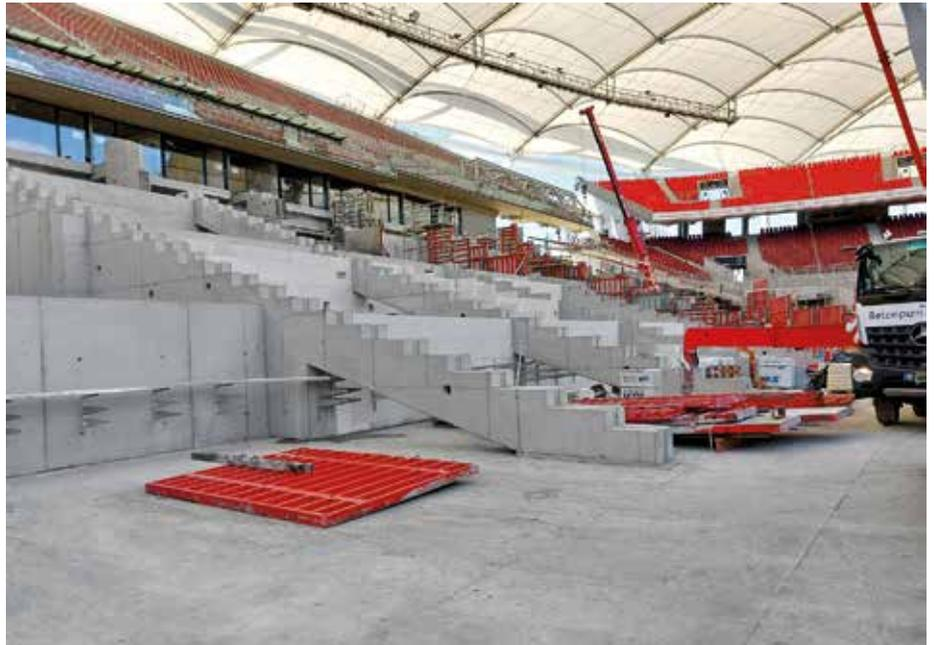
**Durchdachte Lösung:** Die Zahnbalken wurden aus Platzgründen vor Ort betoniert und dienen als Querträger für Tribünenflächen aus Fertigbetonelementen.
