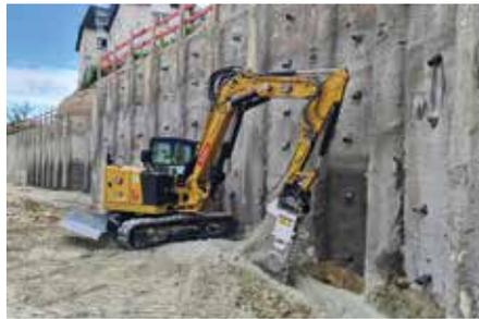
**Präzise:** Am Fuß der Bohrpfahlwand wird mithilfe einer Kettenfräse EK 40 von Kemroc rundherum ein Drainagegraben geöffnet.
