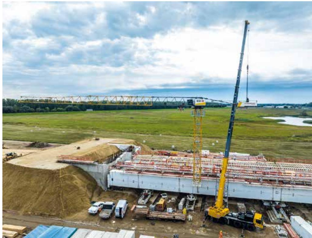
**Komplexer Bauprojekt:** Aufbau des Turmdrehkran 125 EC-B6 von Hüffermann, der beim Neubau der Elbbrücke Wittenberge hauptsächlich zum Anheben von Betonteilen und Schalung eingesetzt wird. (Fotos: Liebherr Tower Cranes)
