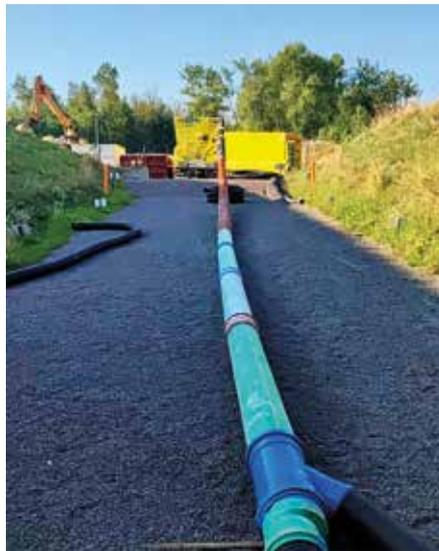
**Lange Leitung:** Der Saugbagger-Einsatz der SBW GmbH in Delitzsch umfasste Distanzen von bis zu 60 m. (Fotos: SBW GmbH)
